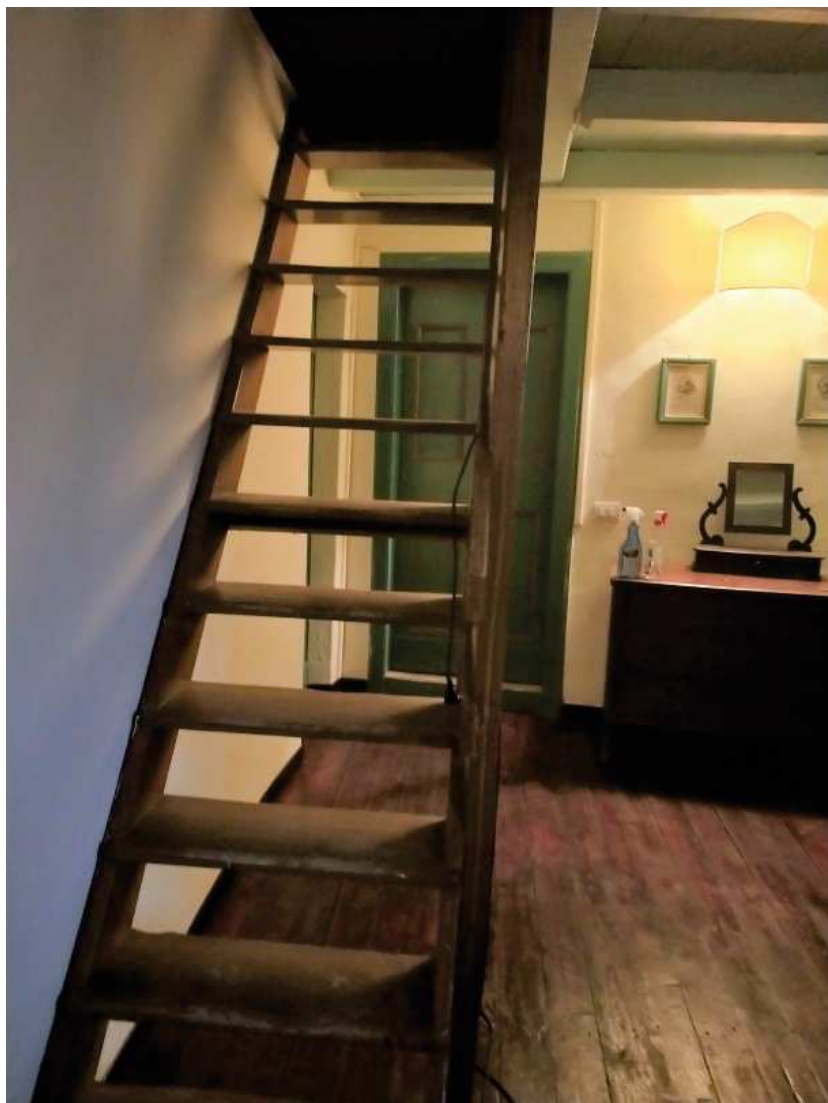
SCALA ACCESSO SOTTOTETTO
