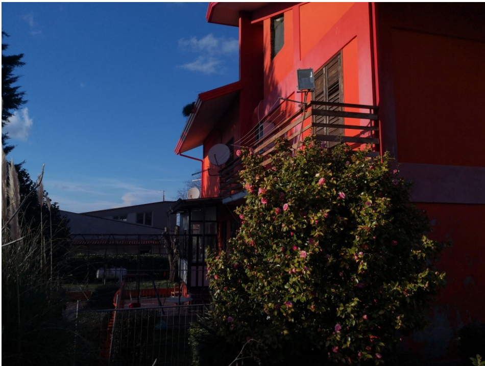
(vista lato Ovest)
