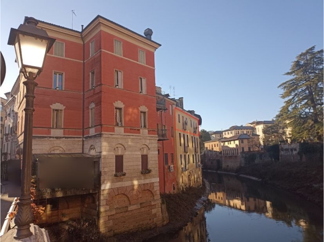
Fotografia 1 – dal ponte di Contrà Ponte San Paolo
