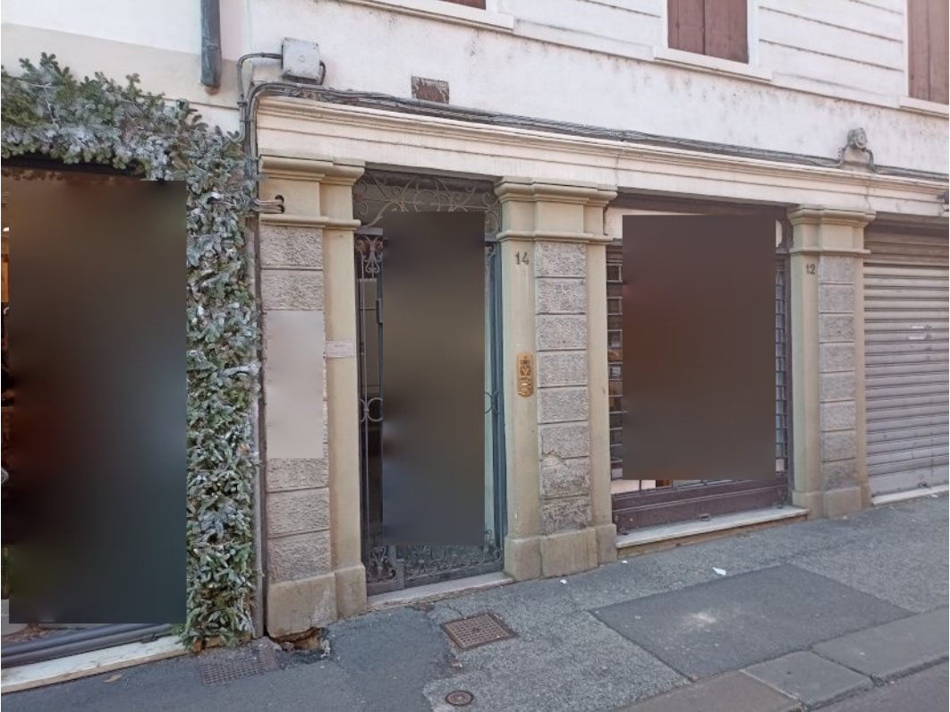
Fotografia 2 – Ingresso condominiale da Contrà Ponte San Paolo
