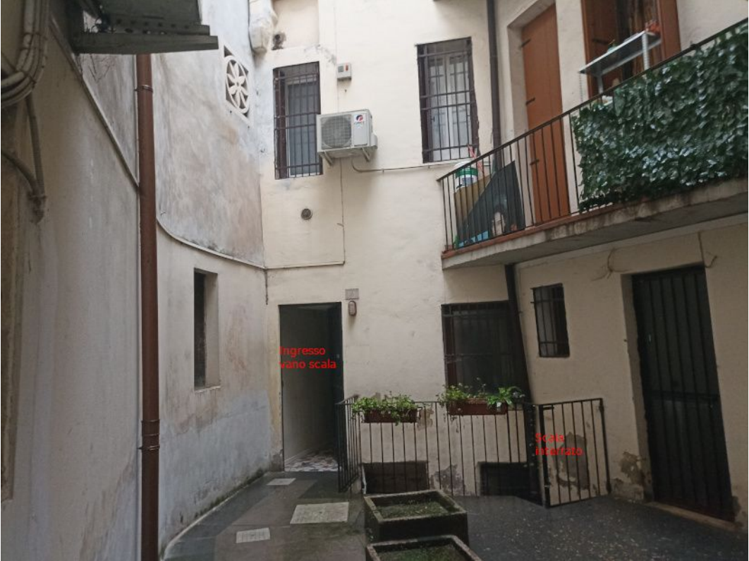
Fotografia 3 – ingresso vano scala da cavedio interno
