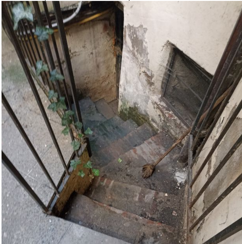
Fotografia 10 – scala interrato (vedi indicazione foto 3)
