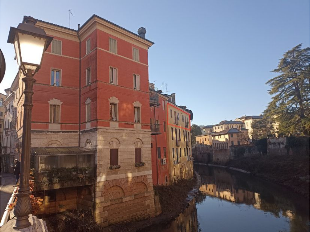
Fotografia 1 – dal ponte di Contrà Ponte San Paolo
