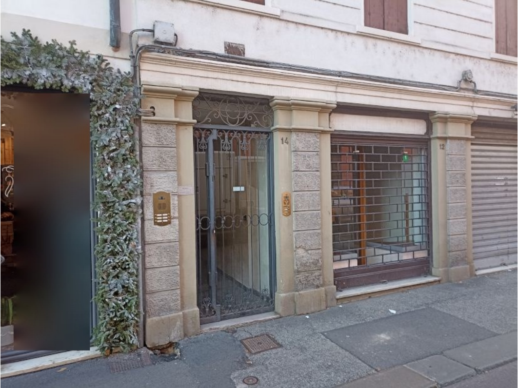
Fotografia 2 – Ingresso condominiale da Contrà Ponte San Paolo
