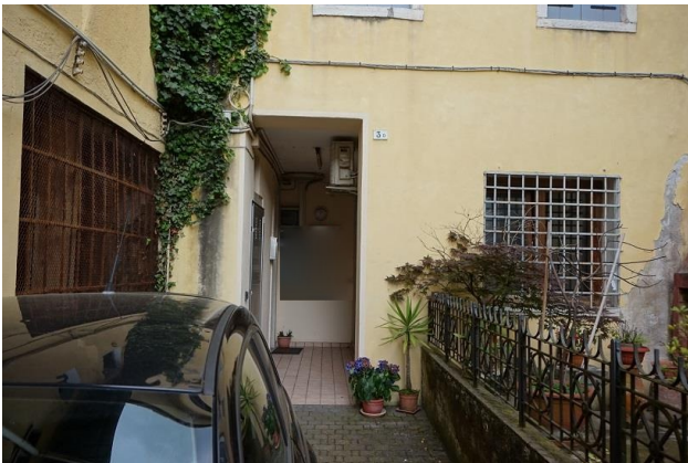
Particolare ingresso est fabbricato da corte interna
