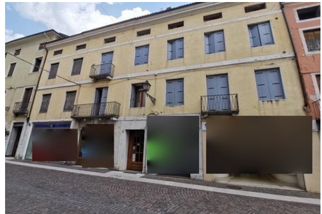
Fronte ovest fabbricato visto da sud Corso Italia
