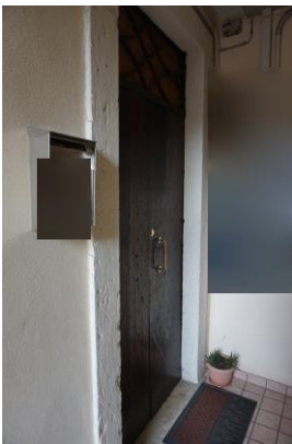
Piano terra - Vista portone d'ingresso comune a nord
