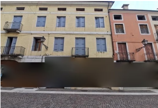
Vista fronte ovest fabbricato da Corso Italia
