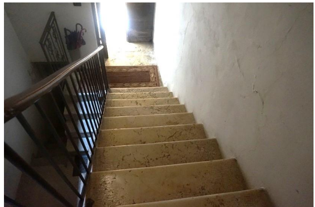
Particolare prima rampa scala comune da piano terra
