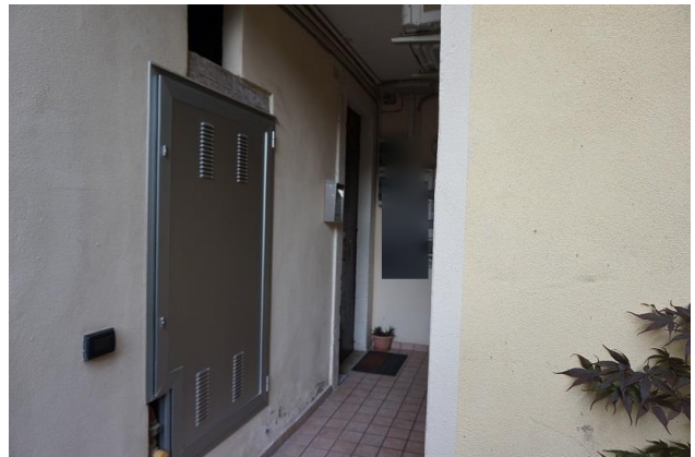
Vista ingresso comune di accesso al fabbricato
