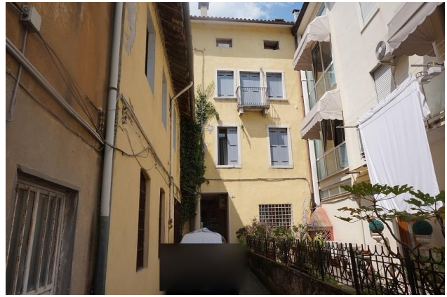
Ingresso est al fabbricato da corte interna
