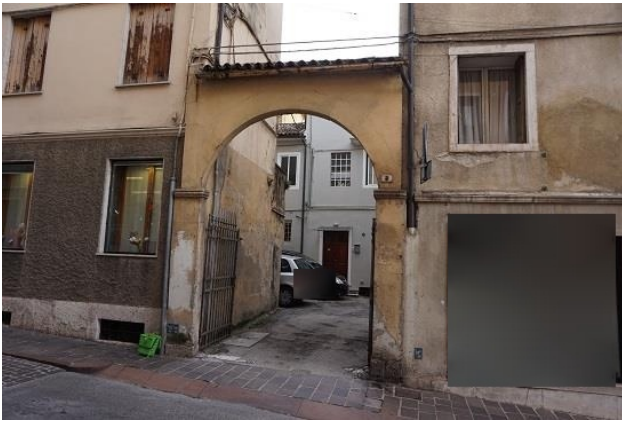
Ingresso corte interna da via IV novembre a sud
