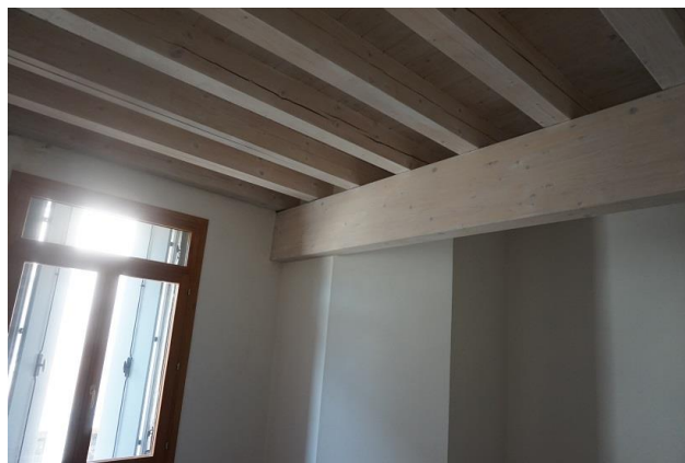
Piano primo – Particolare soffitto camera
