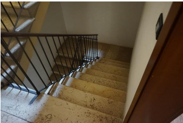
Piano primo - Particolare scala comune
