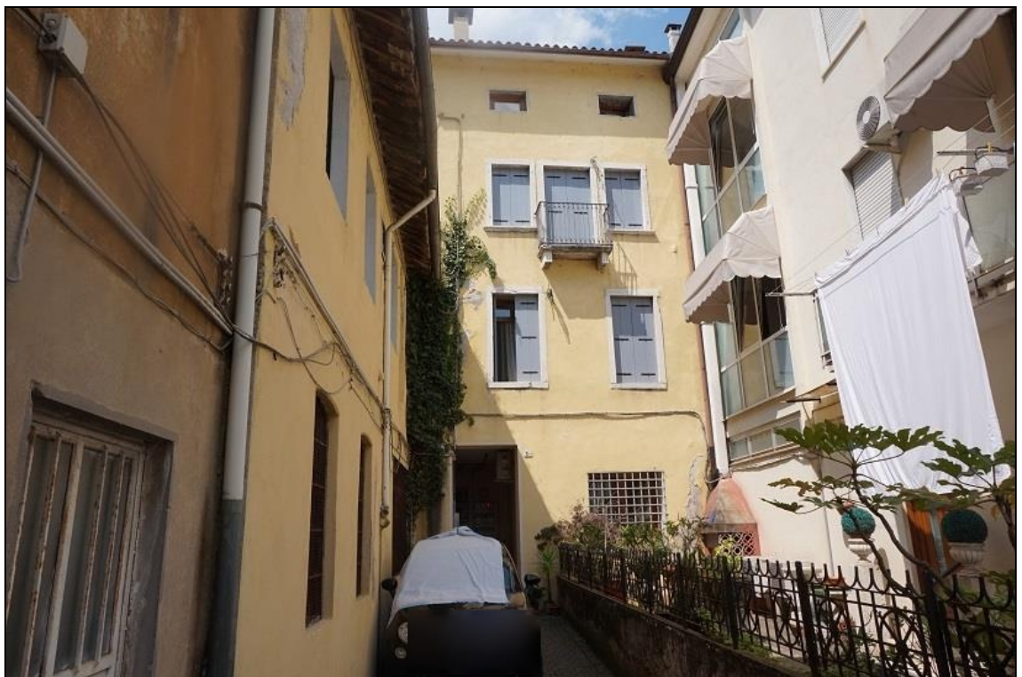
FOTO 6 – Ingresso est al fabbricato da corte interna
