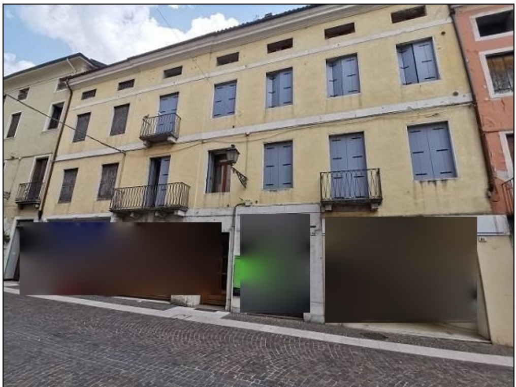
FOTO 2 – Fronte ovest fabbricato visto da sud Corso Italia
