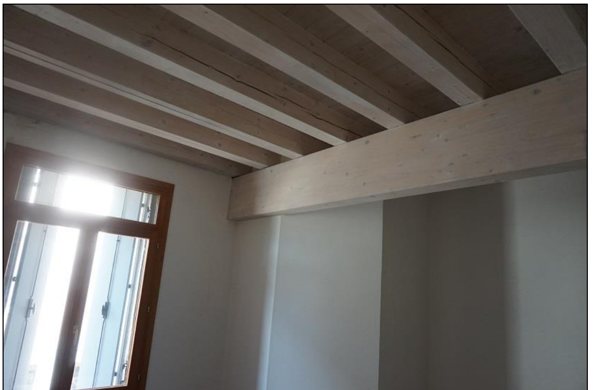
FOTO 22 – Piano primo – Particolare soffitto camera
