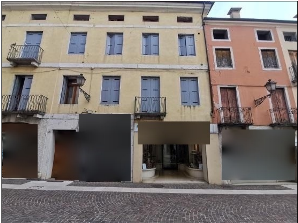
FOTO 1 – Vista fronte ovest fabbricato da Corso Italia
