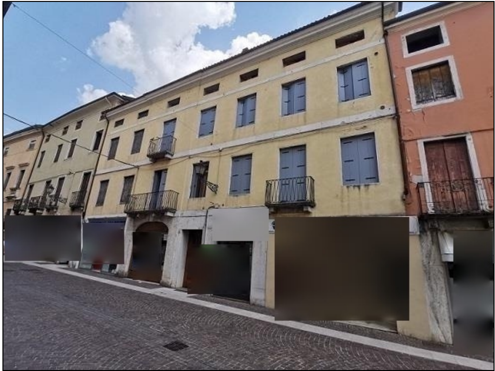
FOTO 3 – Vista d'insieme fronte ovest da Corso Italia
