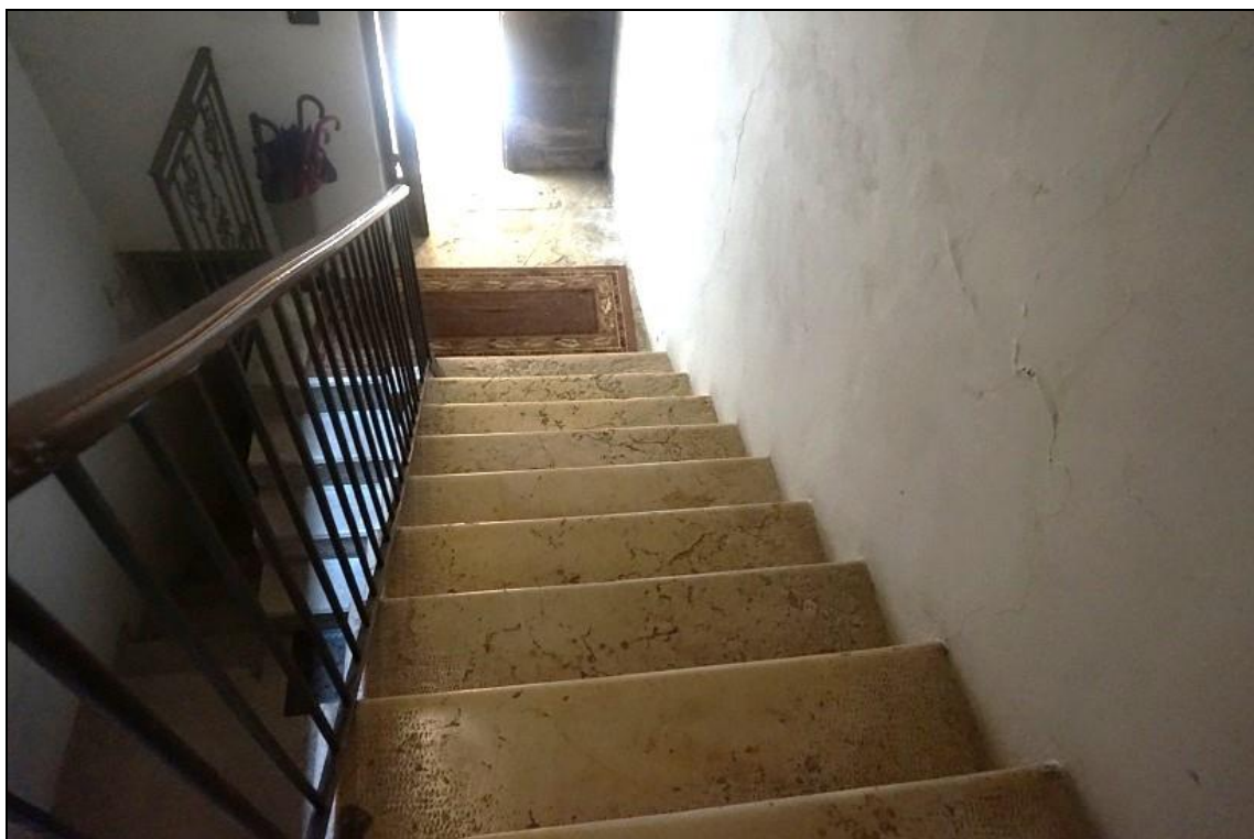
FOTO 10 – Particolare prima rampa scala comune da piano terra
