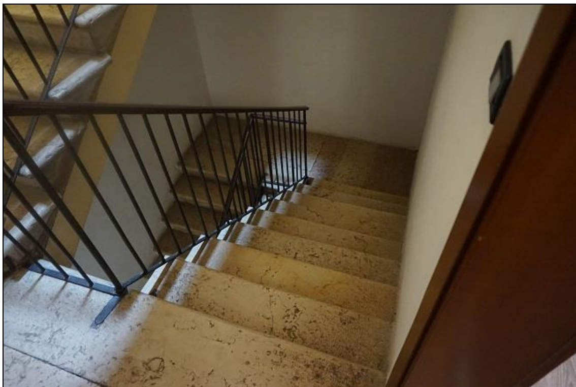
FOTO 11 – Piano Primo – Particolare scala comune
