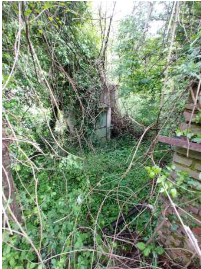
- FOTO 37 - Manufatto in muratura e scorcio del forno (sulla destra) a nord-ovest
