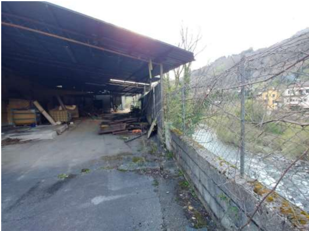
- FOTO 8 - Tettoie lato Lima
