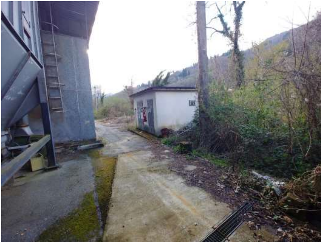
- FOTO 32 - Cabina elettrica
