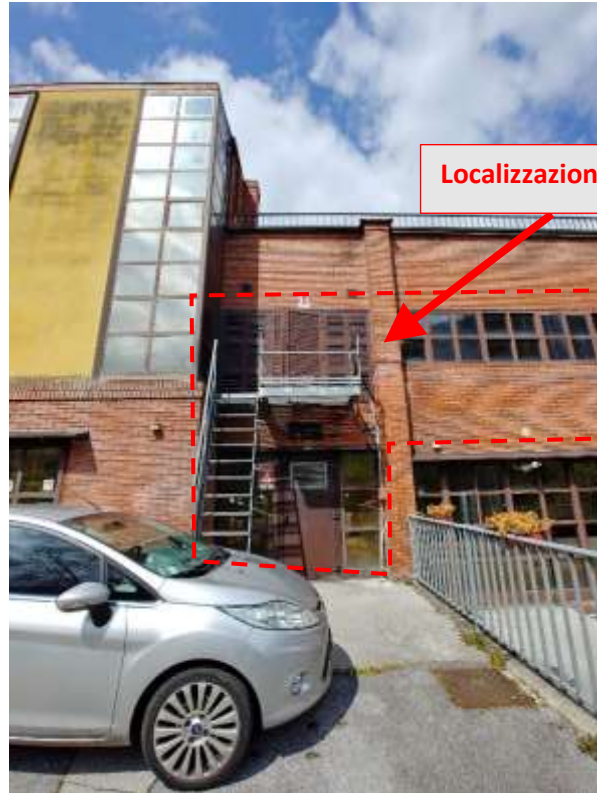
- FOTO 96 - Individuazione locali tecnici al p.t. e 1°p.
