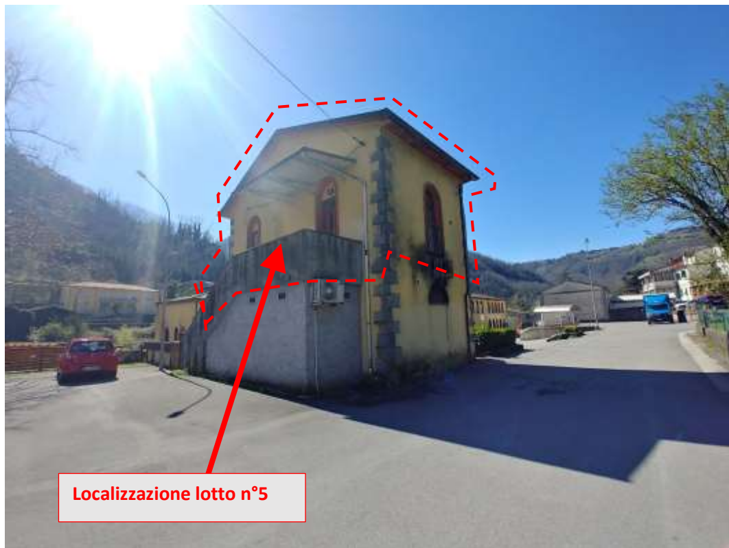
- FOTO 129 - Vista da nord
