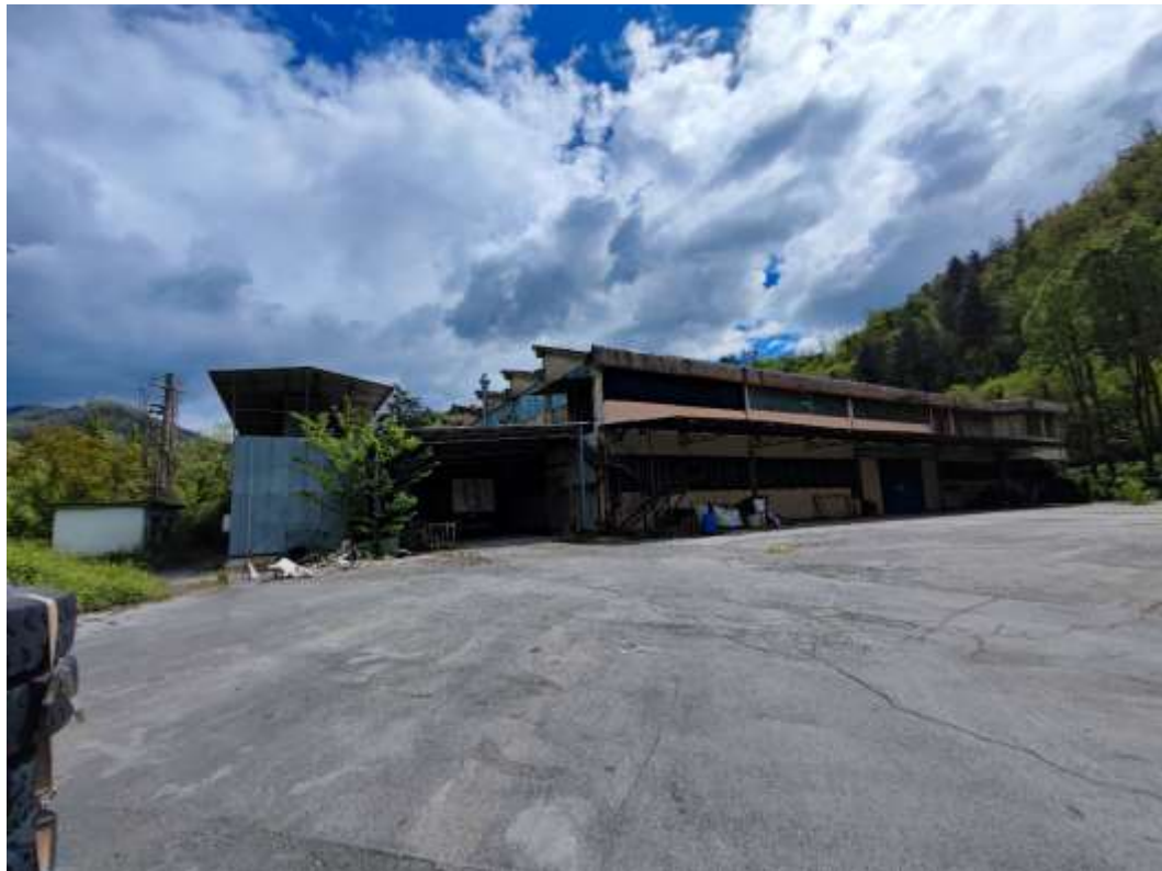
- FOTO 4 - Vista da nord-ovest
