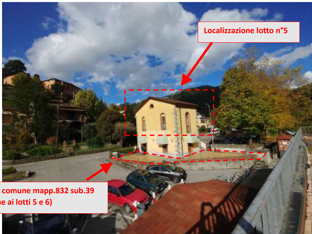
- FOTO 128 - Vista da sud
