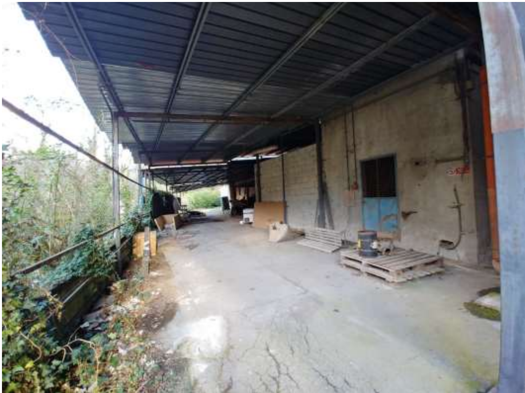
- FOTO 34 - Tettoie lato Lima
