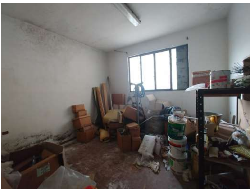
- FOTO 20 - Ripostiglio p.t.
