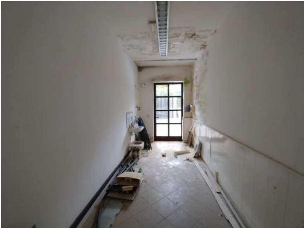
- FOTO 195 - Vano 1A lotto 9 porzione "A"
