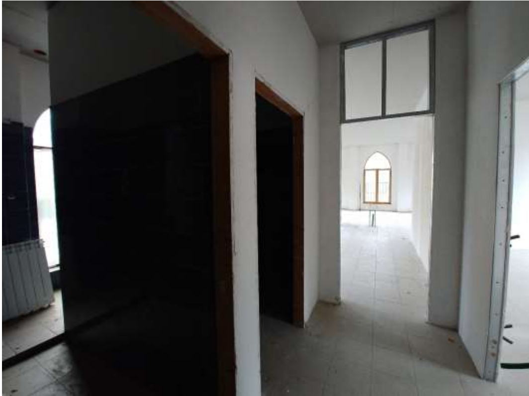
- FOTO 109 - Disimpegno mapp.832 sub.32
