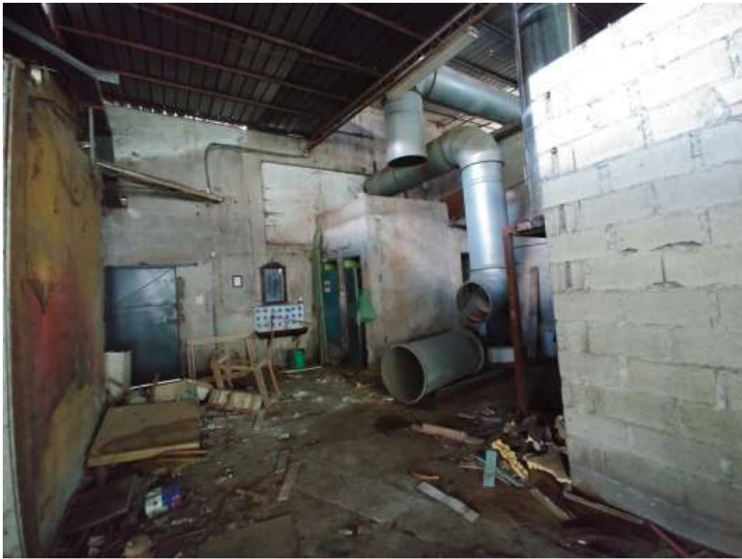
- FOTO 33 - Servizi igienici lato Lima
