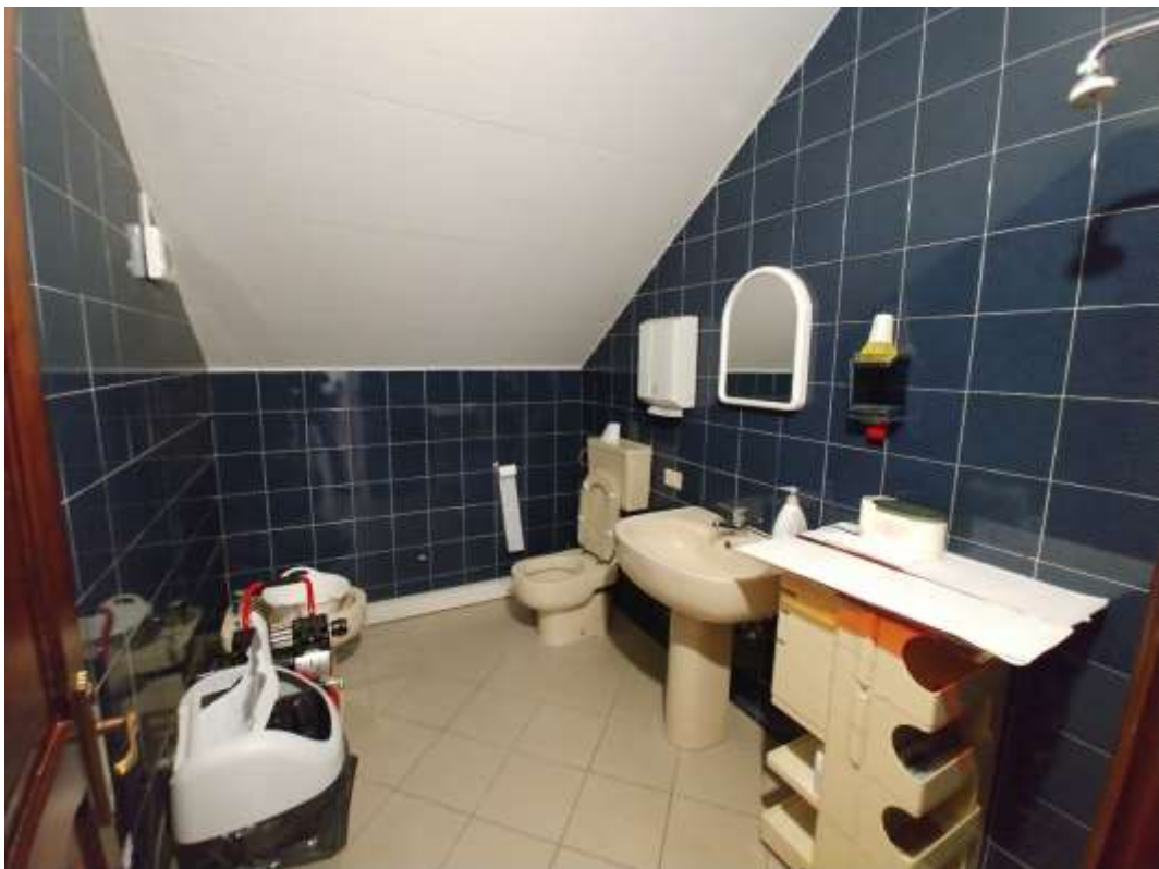
- FOTO 171 - Servizio igienico mapp.832 sub.46
