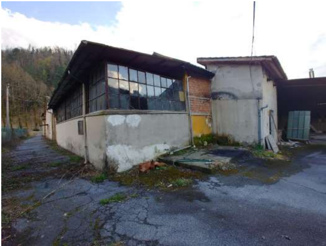
- FOTO 7 - Vista da nord-est
