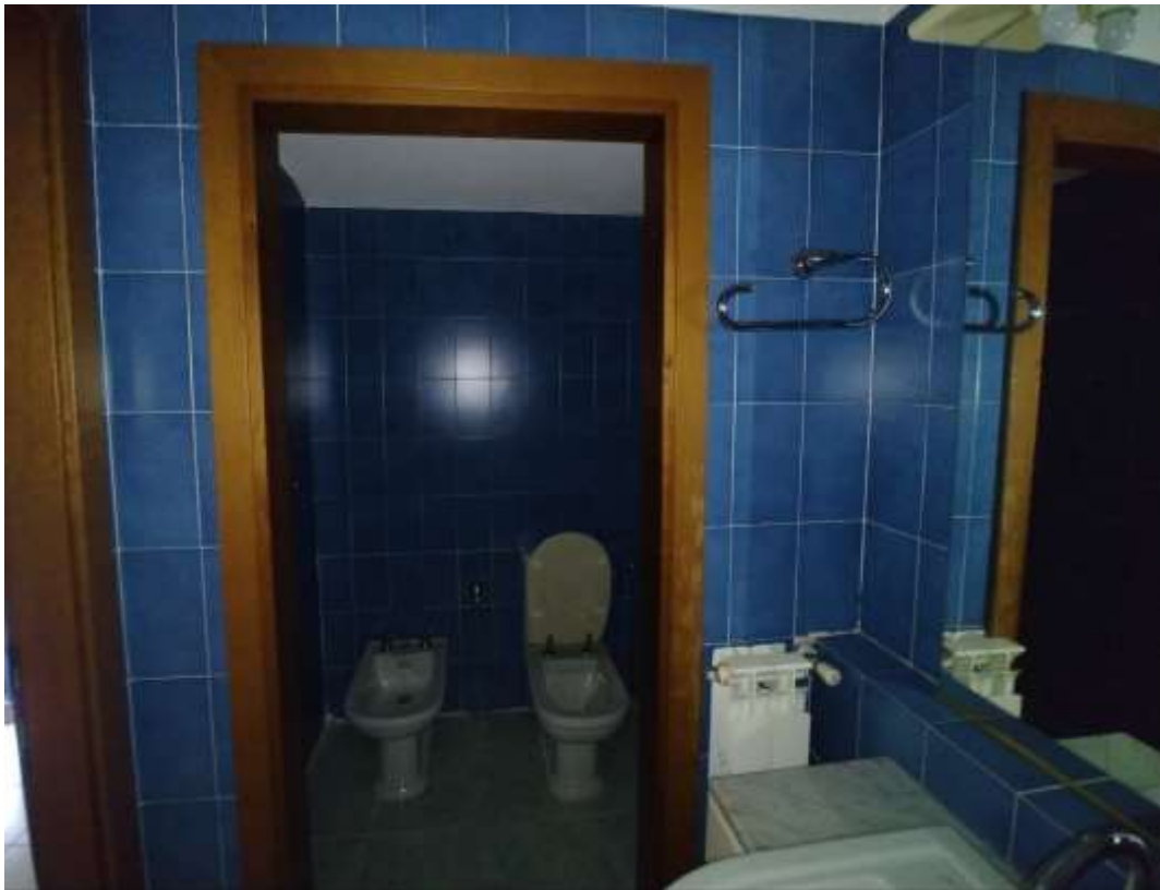
- FOTO 119 - Servizio igienico mapp.832 sub.34
