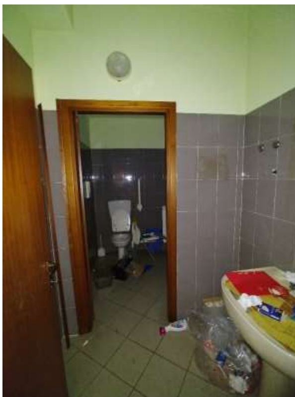
- FOTO 154 - Antibagno mapp.832 sub.44
