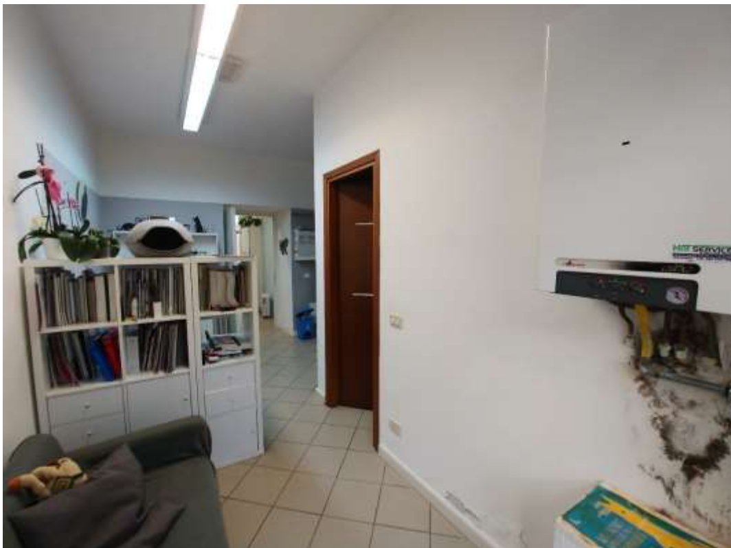
- FOTO 177 - Vano 1 mapp.832 sub.50
