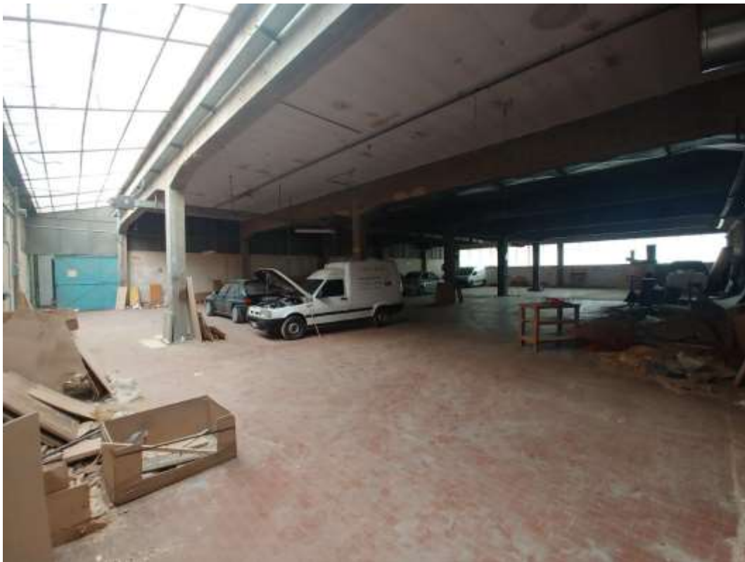
- FOTO 30 - Lavorazioni cornici p.t.
