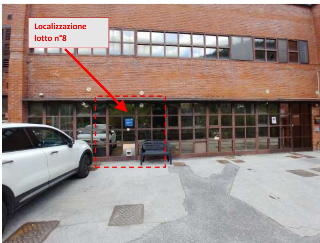
- FOTO 173 - Accesso al mapp.832 sub.50 da resede comune mapp.832 sub.52
