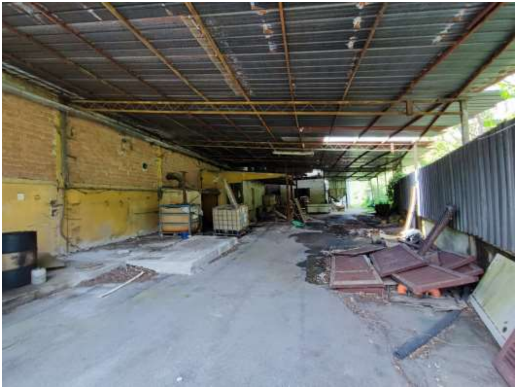
- FOTO 35 - Tettoie lato Lima
