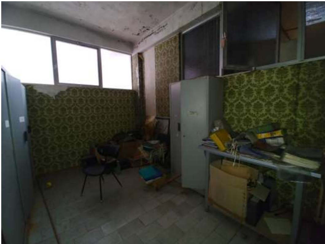
- FOTO 50 - Vano interno 3 1°p.
