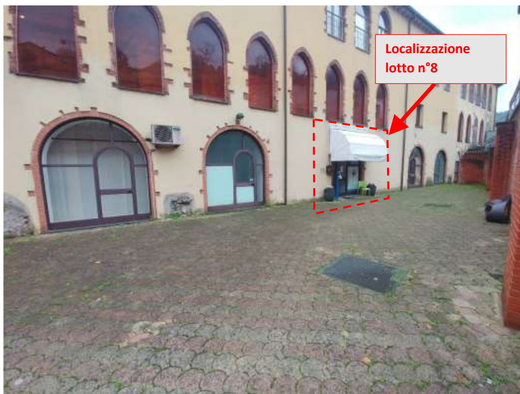
- FOTO 172 - Accesso al mapp.832 sub.50 da resede comune mapp.832 sub.30
