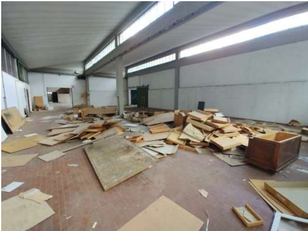
- FOTO 56 - Magazzino materiali 1°p.
