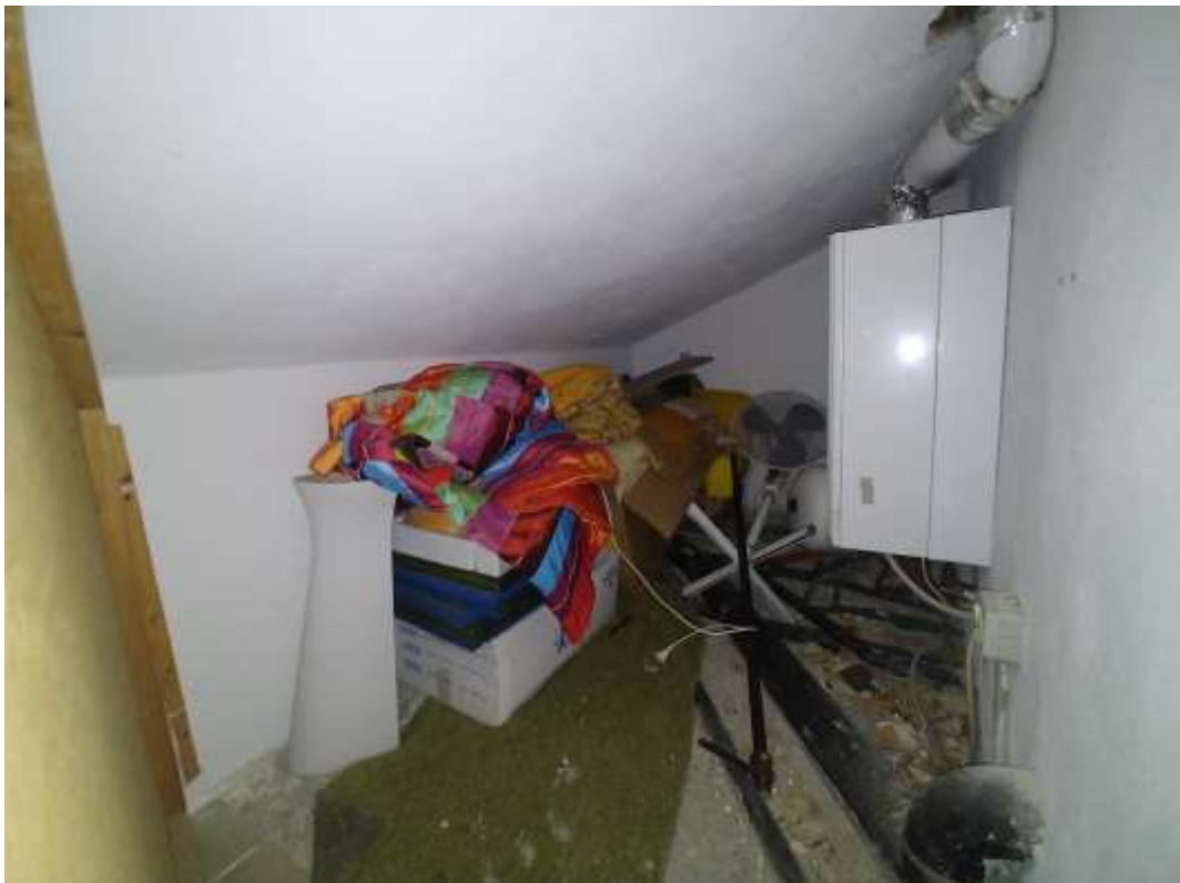
- FOTO 135 - Ripostiglio al piano secondo sottotetto
