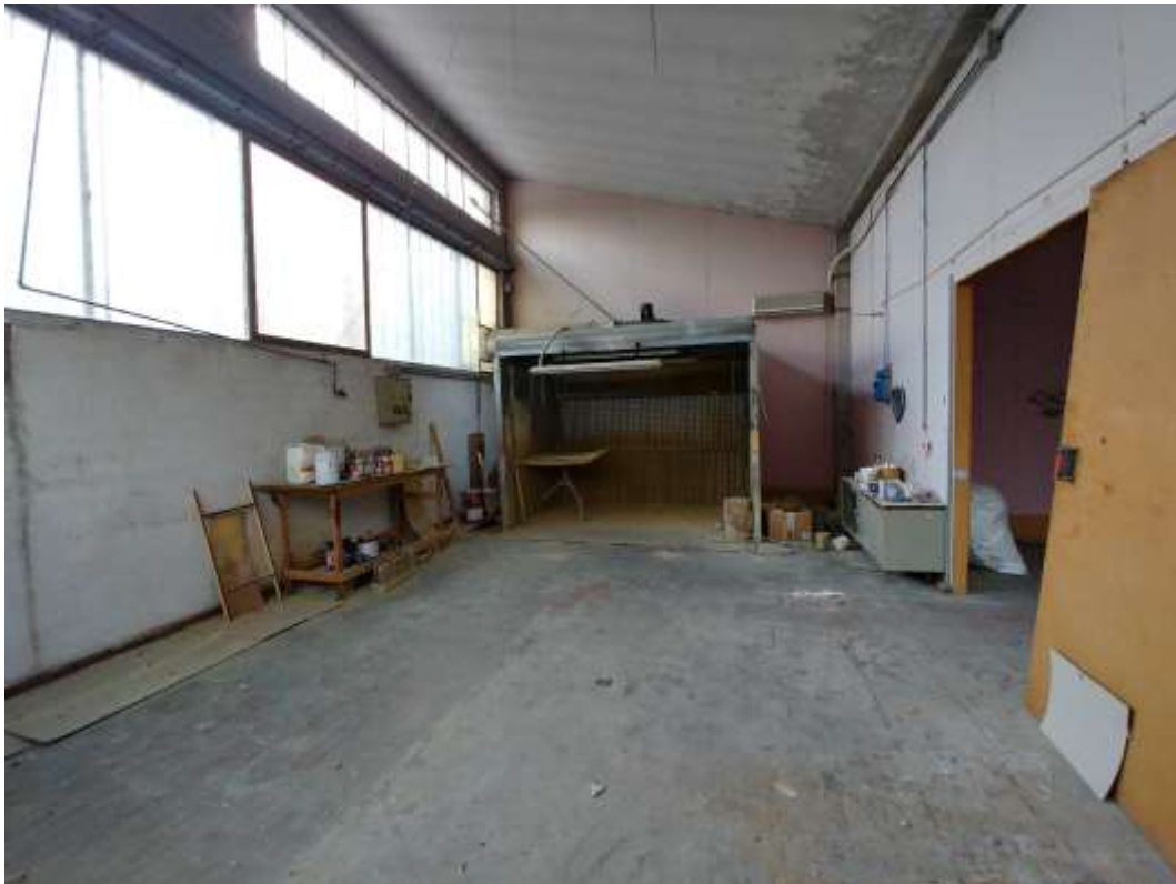
- FOTO 60 - Vano 3 1°p.
