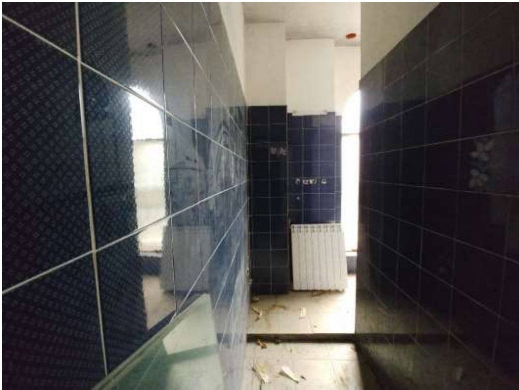
- FOTO 111 - Servizio igienico mapp.832 sub.32
