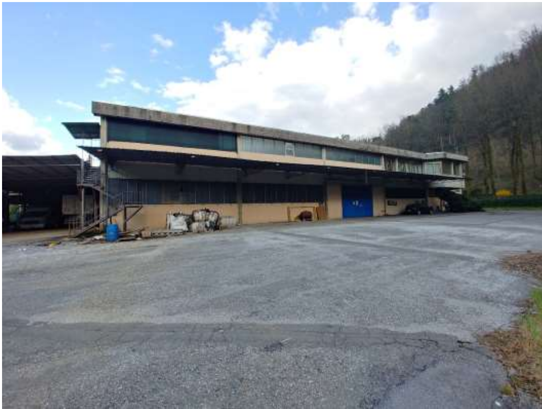
- FOTO 3 - Prospetto ovest
