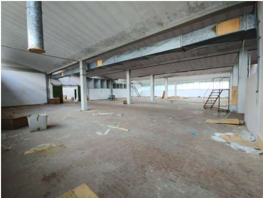
- FOTO 59 - Magazzino quadri e materiali 1°p.
