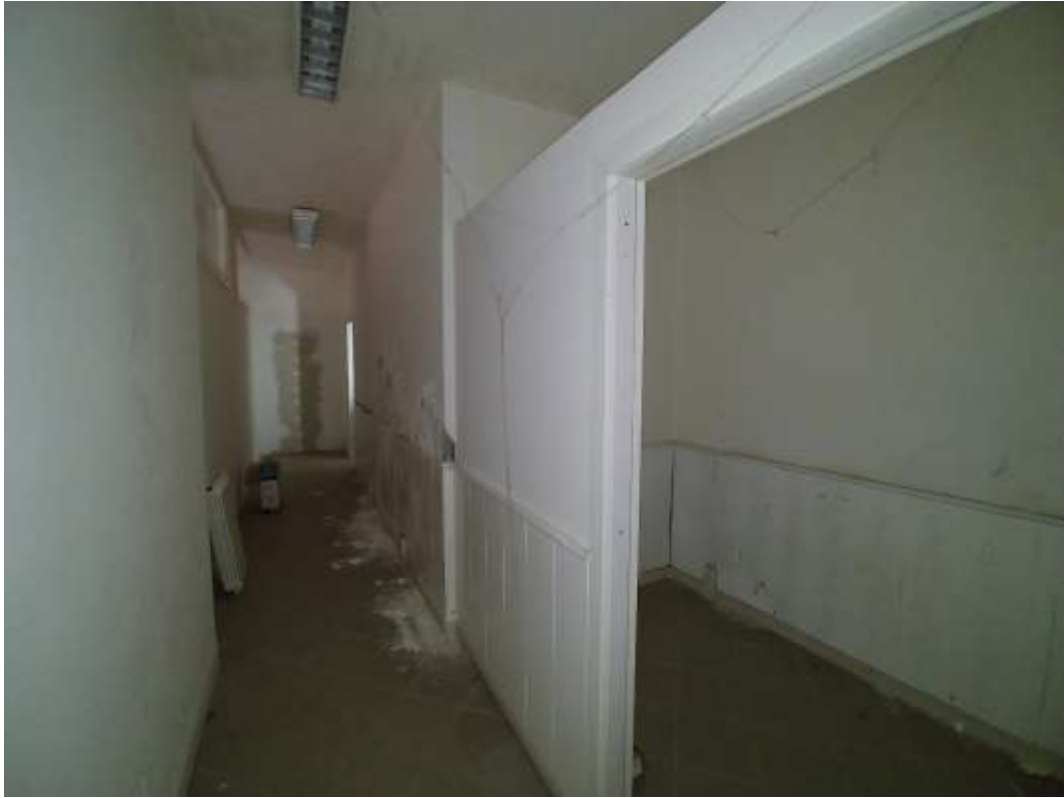
- FOTO 197 - Disimpegno e spogliatoio lotto 9 porzione "A"
