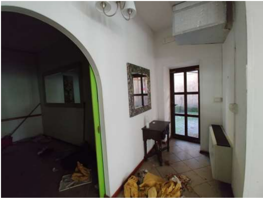
- FOTO 146 - Ingresso comune mapp.832 sub.47
