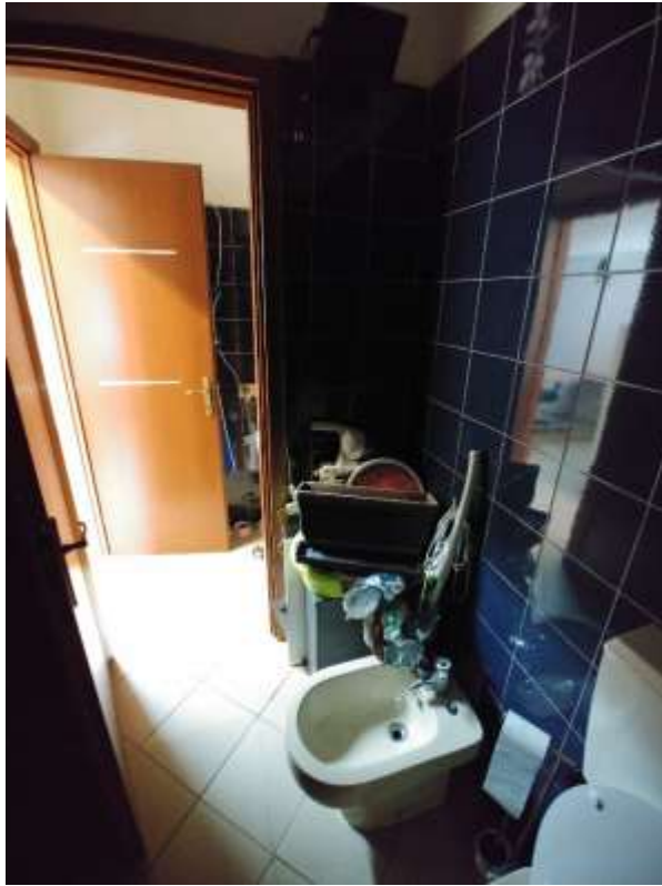
- FOTO 178 - Servizio igienico mapp.832 sub.50
