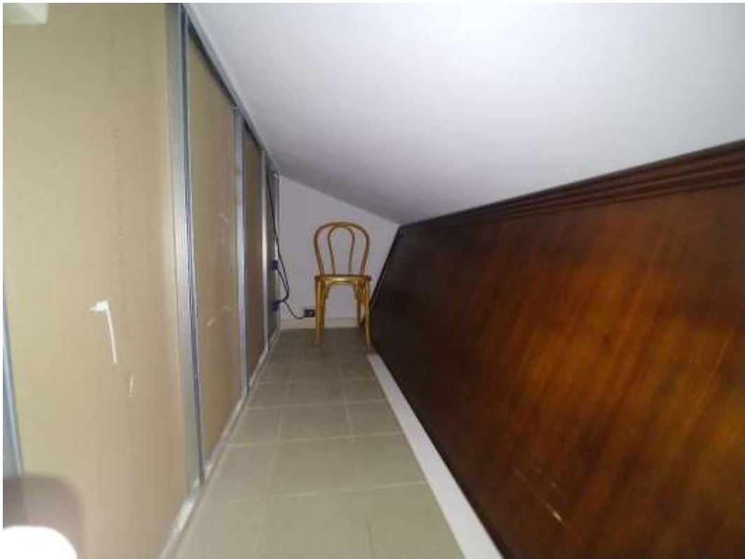
- FOTO 136 - Ripostiglio al piano secondo sottotetto
