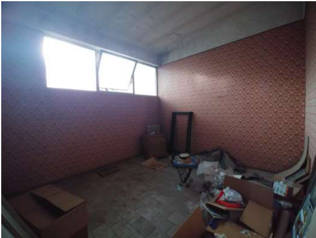
- FOTO 47 - Vano interno 2
