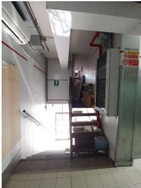
- FOTO 82 - Disimpegno e scalette metalliche di accesso al soppalco
