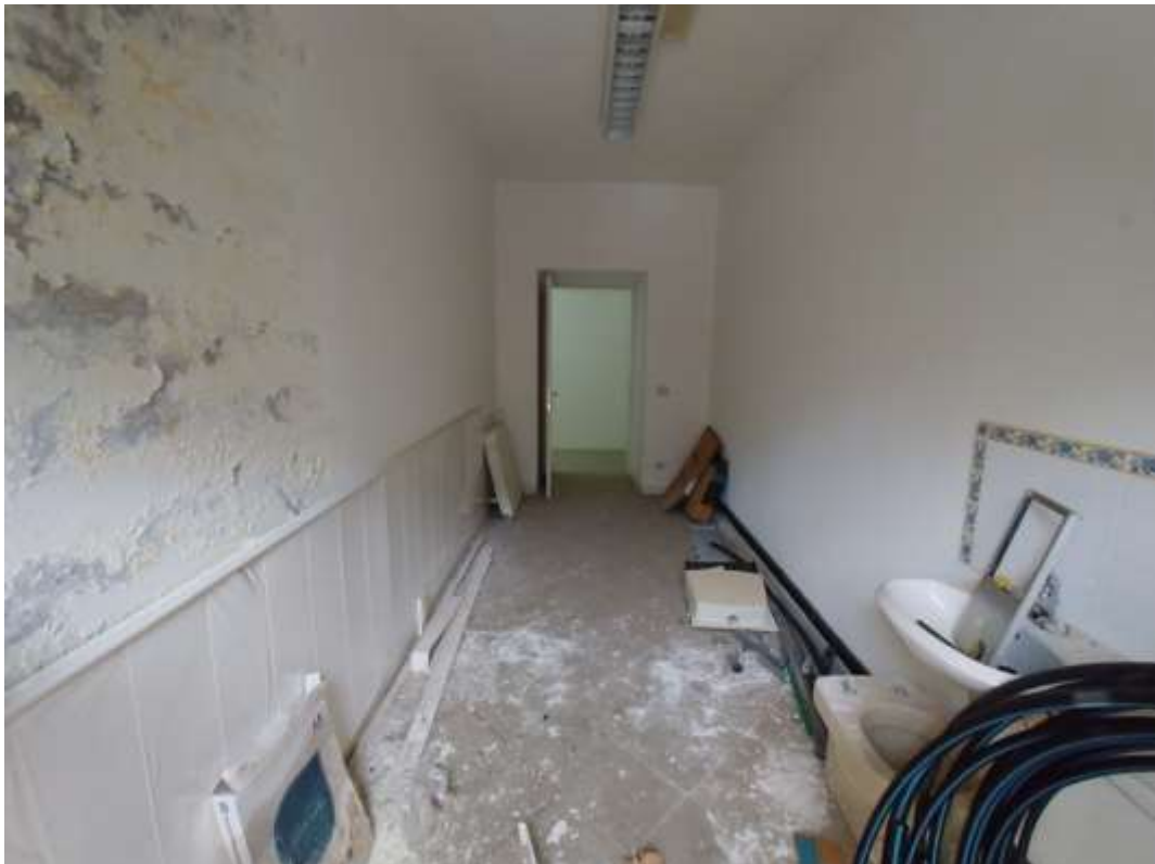
- FOTO 194 - Vano 1A lotto 9 porzione "A"
