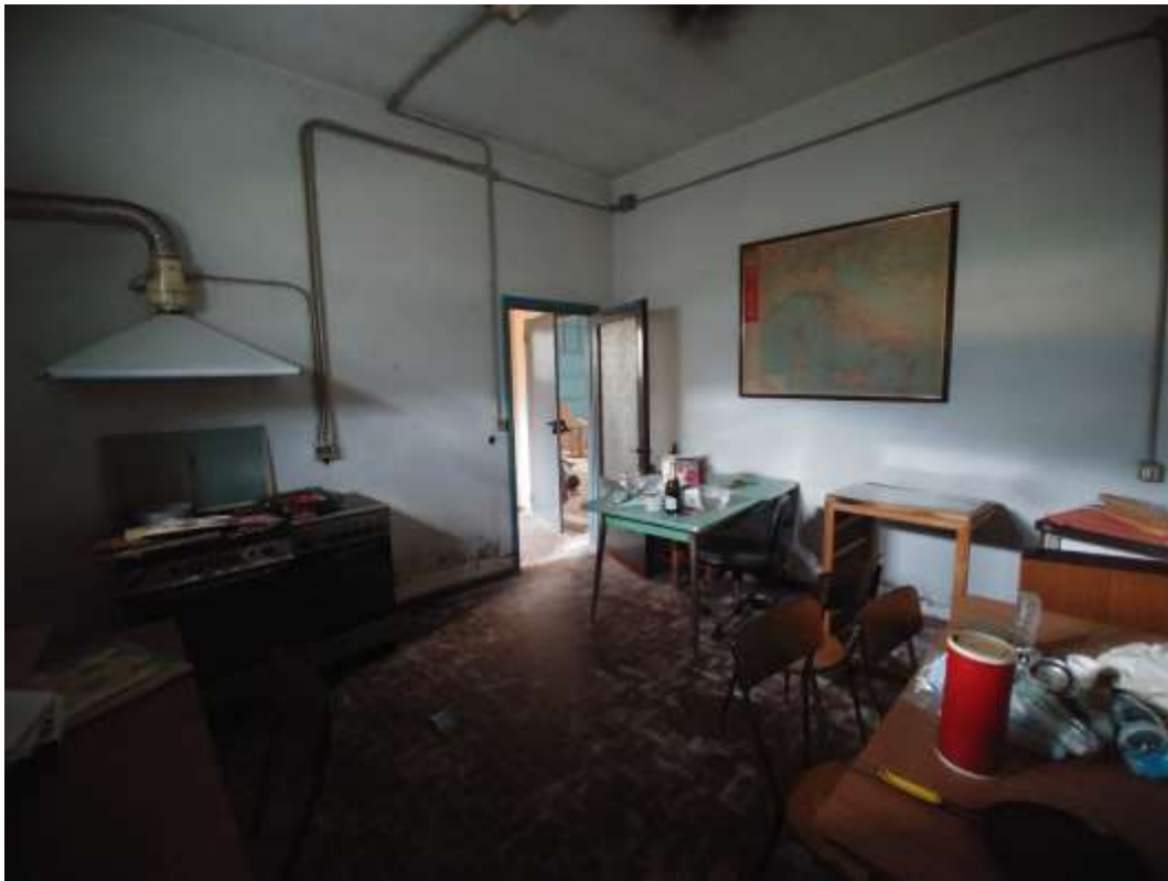
- FOTO 21 - Ripostiglio p.t.
