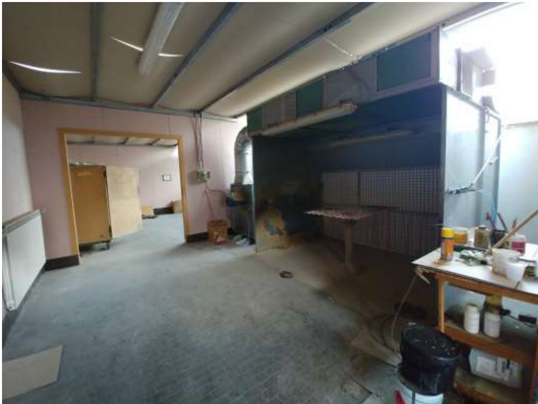
- FOTO 62 - Vano 2 1°p.
