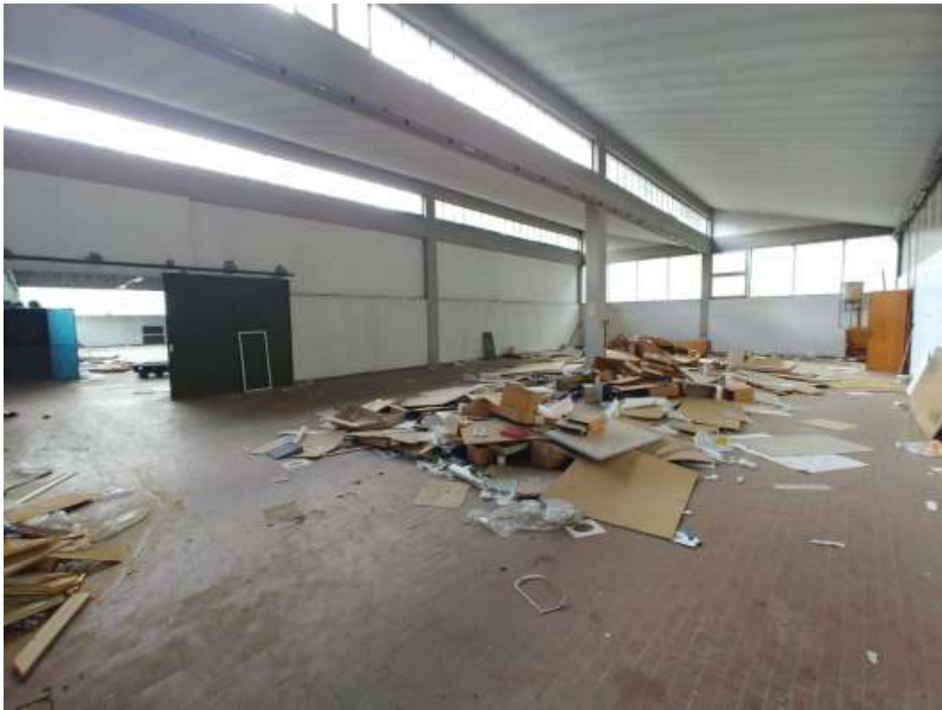
- FOTO 57 - Magazzino materiali 1°p.
