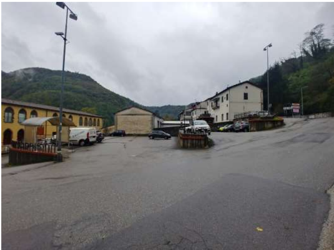
- FOTO 68 - Resede comune mapp.832 sub.52 e strada privata di accesso mapp.1457
