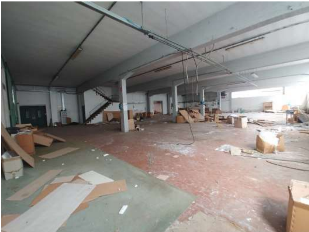
- FOTO 16 - Imballaggio quadri p.t.
