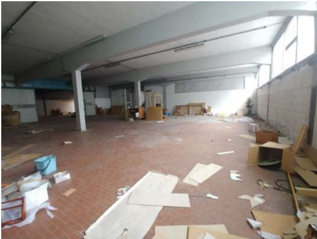
- FOTO 15 - Magazzino quadri p.t.
