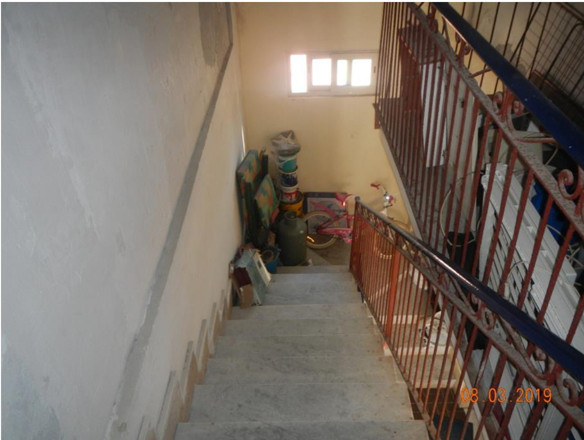
Rampa che conduce al lastrico solare adibito a stenditoio
