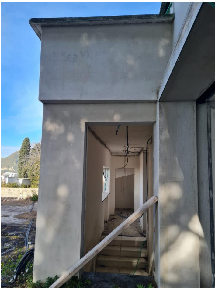
Finestra del vano scala
