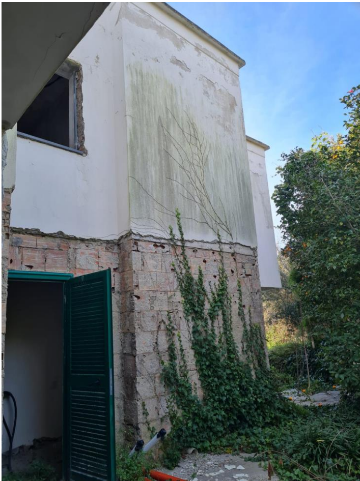
Vista da Nord
