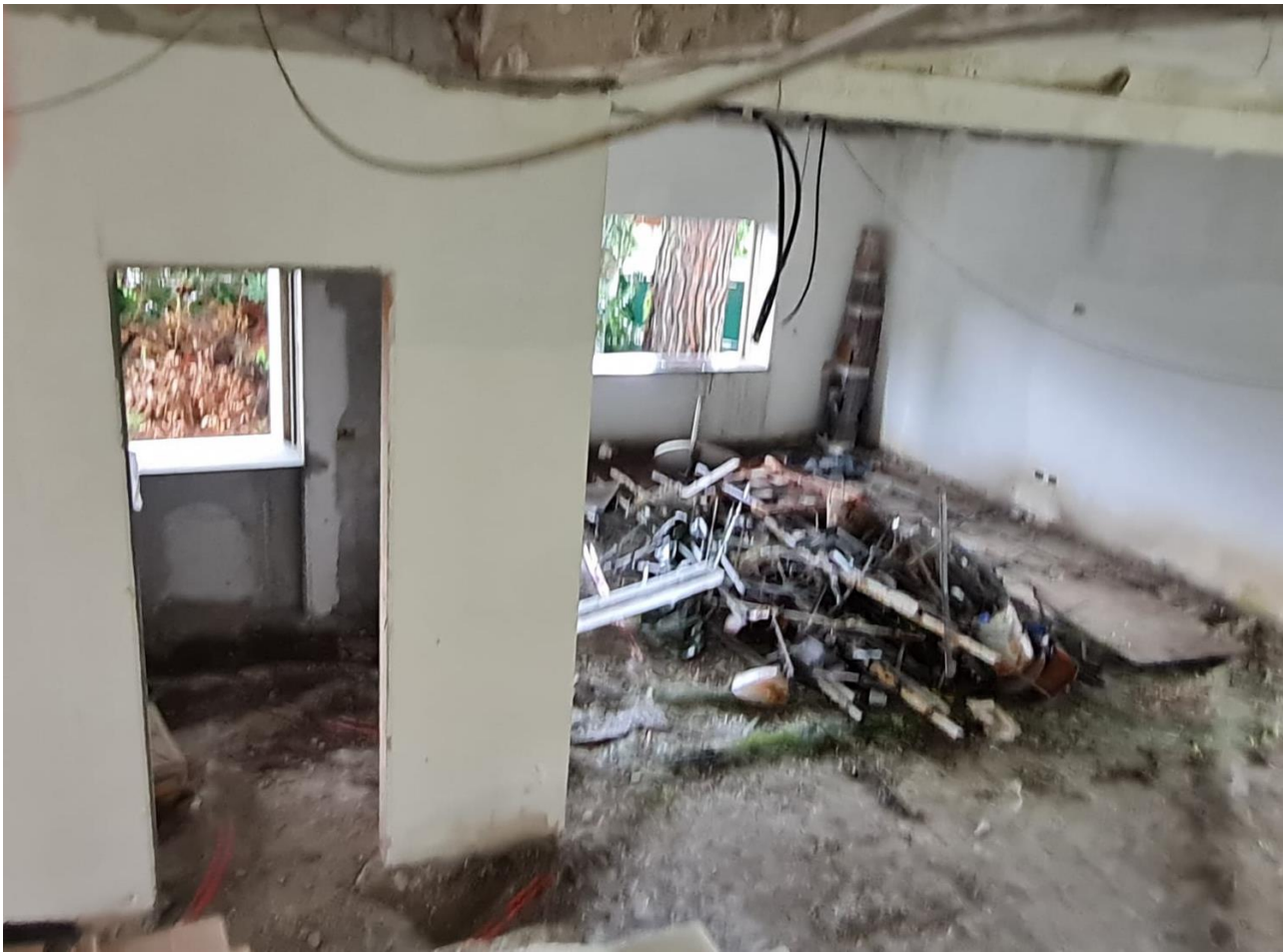
Vano (V1) e bagno (WC1)
