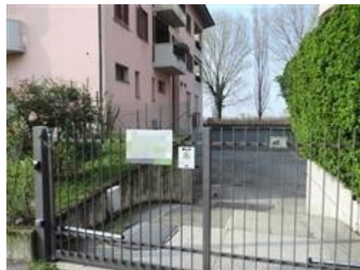
La rampa condominiale d'accesso
