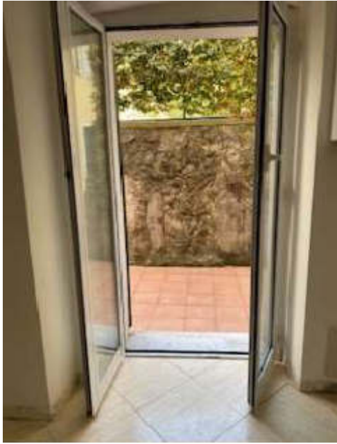
17 – porta finestra verso distacco
