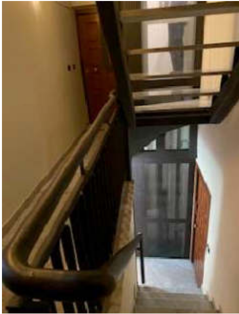
9 – vano scala e vista ascensore
