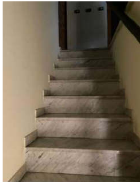
8 – vano scala (prima rampa)
