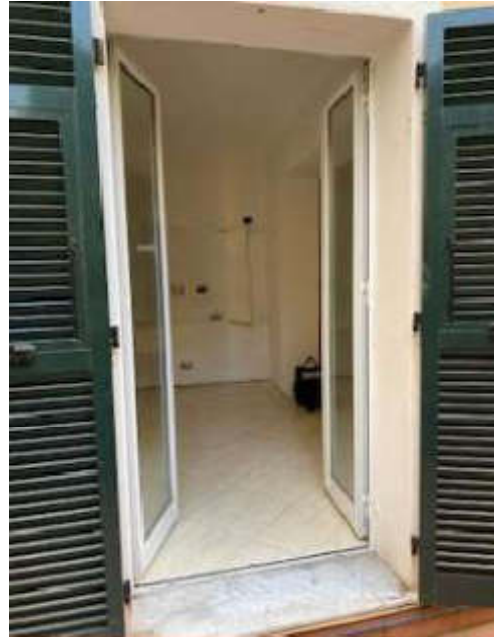
18 – vista dal distacco
