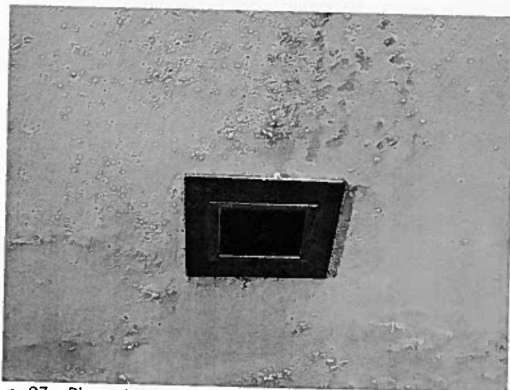
Foto n. 27 – Piano terra, parete con tracce di muffa nel soggiorno
