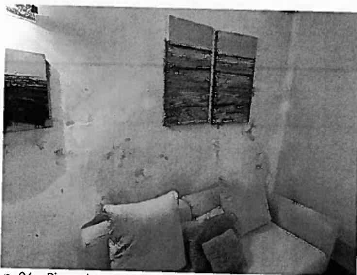
Foto n. 26 – Piano terra, parete con tracce di muffa nel soggiorno
