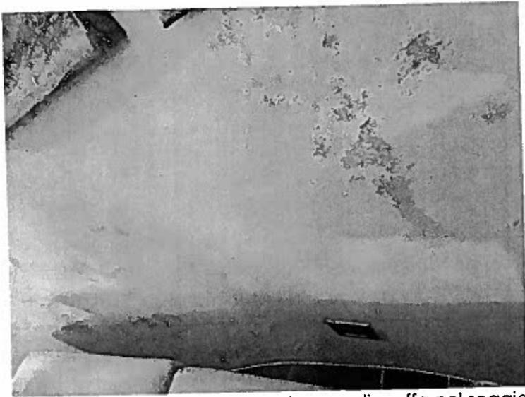
Foto n. 28 – Piano terra, parete con tracce di muffa nel soggiorno
