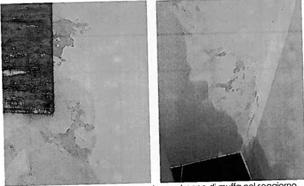
Foto n. 29 e 29A – Piano terra, parete con tracce di muffa nel soggiorno
