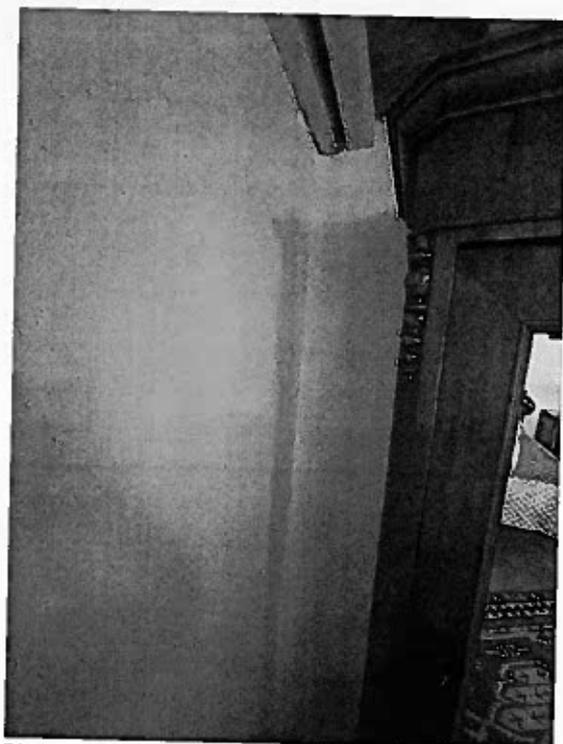
Foto n. 31 – Piano primo, cretto nell'angolo della camera con w.c.
