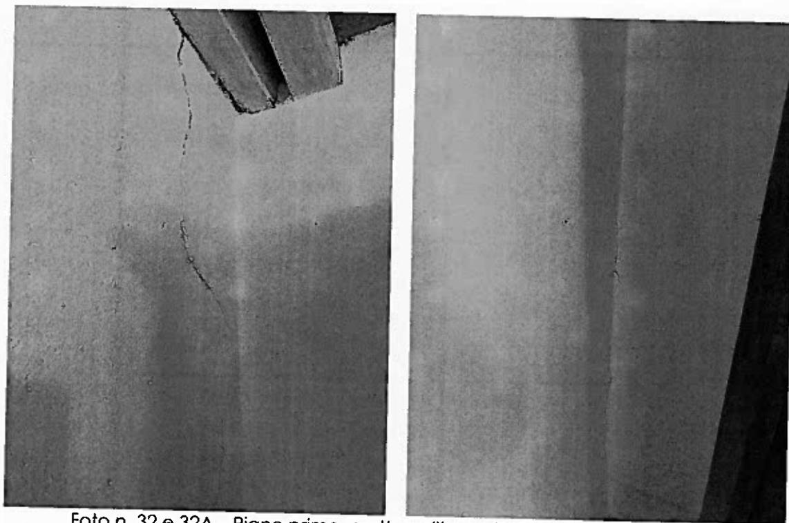
Foto n. 32 e 32A – Piano primo, cretto nell'angolo della camera con w.c.
