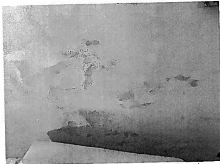
Foto n. 30 – Piano terra, parete con tracce di muffa nel soggiorno
