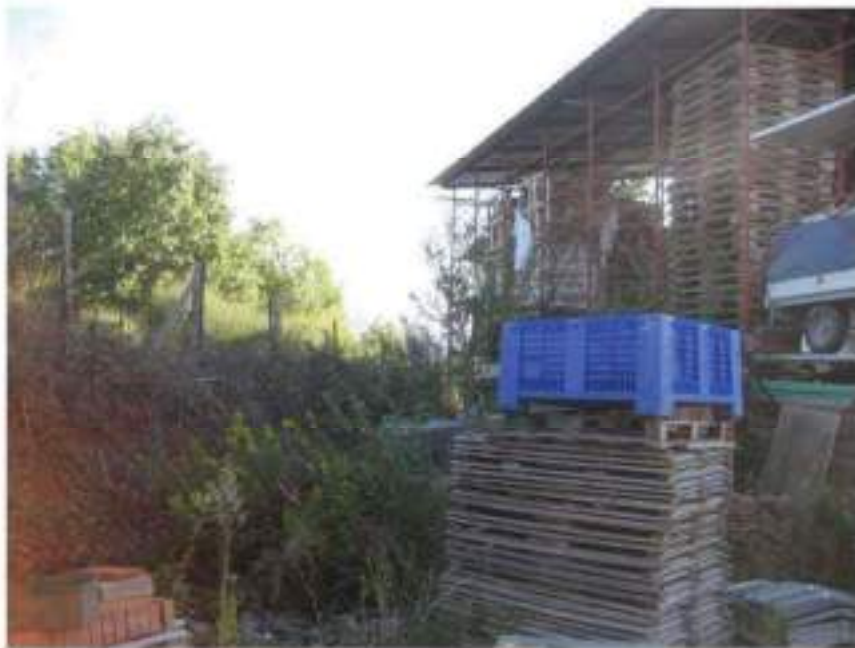
Opere abusive poste all'interno del cortile
