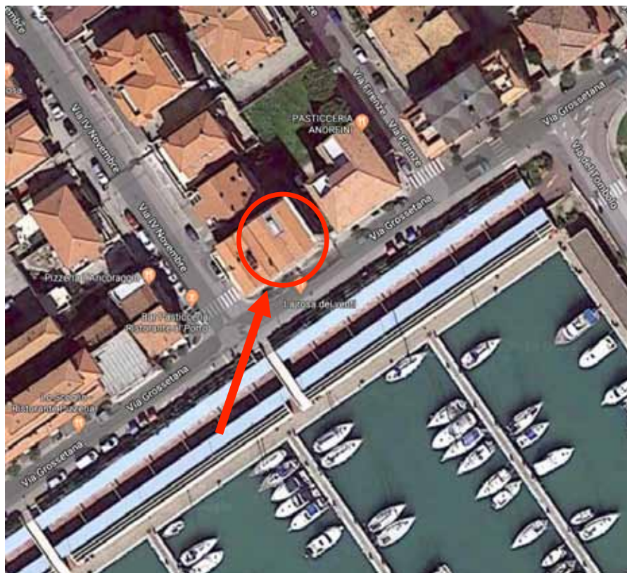
immagine 3 – Via Grossetana, fraz. Marina nel Comune di Grosseto (fabbricato in costruzione)
