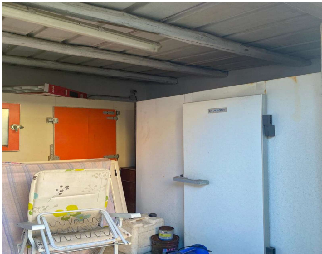
Foto n. 28 Manufatto abusivo, adibito a deposito
