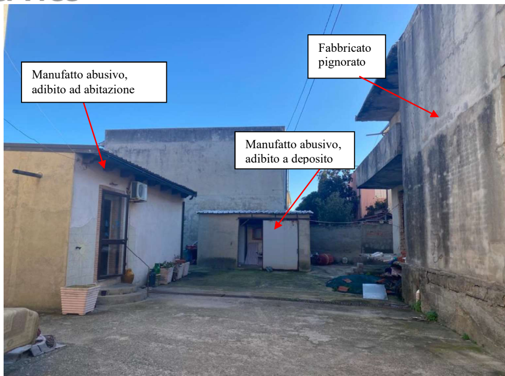
Foto n. 19 Manufatti abusivi non sanabili
