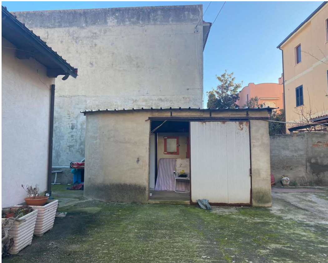
Foto n. 26 Manufatto abusivo, adibito a deposito
