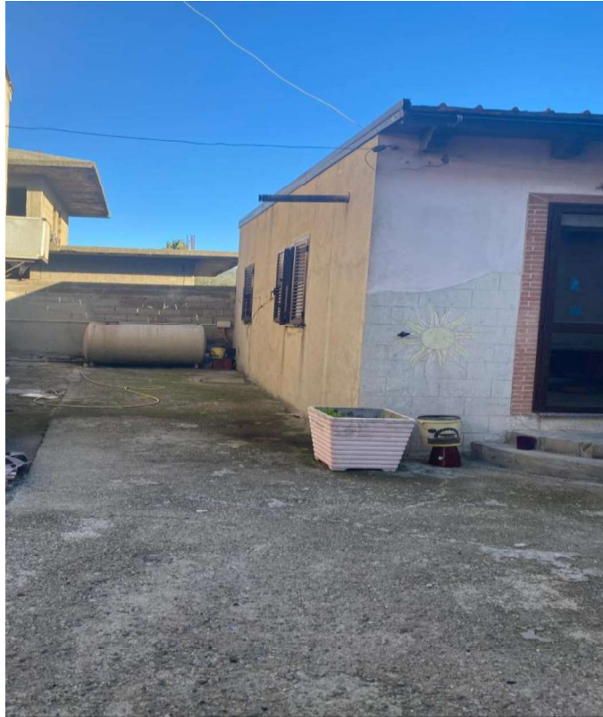
Foto n. 21 manufatto abusivo e parte di corte
