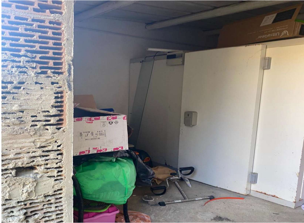
Foto n. 27 Manufatto abusivo, adibito a deposito
