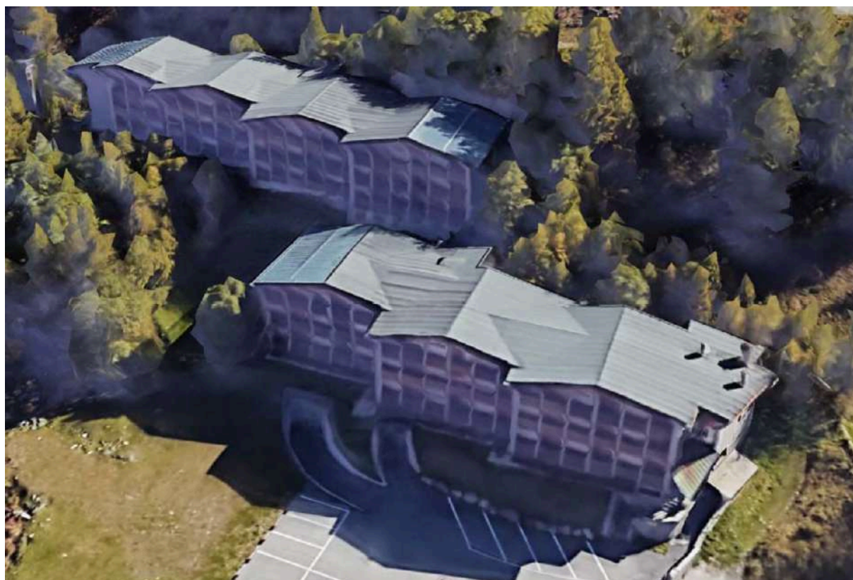
Imm.n.1: vista della facciata esposta a Sud-Ovest del fabbricato "Condominio Rododendro - Residence".
