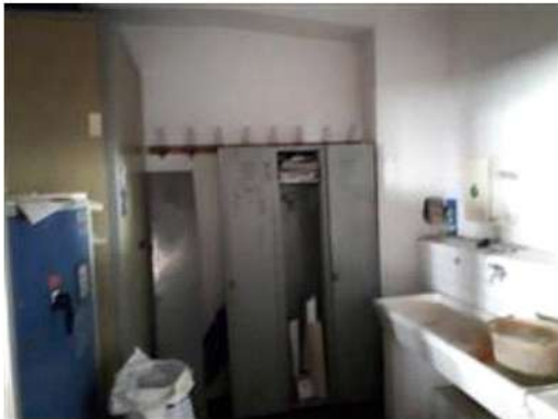
Bagno del laboratorio PS2
