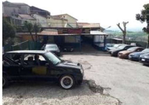
Parcheggio della part. 404 ed accesso alla porzione di laboratorio sub. 2 affittata alla ditta
