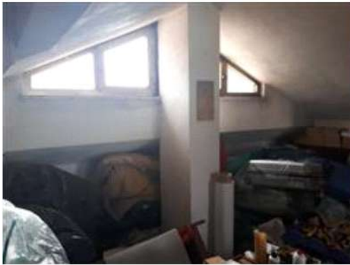
Soffitta allo stato grezzo P2
