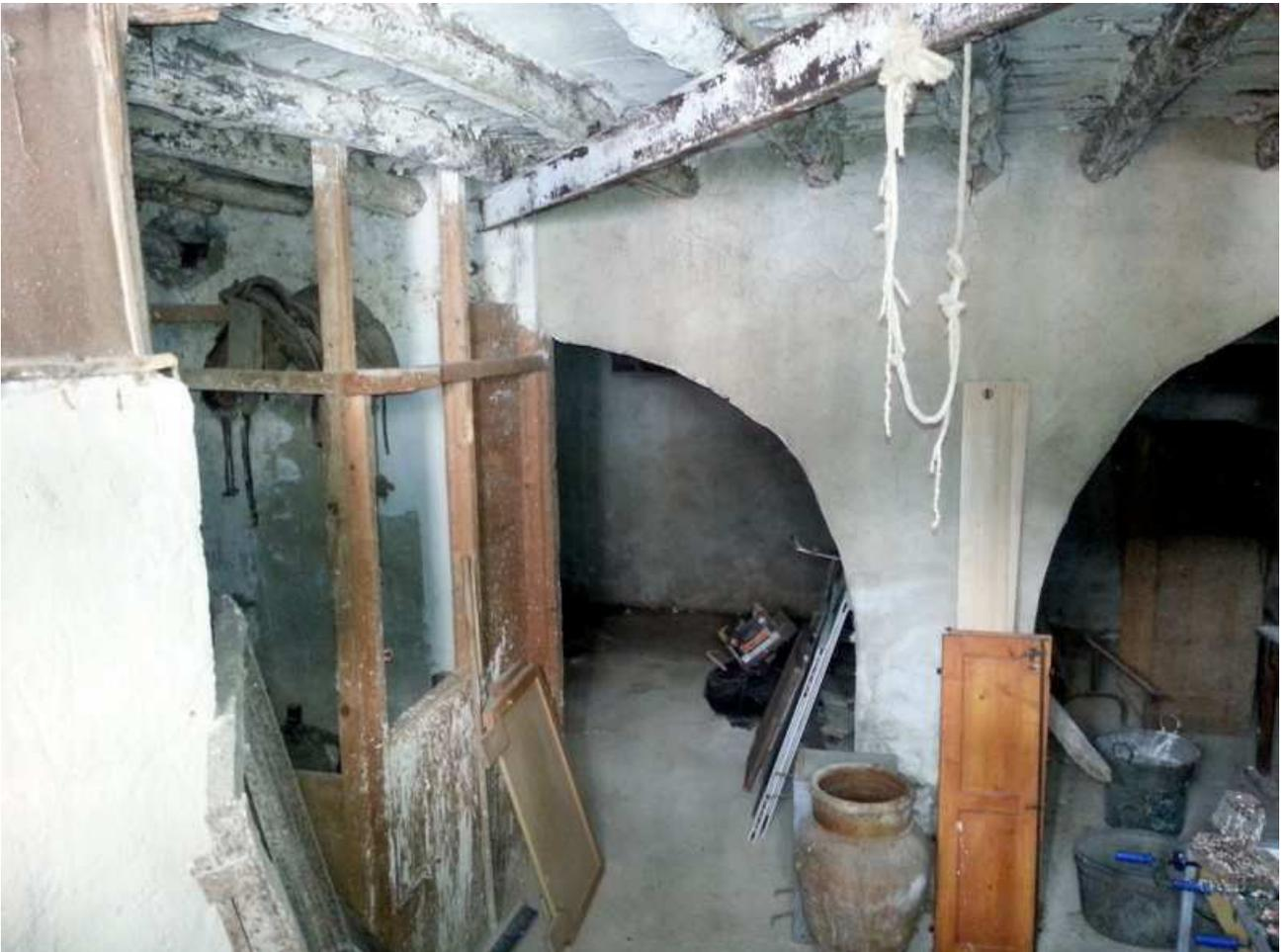
Foto n. 38. L'interno del magazzino. Il tetto è basso e le sue condizioni sono scadenti.
