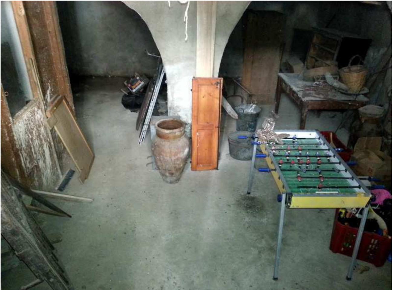
Foto n. 40. Il pavimento è in battuto di cemento.
