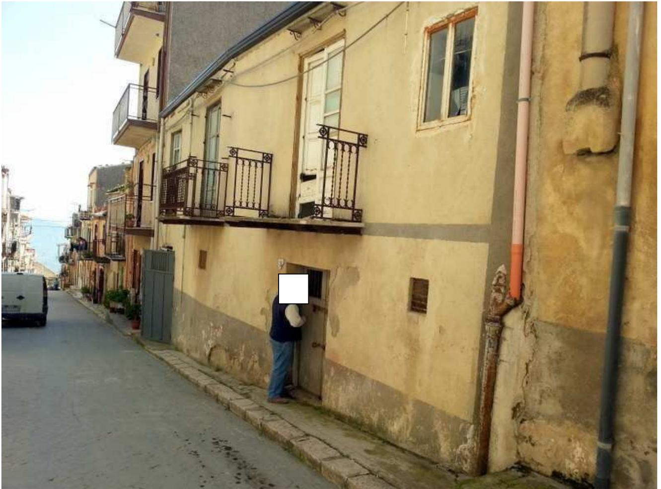
Foto n. 19. Il retro prospetto su Via Principe di Fitalia. Anche in questo caso infissi e balconi vanno rifatti.
