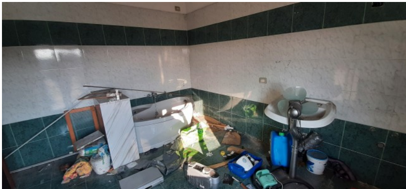
foto 3: vista del bagno 1
