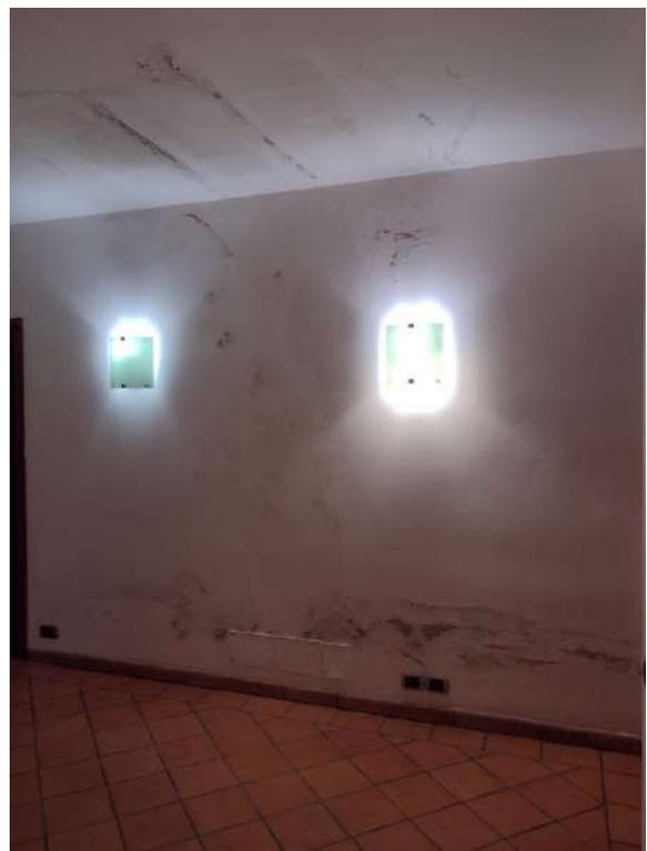
Interno disimpegno p.terra , tracce di infiltrazione di acqua pareti e soffitto
