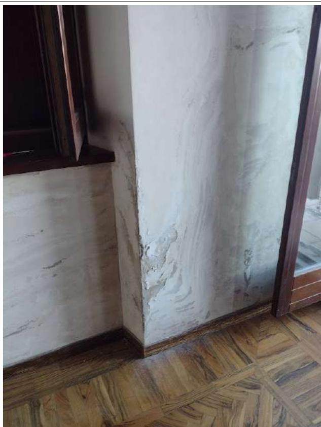
Particolare con evidenziate infiltrazioni di umidità
