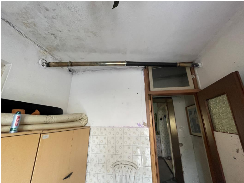
Disimpegno con accesso sul cortile
