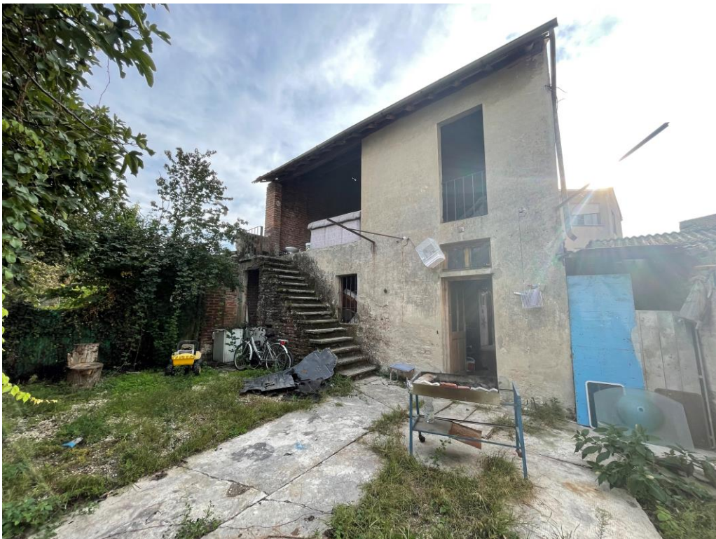
Rustico in corpo staccato su cortile interno
