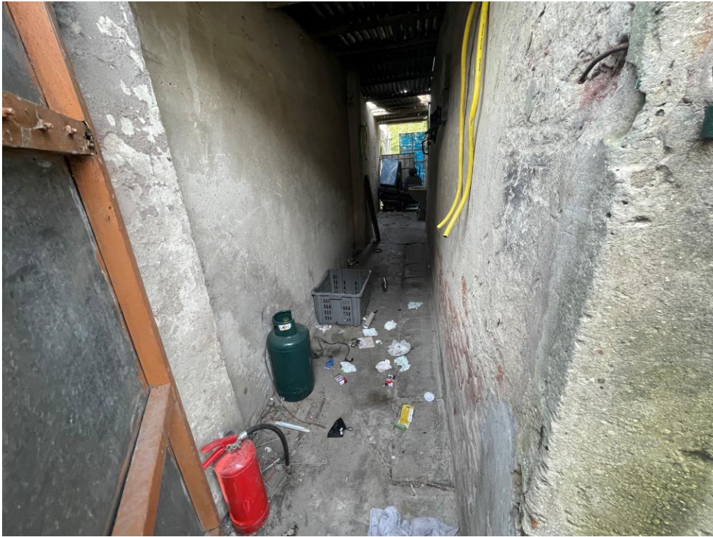
Locale di sgombero 2 nel rustico in corpo staccato
