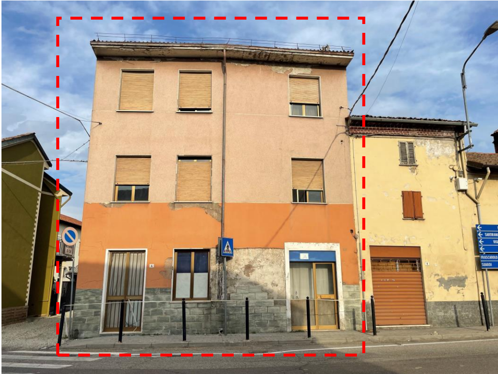
Prospetto lato strada
