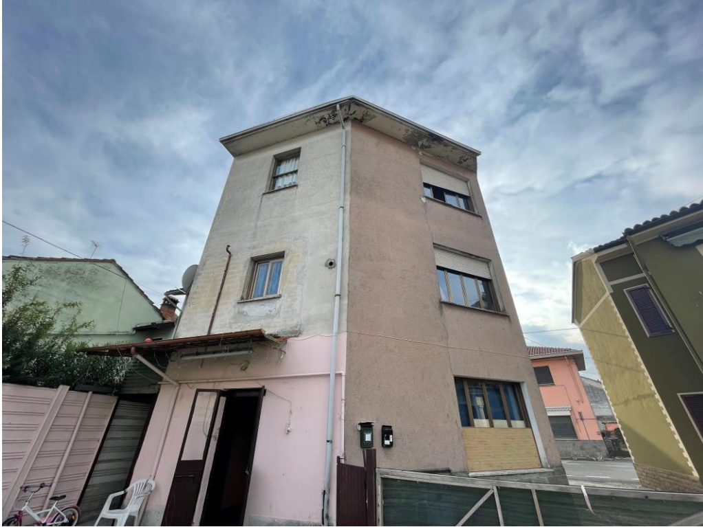
Prospetto lato cortile interno
