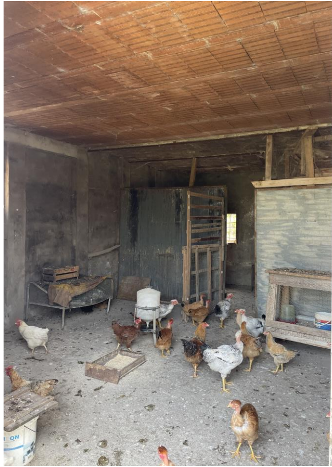
Foto 16 – Fabbricato a deposito – Pollaio
