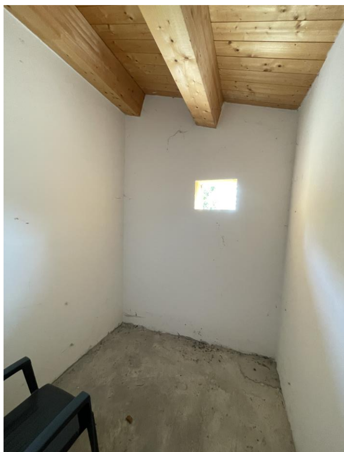
Foto 15 – P1 – Ripostiglio in soffitta
