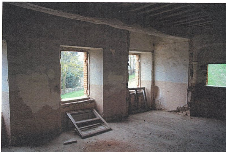
Foto n°25: particolare interno del piano primo.
