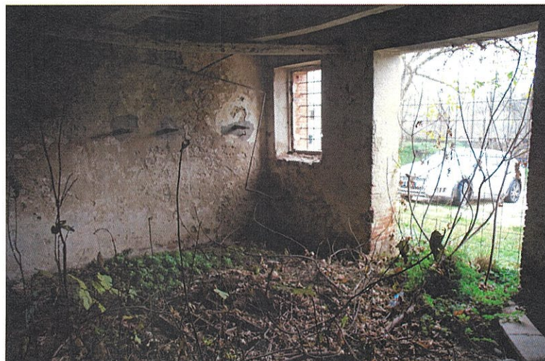
Foto n°24: particolare interno del piano terra.
