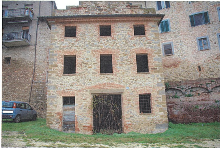
Foto n°21: vista lato Est dell'edificio cielo terra con corte esclusiva allo stato grezzo.
