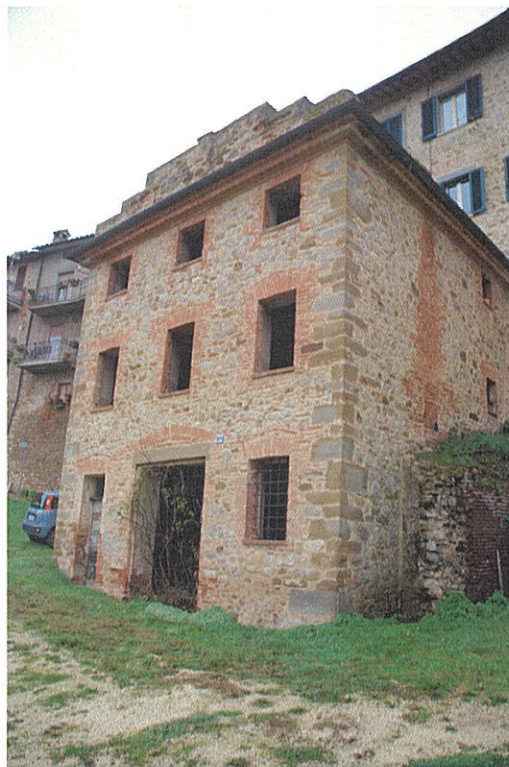
Foto n°22: vista lato Nord-Est del fabbricato.
