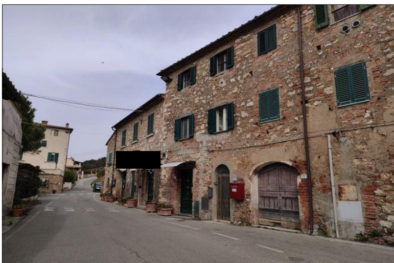
Vista A esterno del fabbricato in oggetto
