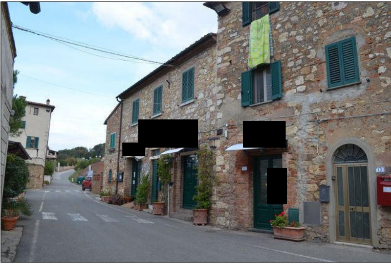
Vista A esterno del fabbricato in oggetto
