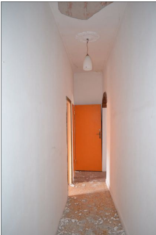
Vista N disimpegno
