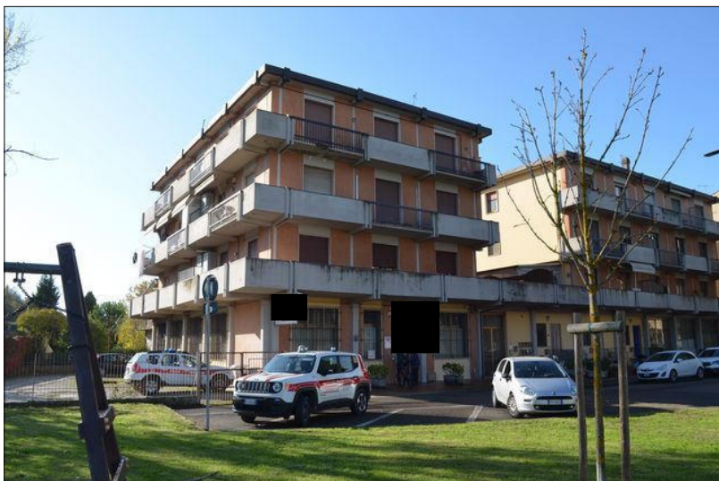
Vista A esterno del fabbricato in oggetto
