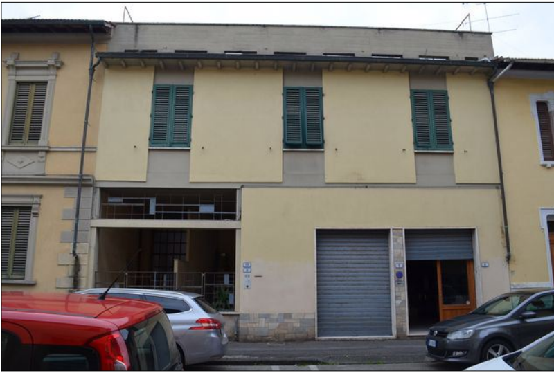
Vista A esterno del fabbricato in oggetto
