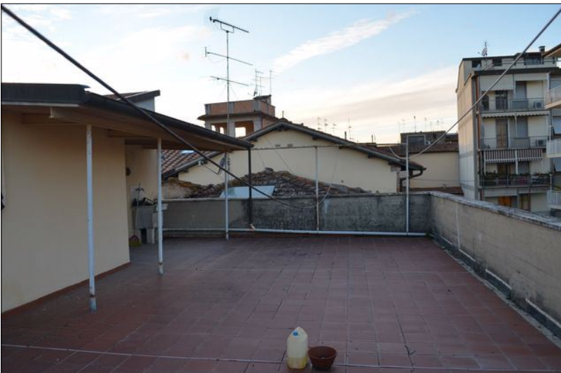
Vista Q del lastrico solare al piano secondo
