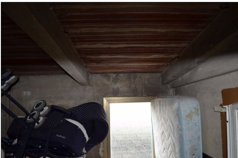
Vista T ripostiglio
