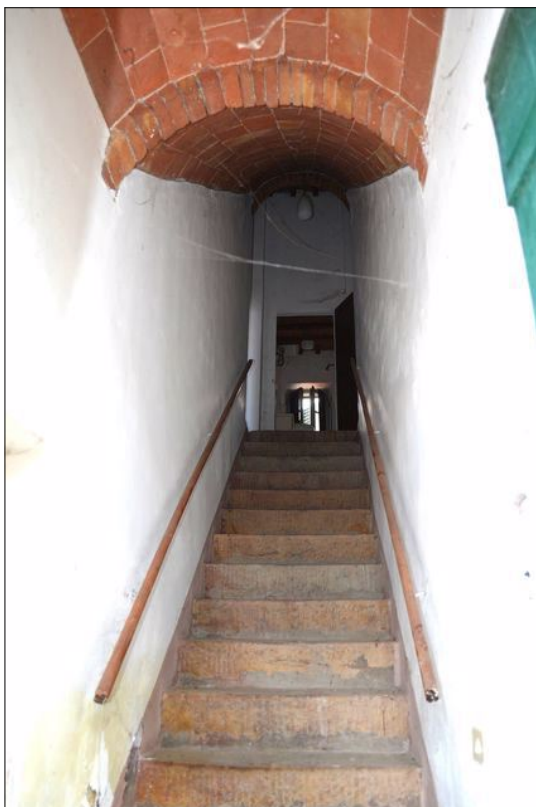
Vista C vano scale di accesso all'immobile
