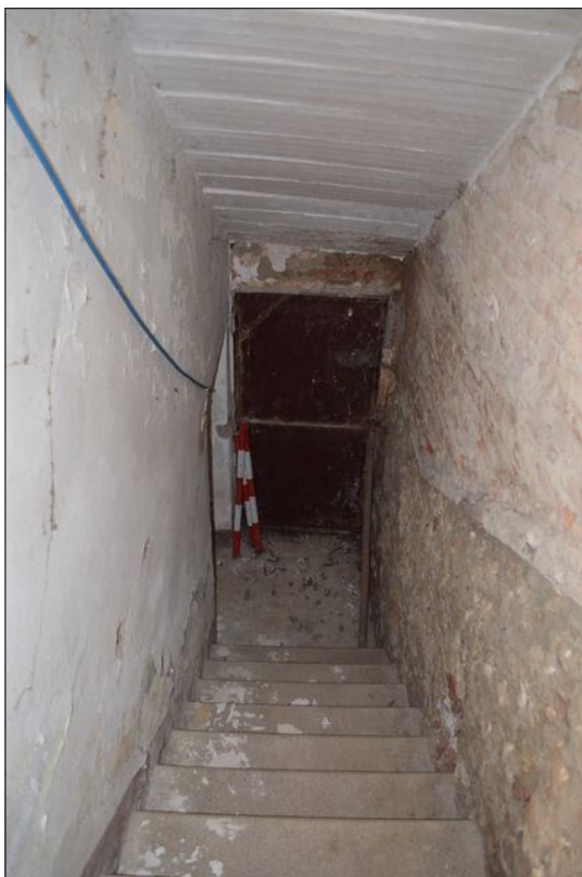
Vista F vano scala di collegamento al piano seminterrato
