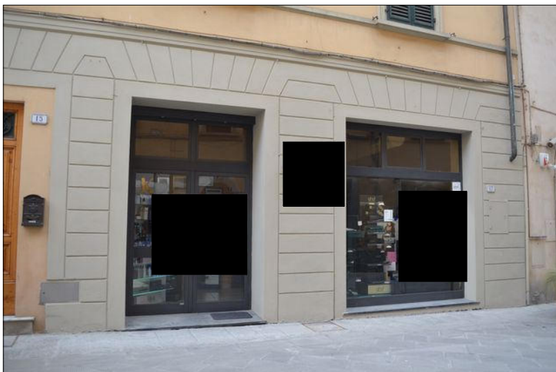
Vista A esterno del fabbricato in oggetto
