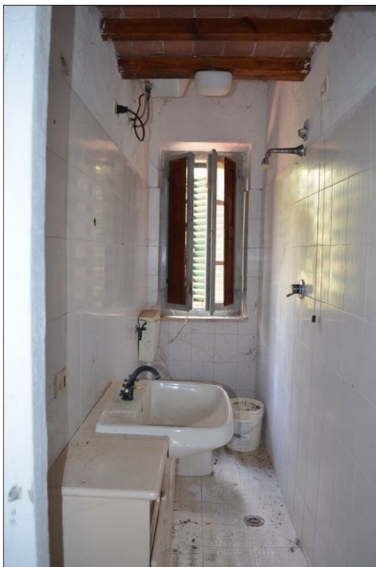
Vista G bagno
