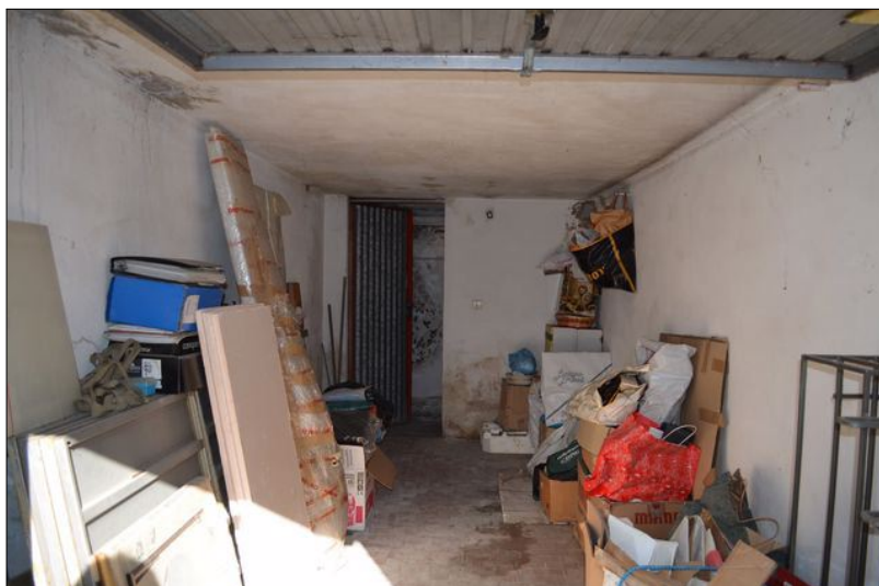
Vista B interno del box
