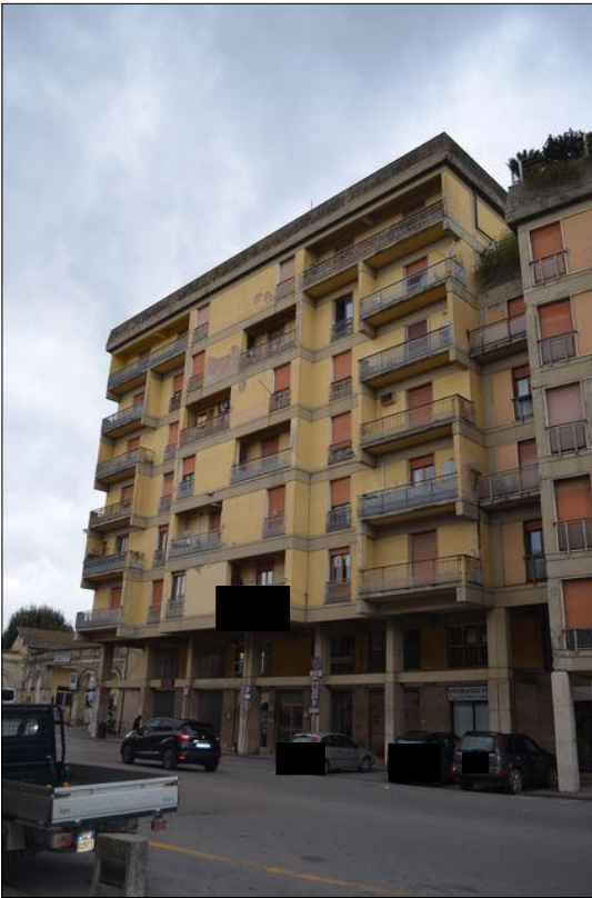
Vista A esterno del fabbricato in oggetto
