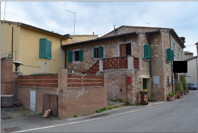
Vista A esterno del fabbricato in oggetto
