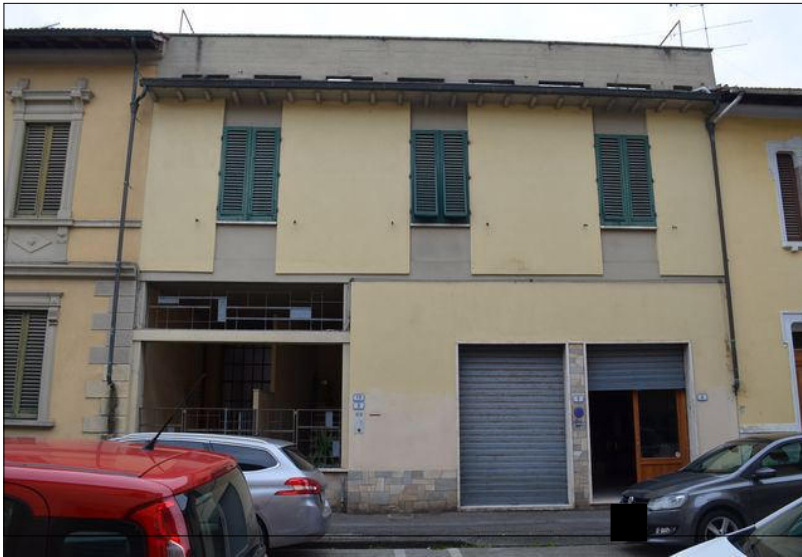
Vista A esterno del fabbricato in oggetto
