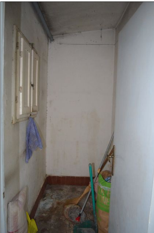
Vista N ripostiglio al piano primo
