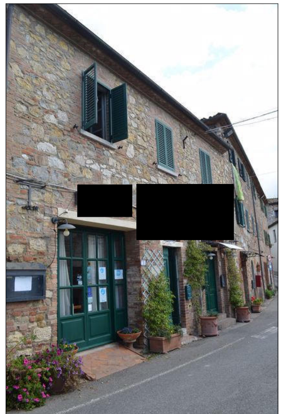
Vista B esterno del fabbricato in oggetto
