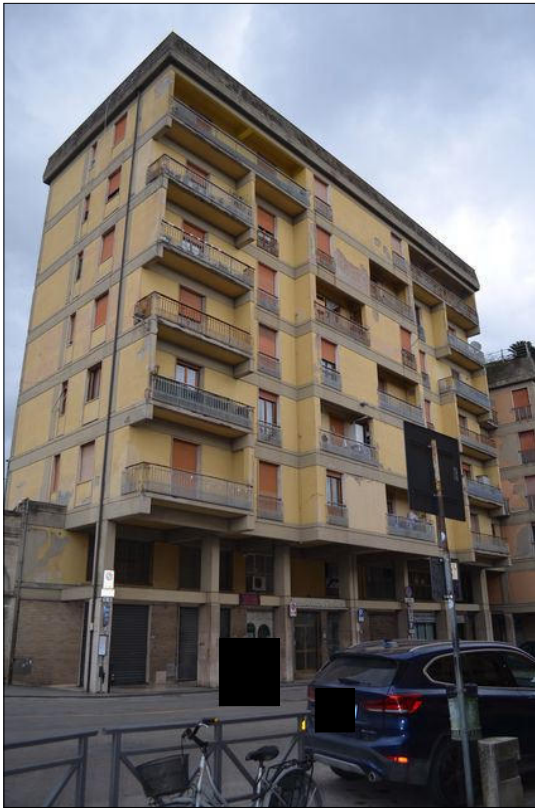
Vista A esterno del fabbricato in oggetto
