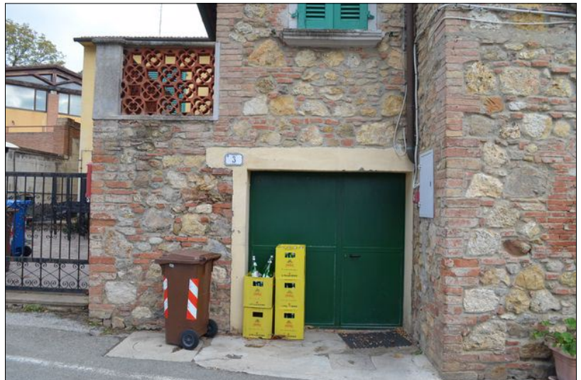
Vista B ingresso del deposito
