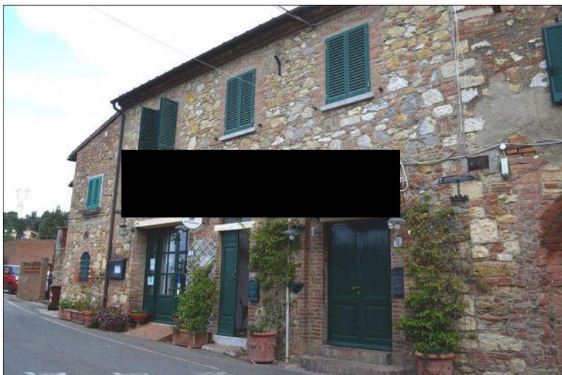
Vista A esterno del fabbricato in oggetto
