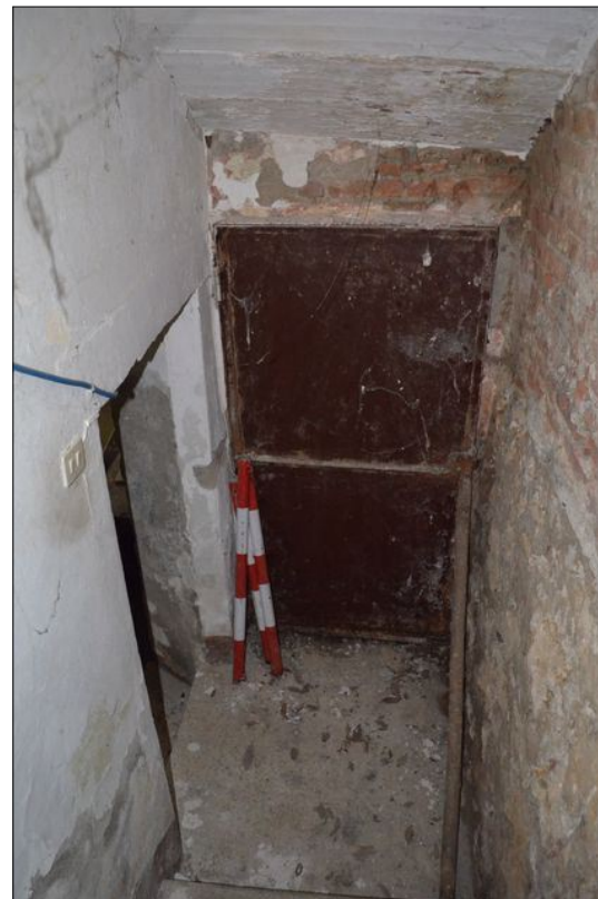
Vista B accesso al negozio dal vano scala
