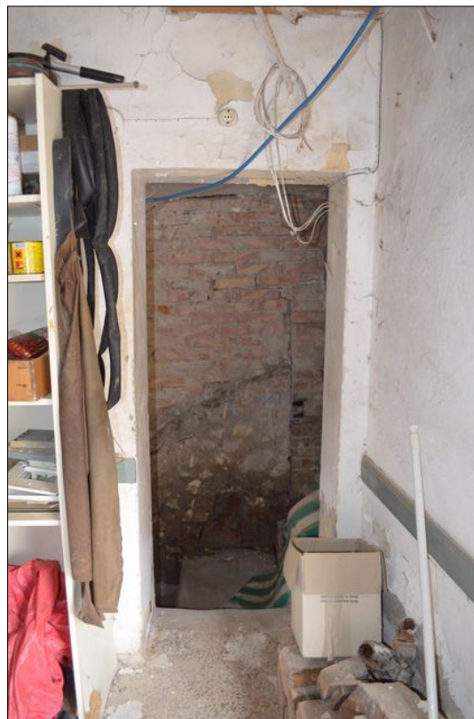
Vista E accesso al vano scala
