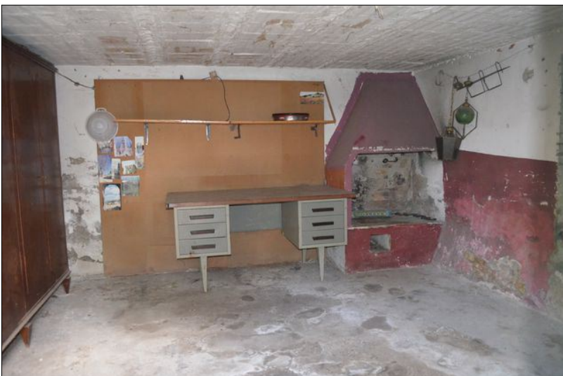
Vista C locale di sgombro
