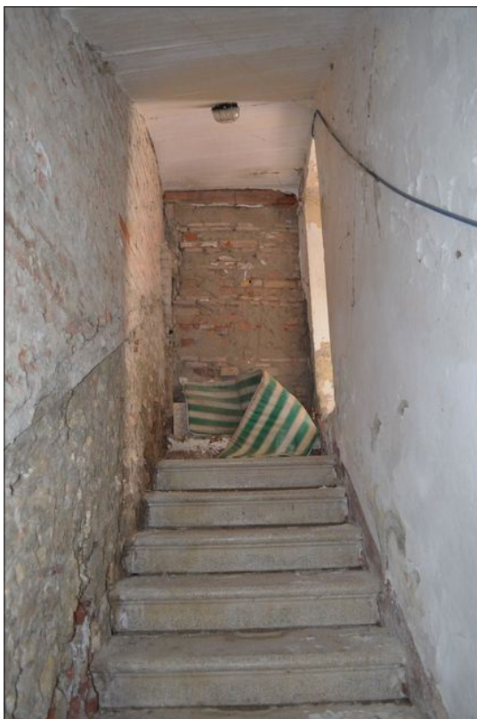
Vista C vano scala di collegamento al piano terra
