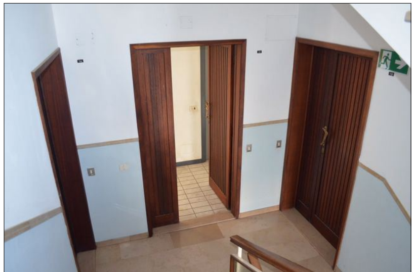
Vista B vano scale condominiale
