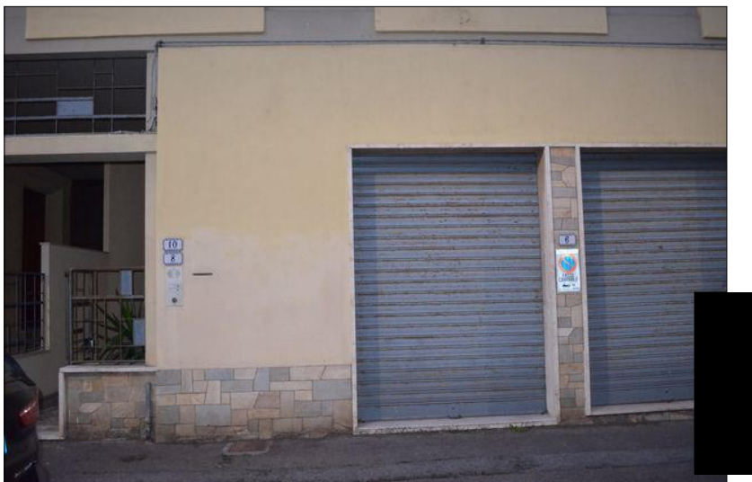
Vista A accesso esterno del magazzino in oggetto
