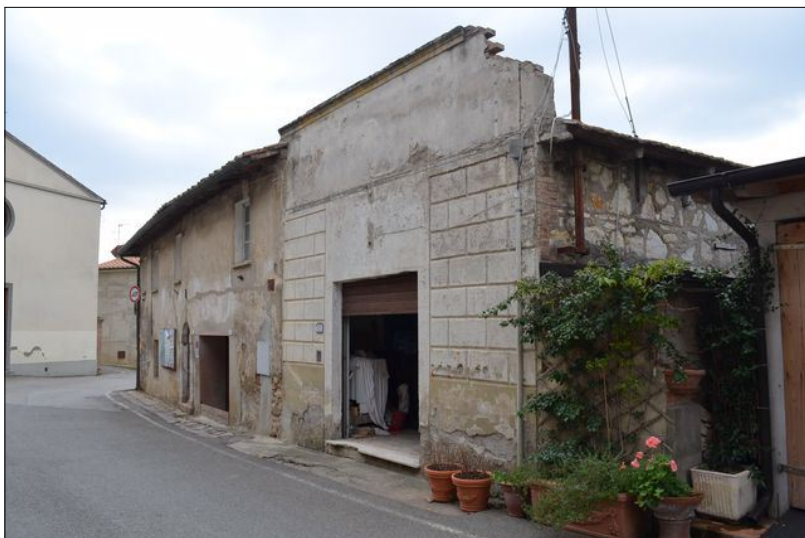
Vista A esterno del fabbricato in oggetto
