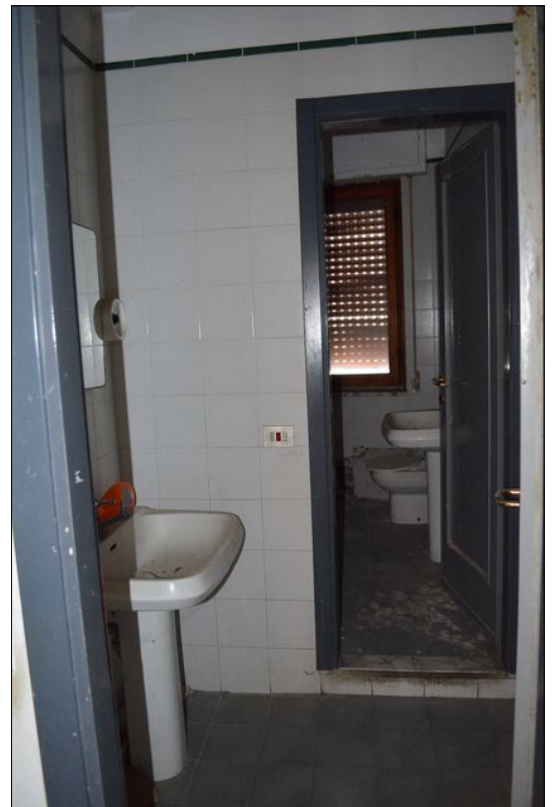
Vista P bagno
