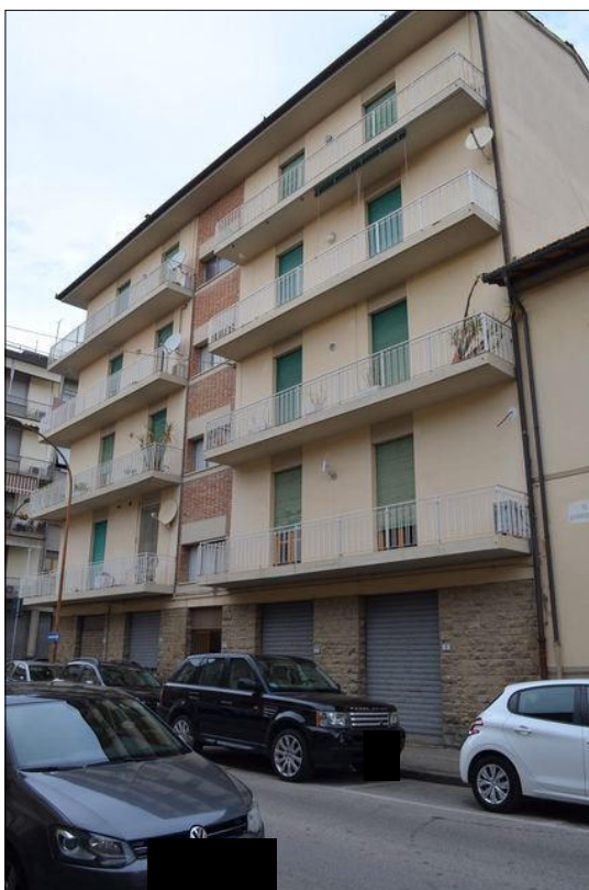
Vista A esterno del fabbricato in oggetto
