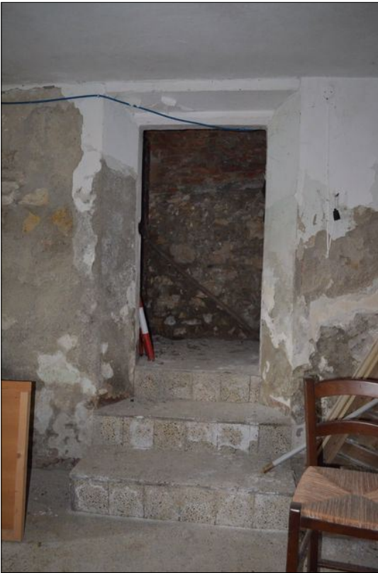
Vista D apertura di accesso al negozio
