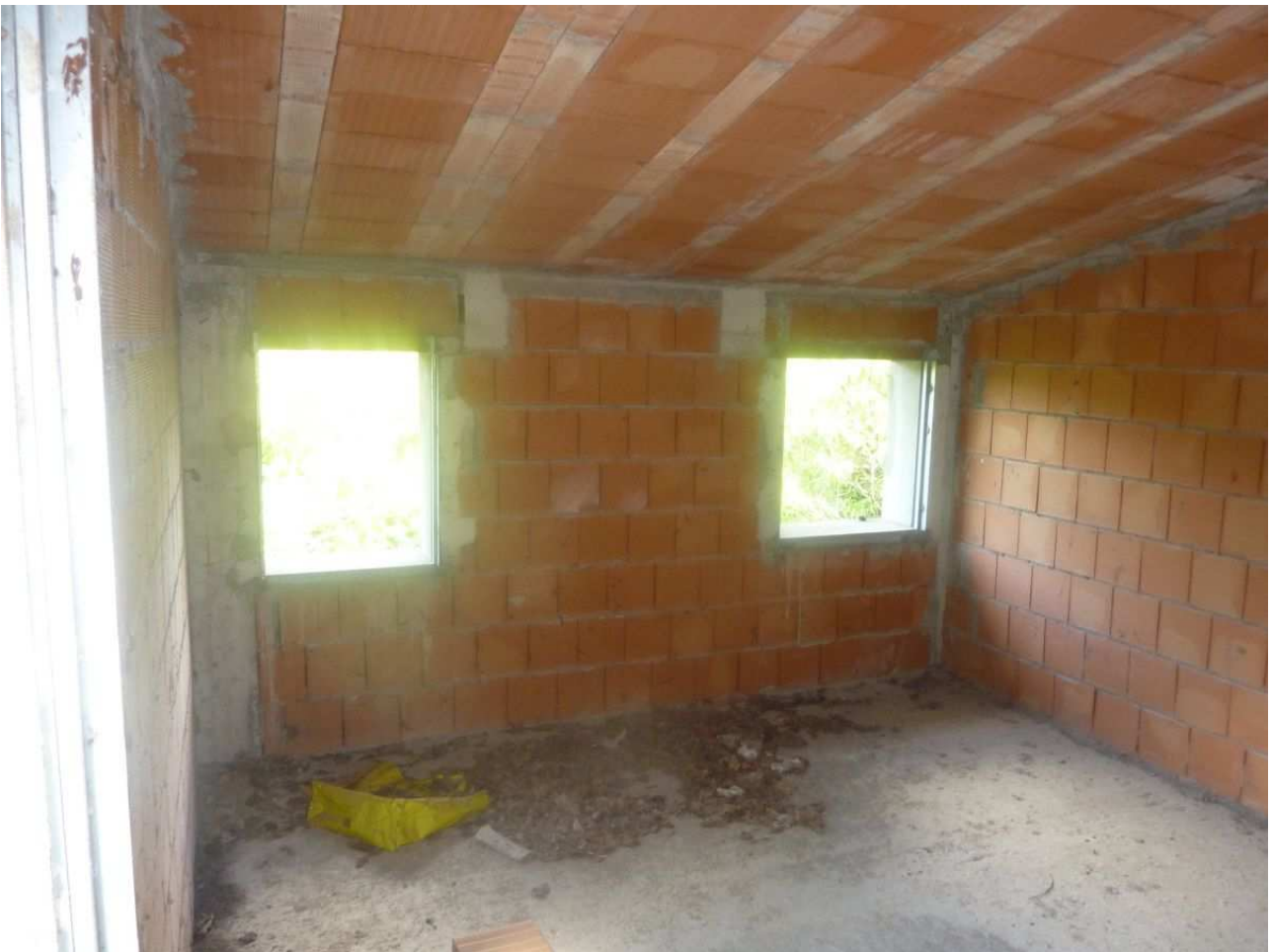
41. Sottotetto villetta centrale n. 3
