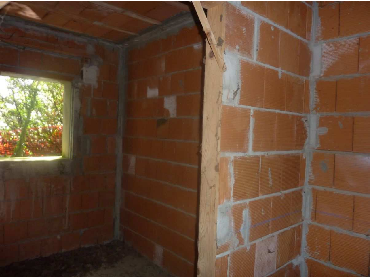
37. Bagno p.t. villetta centrale n. 3
