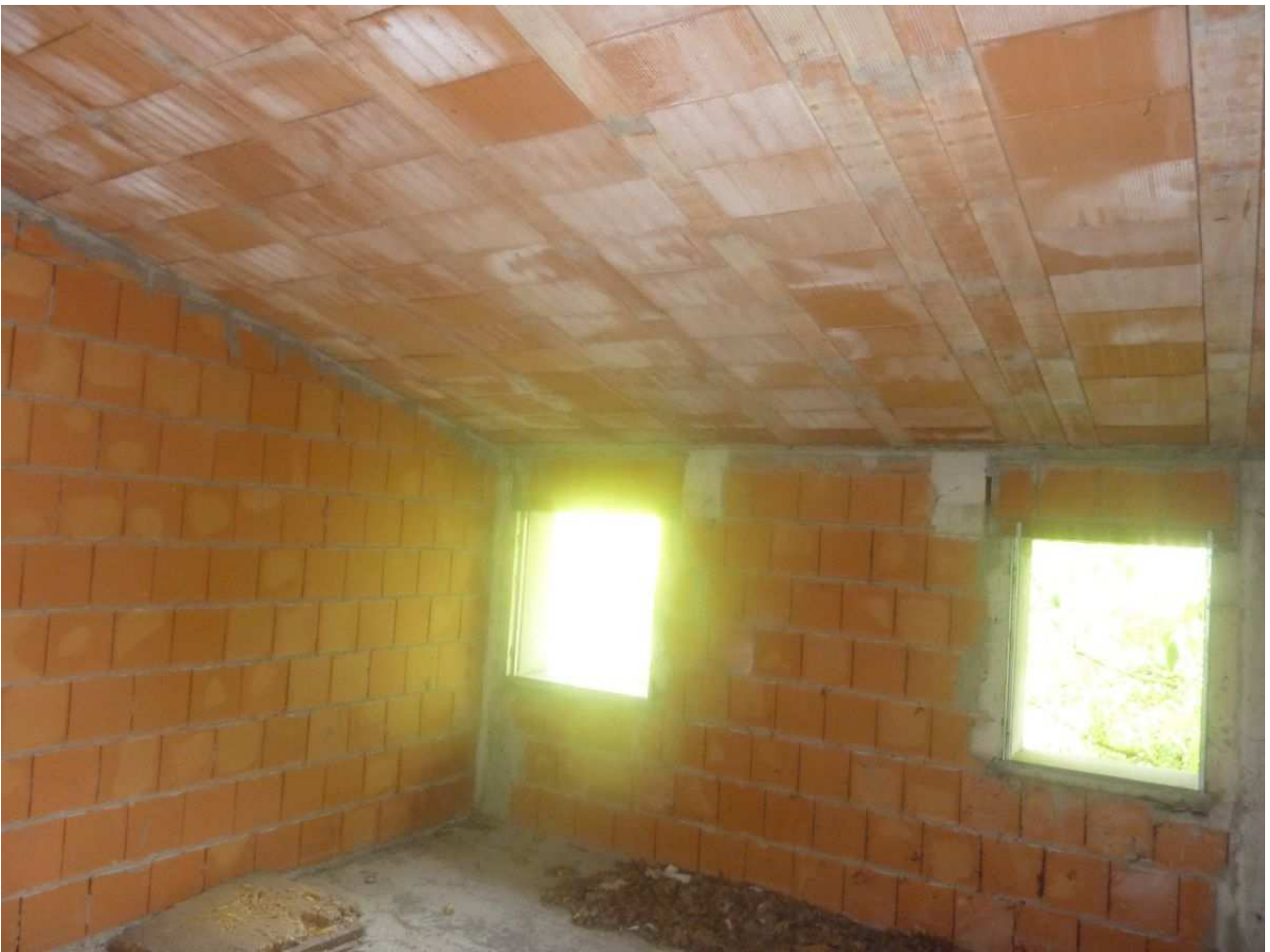
30. Sottotetto villetta centrale n. 2
