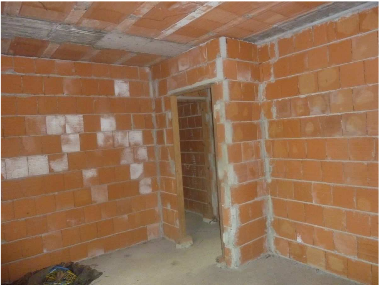
58. Camera p.t. villetta centrale n. 5
