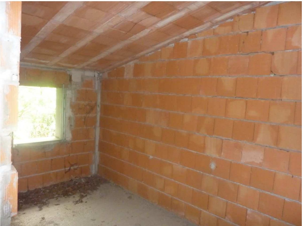
39. Sottotetto villetta centrale n. 3
