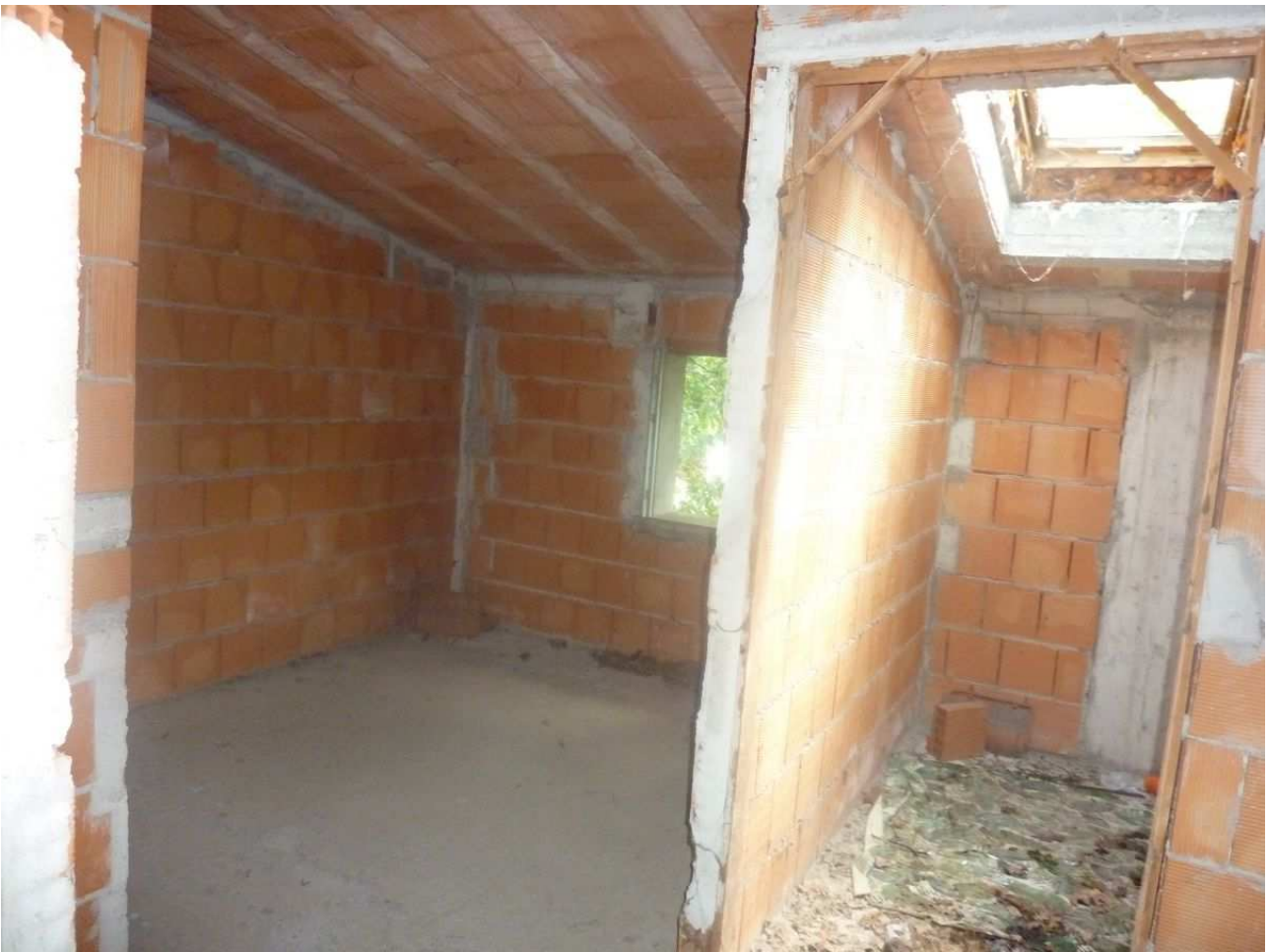
38. Sottotetto villetta centrale n. 3
