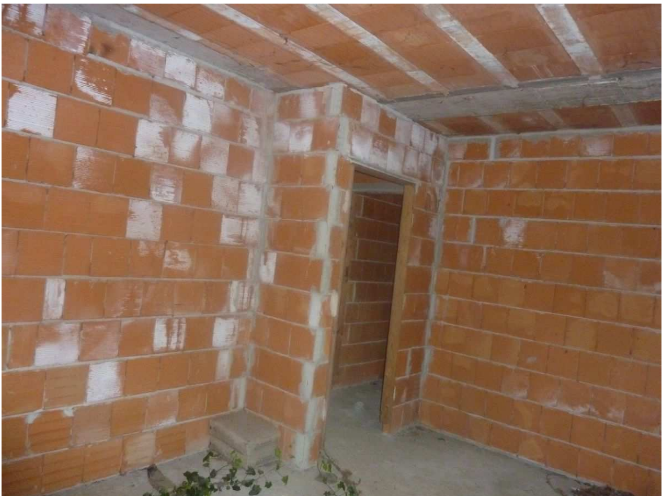
47. Camera p.t. villetta centrale n. 4
