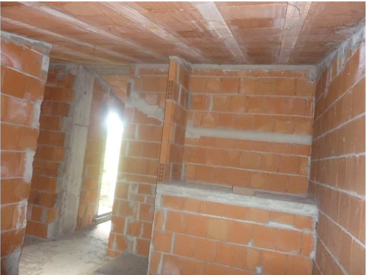
40. Sottotetto villetta centrale n. 3
