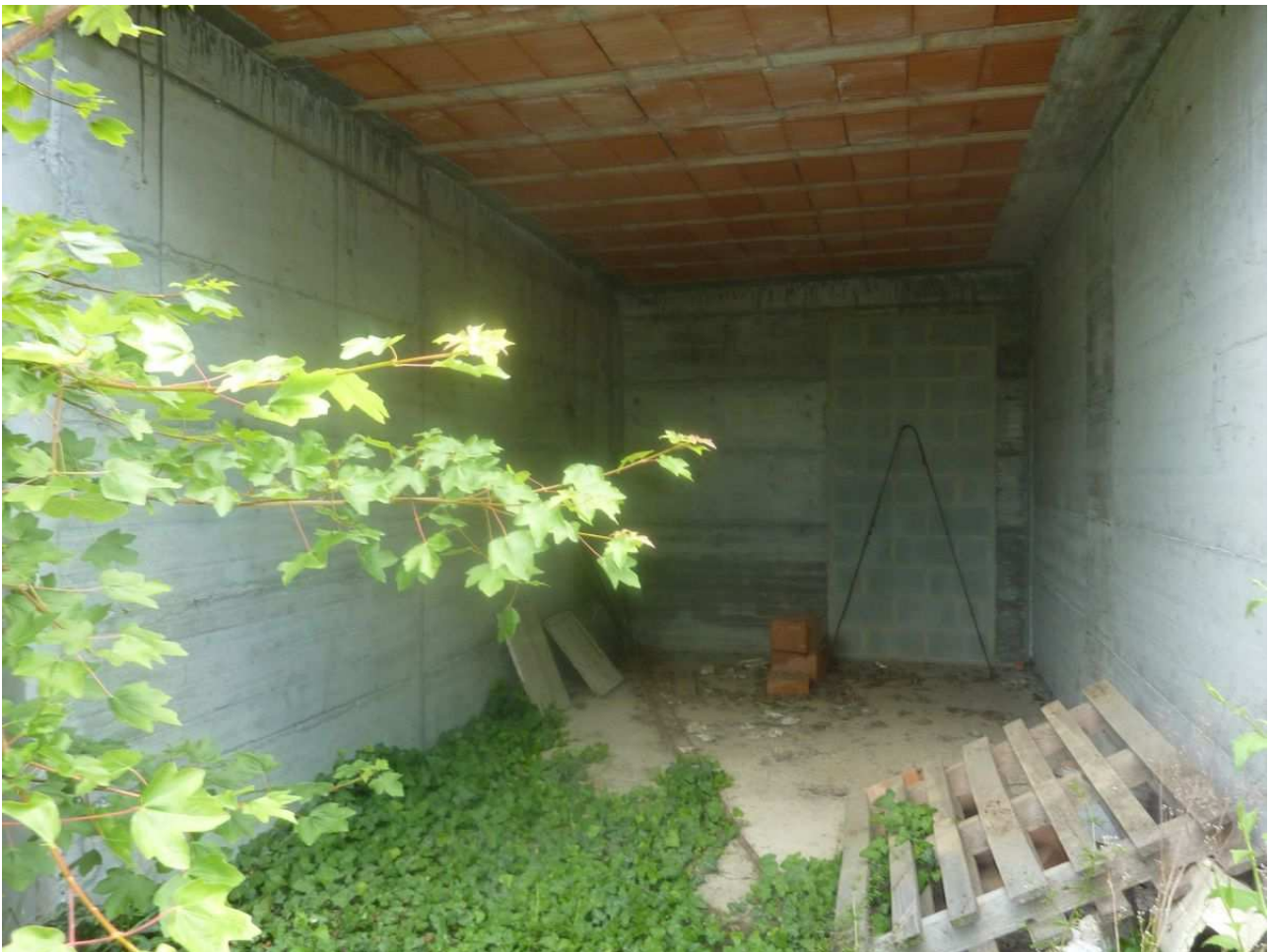
65. Autorimessa villetta centrale n. 5
