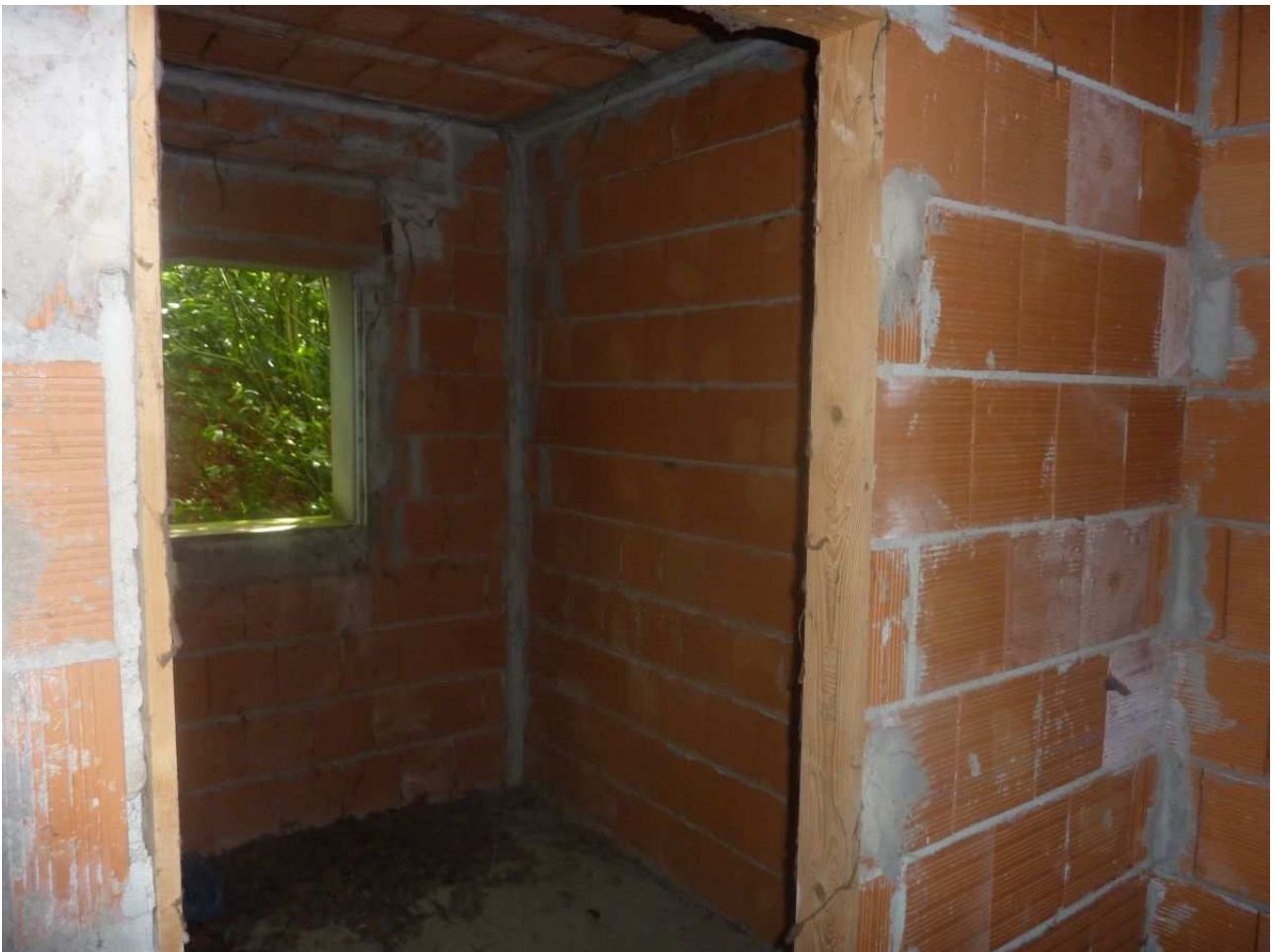
59. Bagno p.t. villetta centrale n. 5
