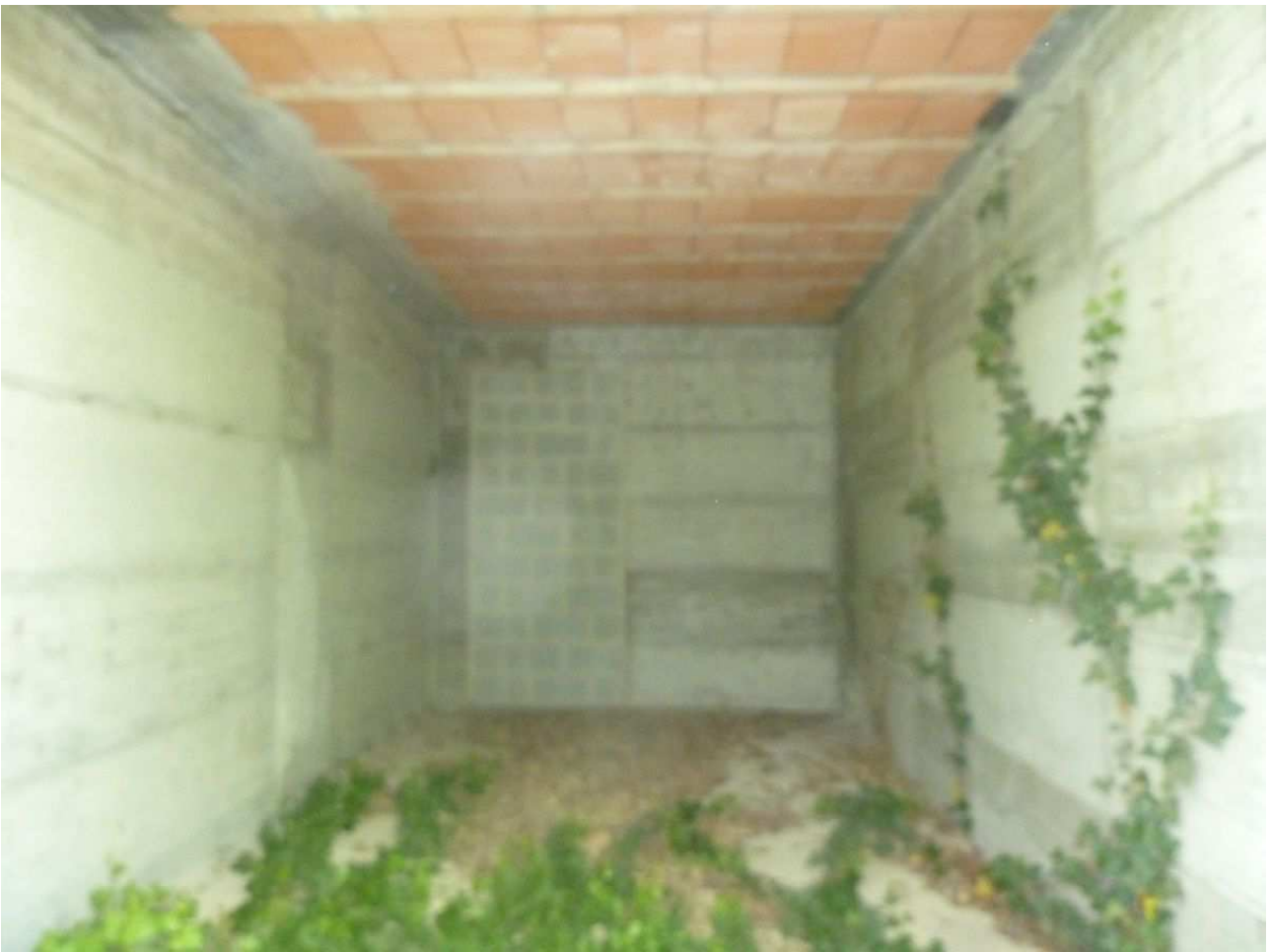
32. Autorimessa villetta centrale n. 2
