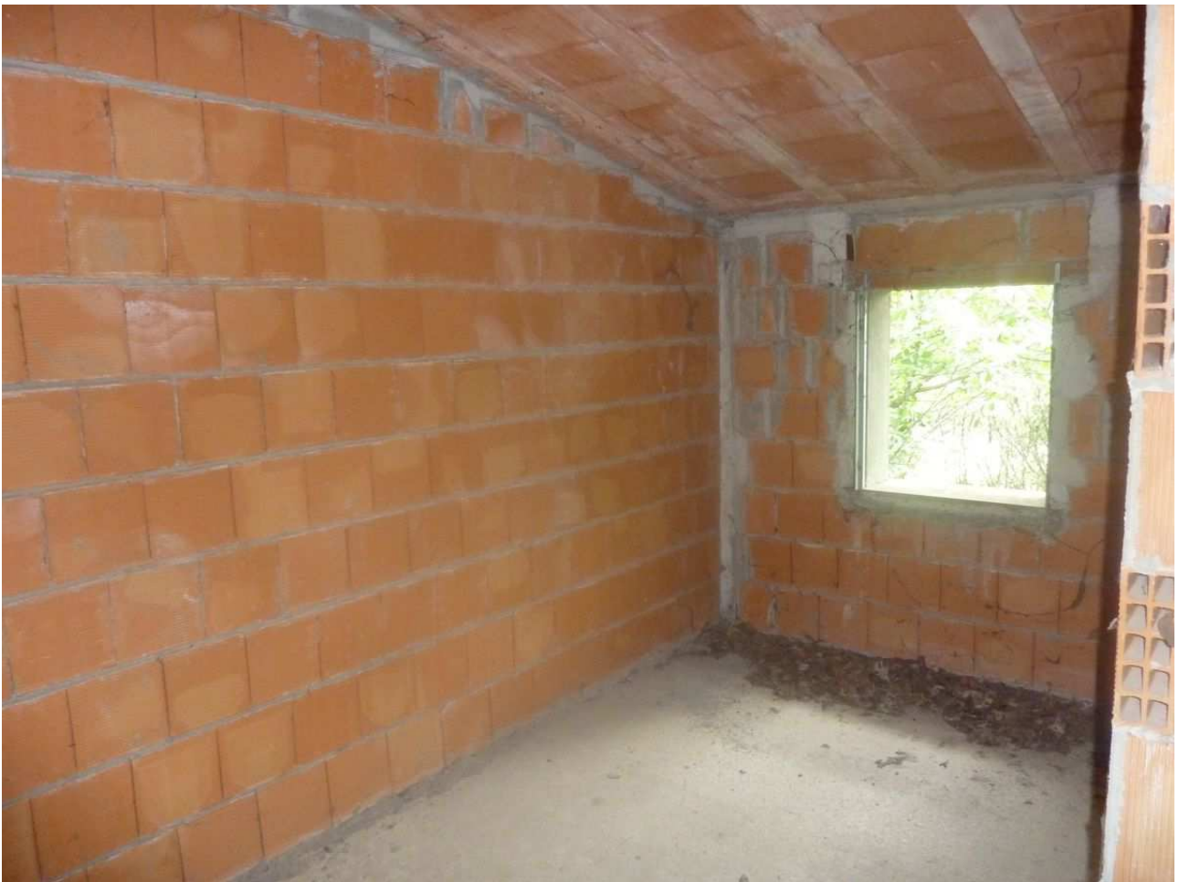
50. Sottotetto villetta centrale n. 4
