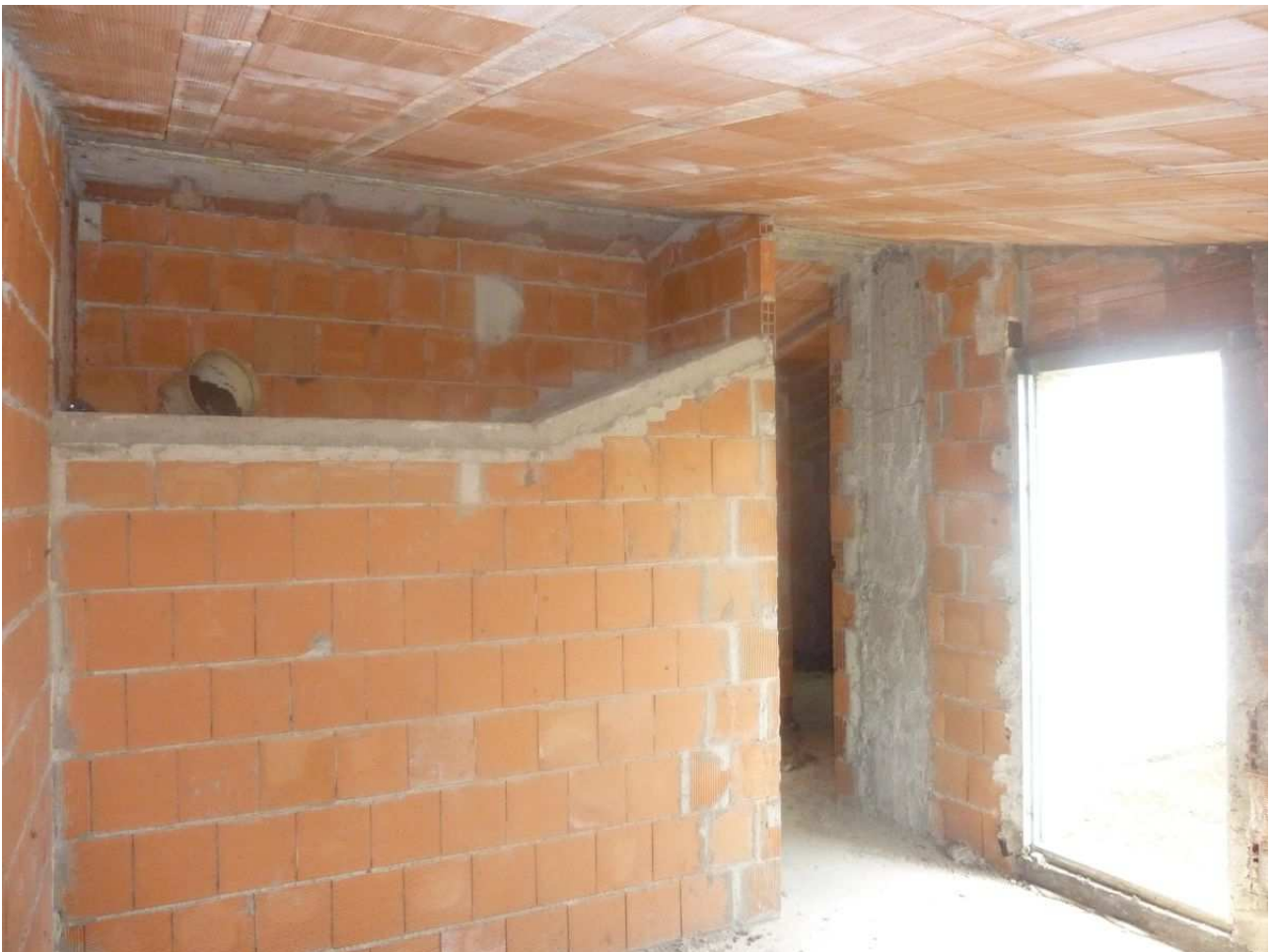
63. Sottotetto villetta centrale n. 5
