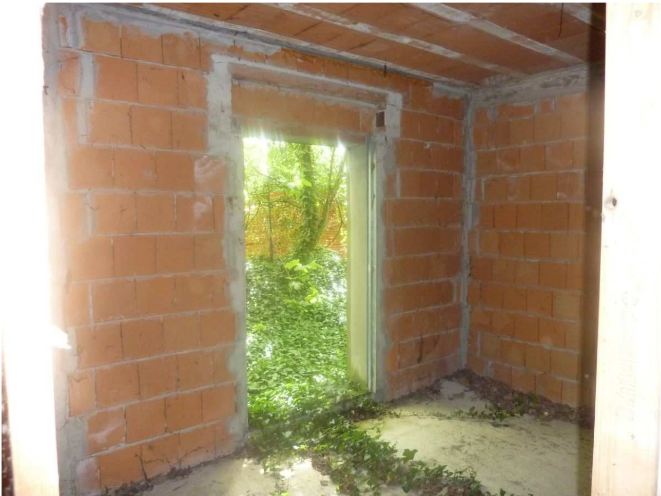
46. Camera p.t. villetta centrale n. 4
