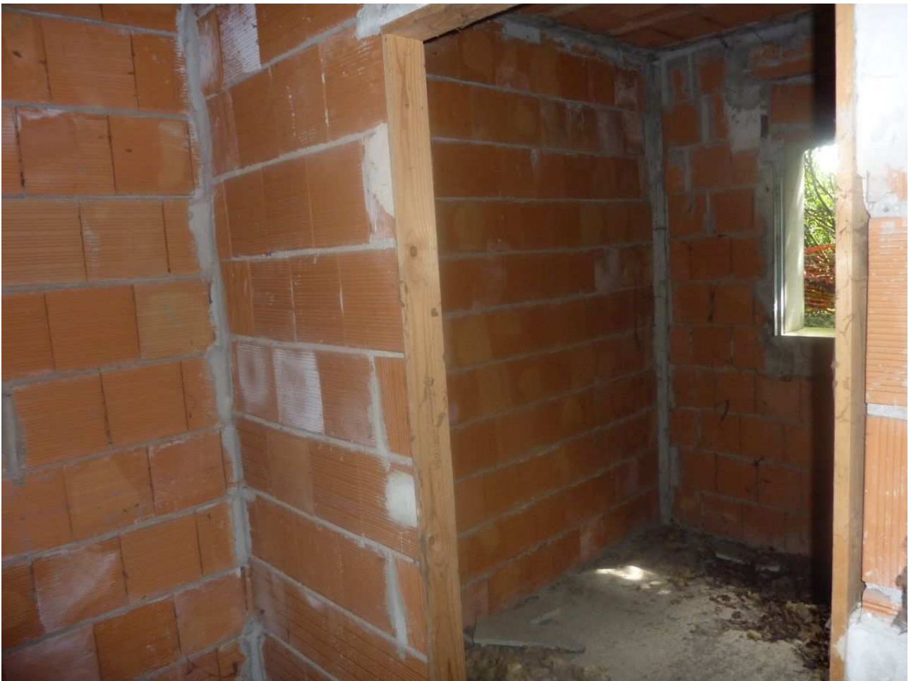
48. Bagno p.t. villetta centrale n. 4
