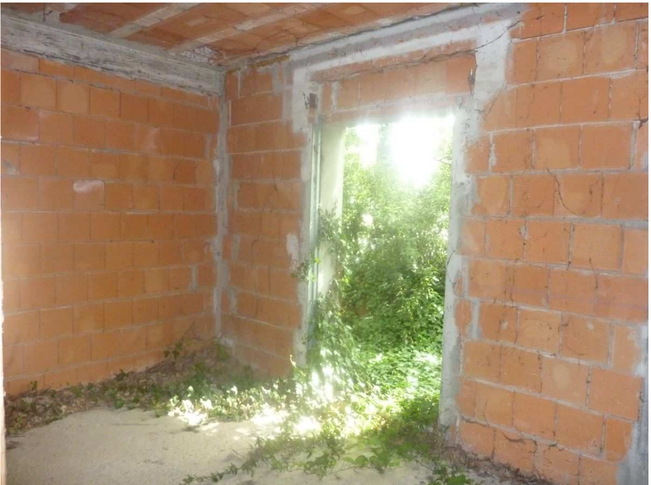
35. Camera p.t. villetta centrale n. 3
