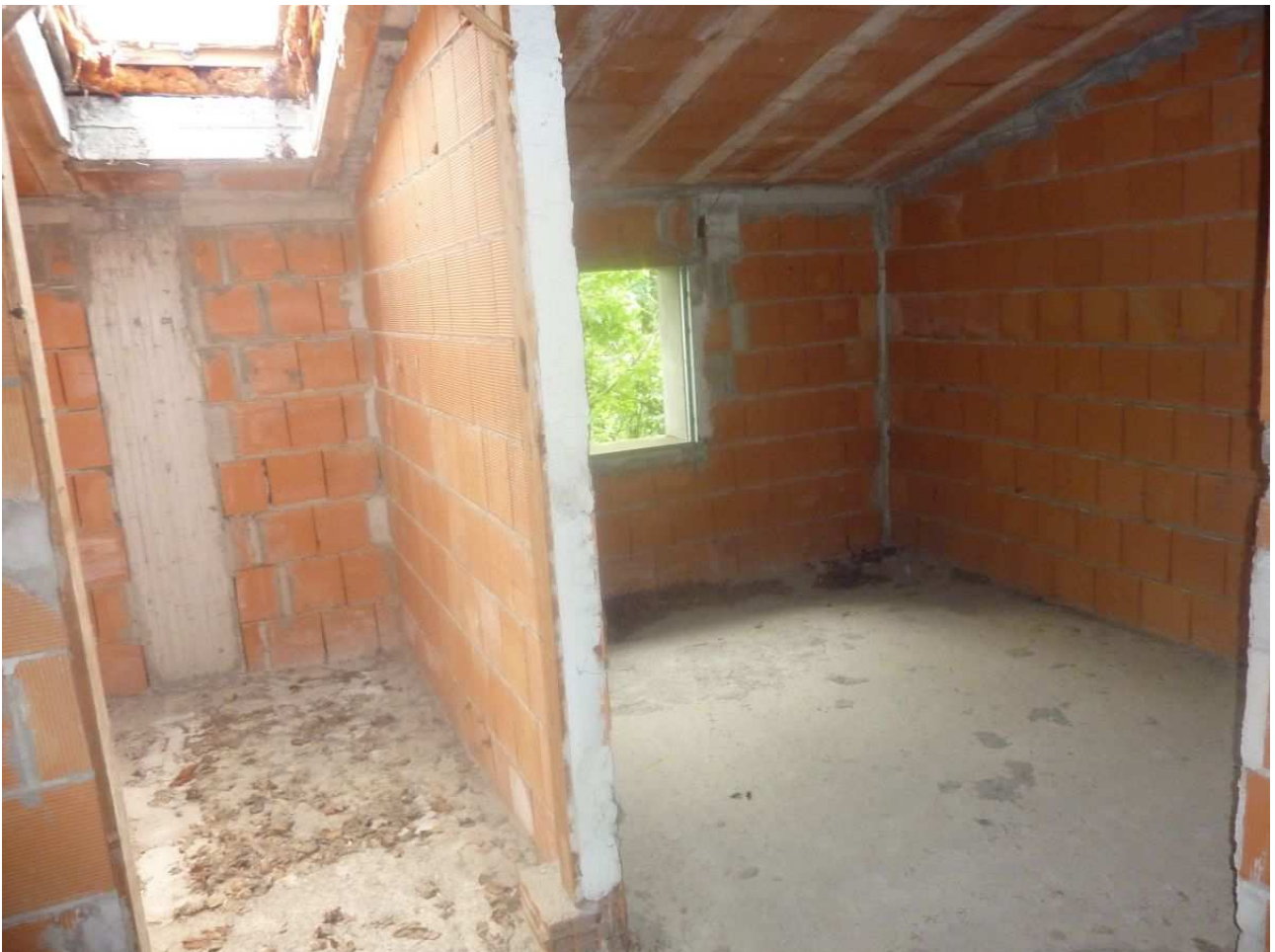
49. Sottotetto villetta centrale n. 4
