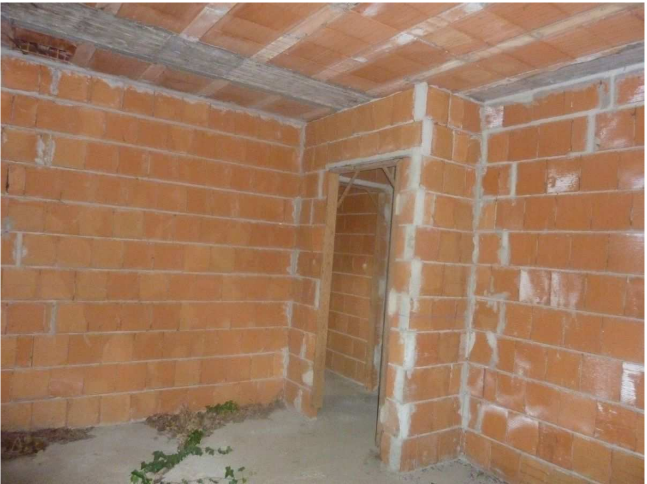
36. Camera p.t. villetta centrale n. 3
