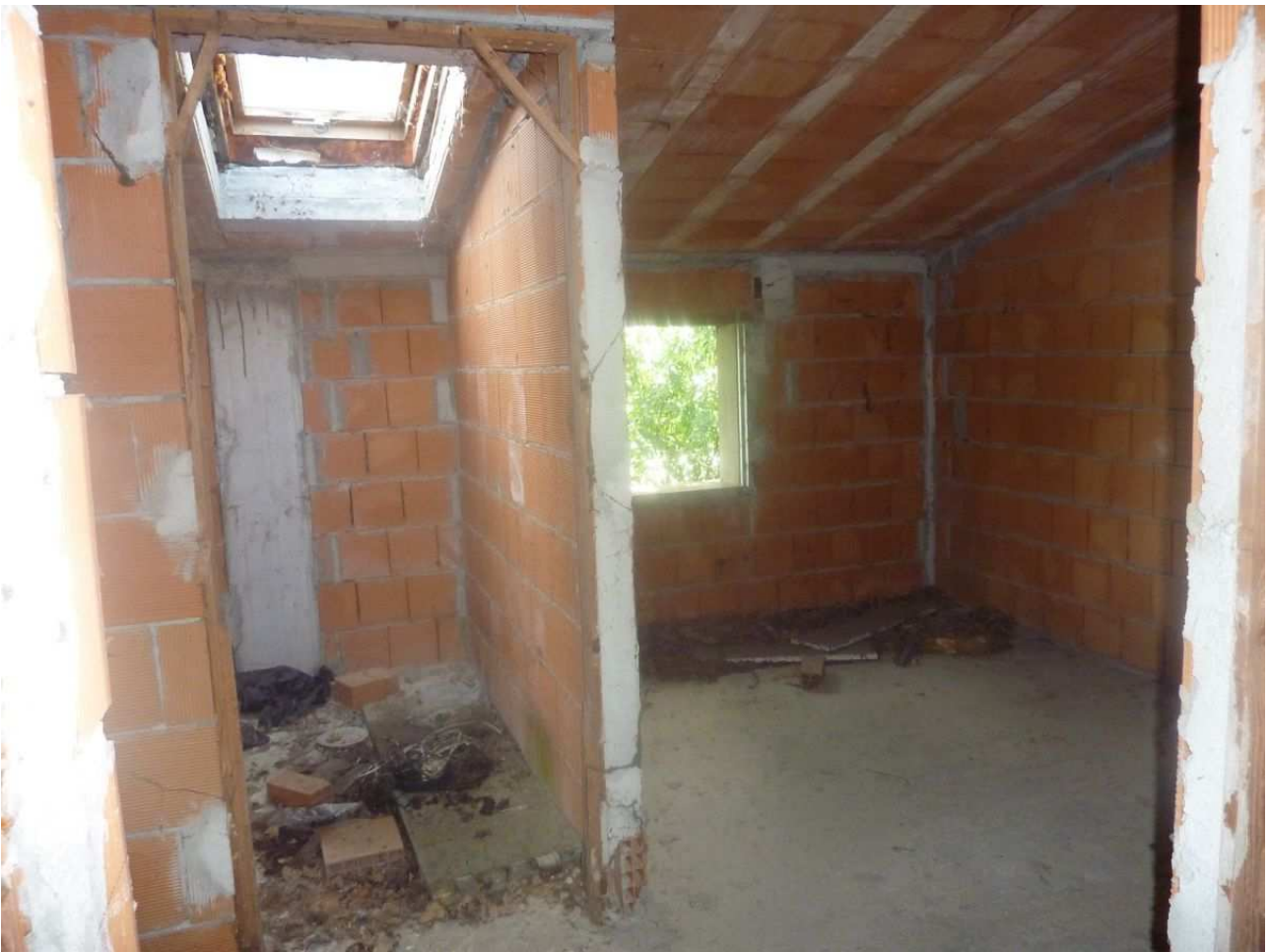
28. Sottotetto villetta centrale n. 2
