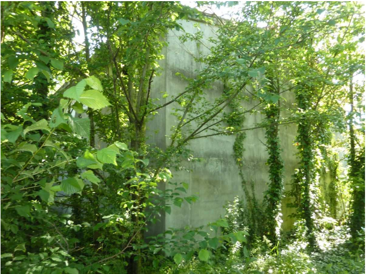
12. Spigolo Nord-Est della villetta a schiera di testa lato Nord
