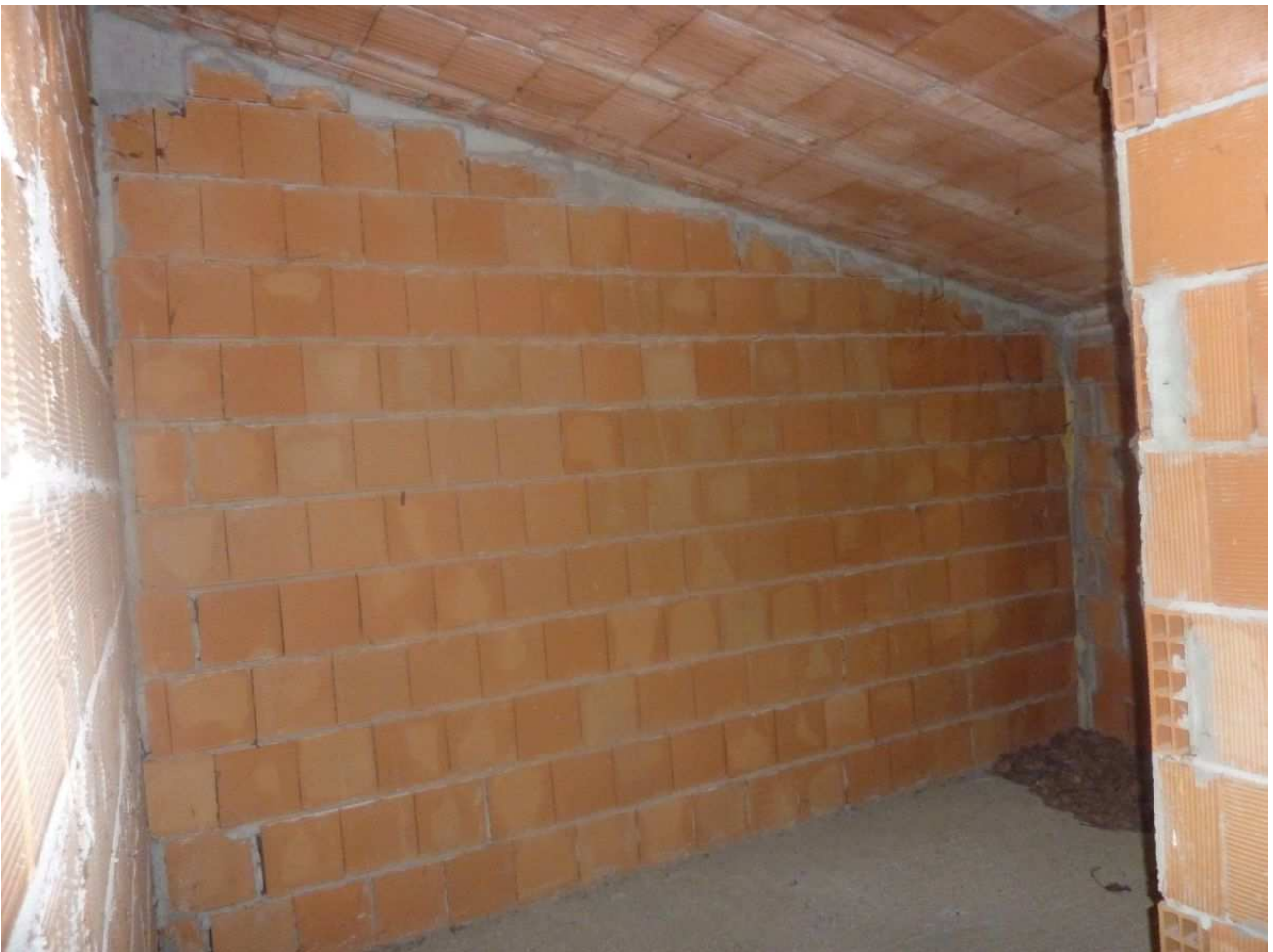
29. Sottotetto villetta centrale n. 2
