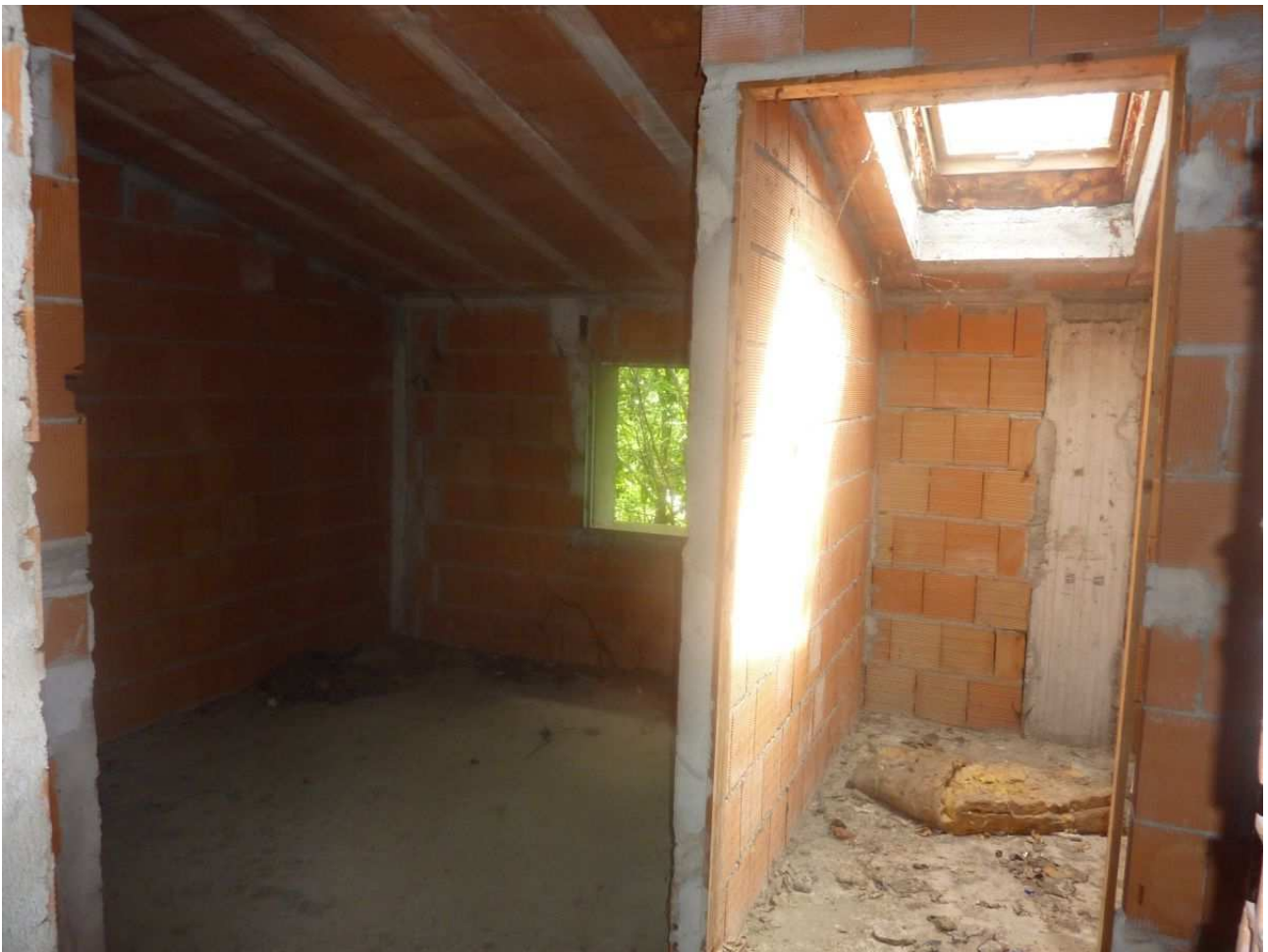
60. Sottotetto villetta centrale n. 5
