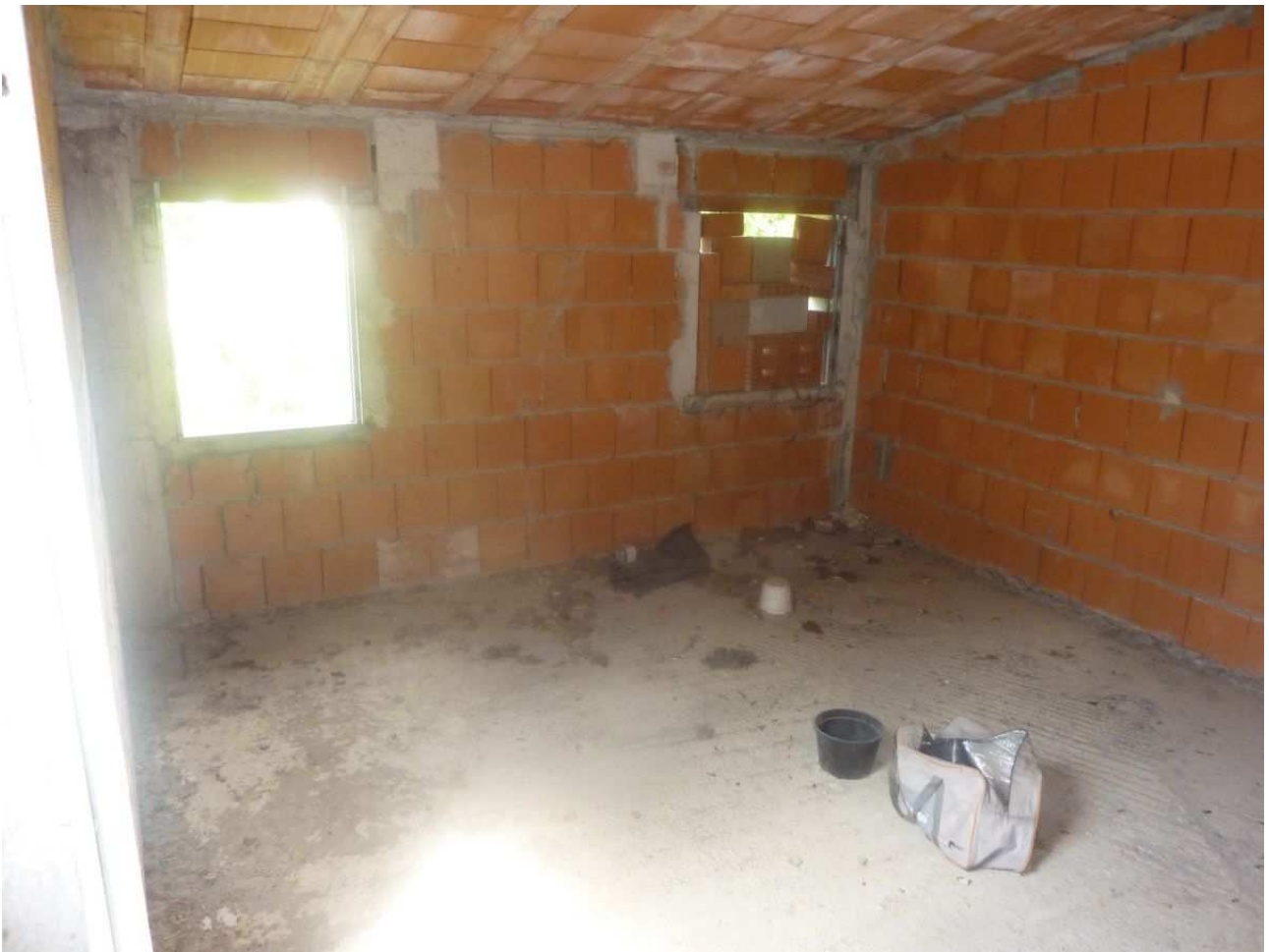
62. Sottotetto villetta centrale n. 5
