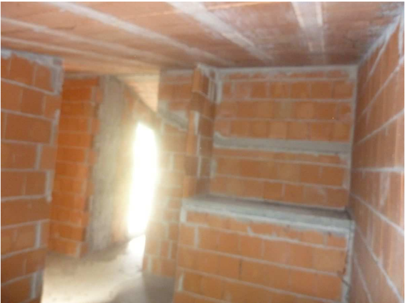
61. Sottotetto villetta centrale n. 5
