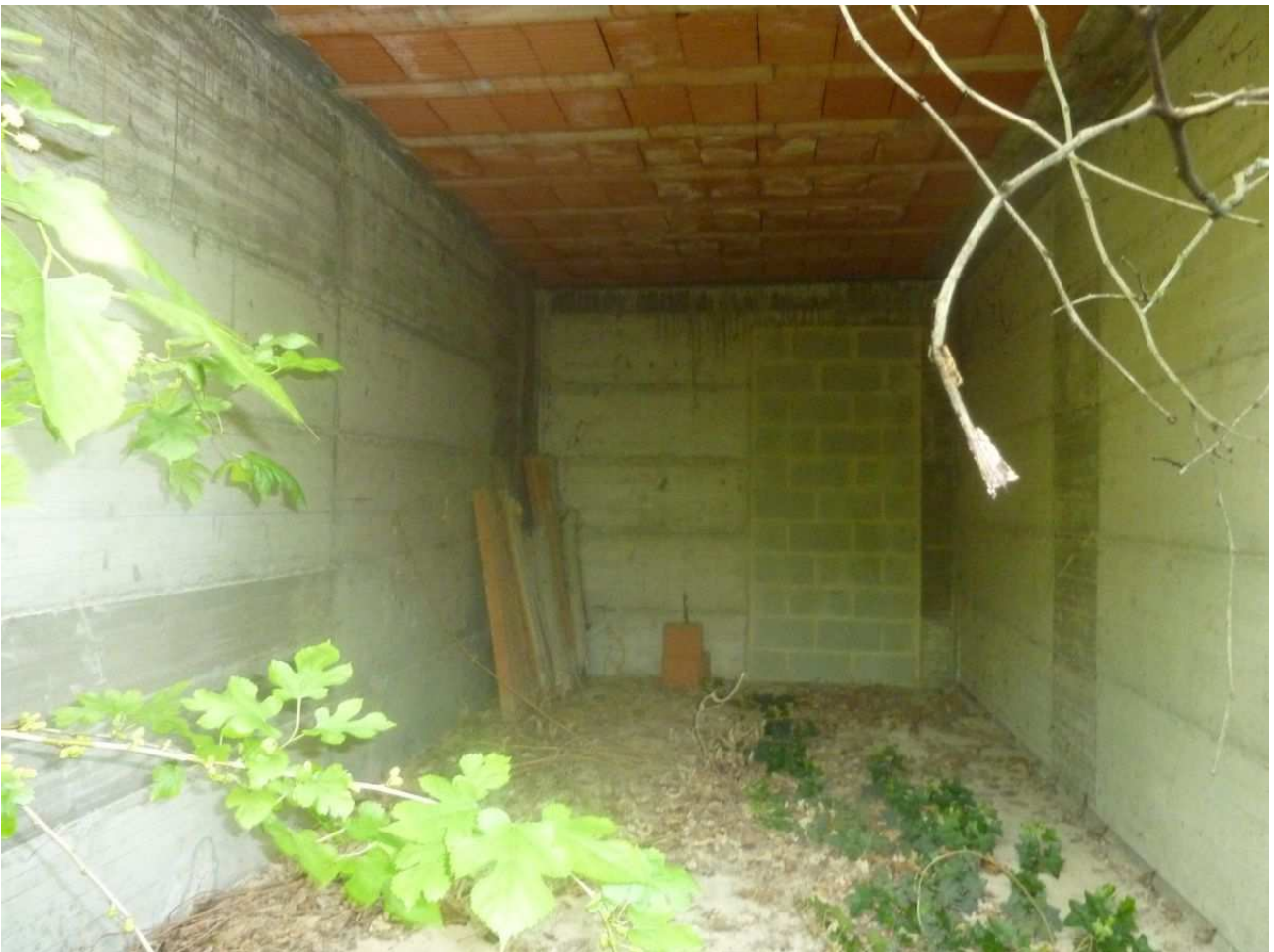
43. Autorimessa villetta centrale n. 3
