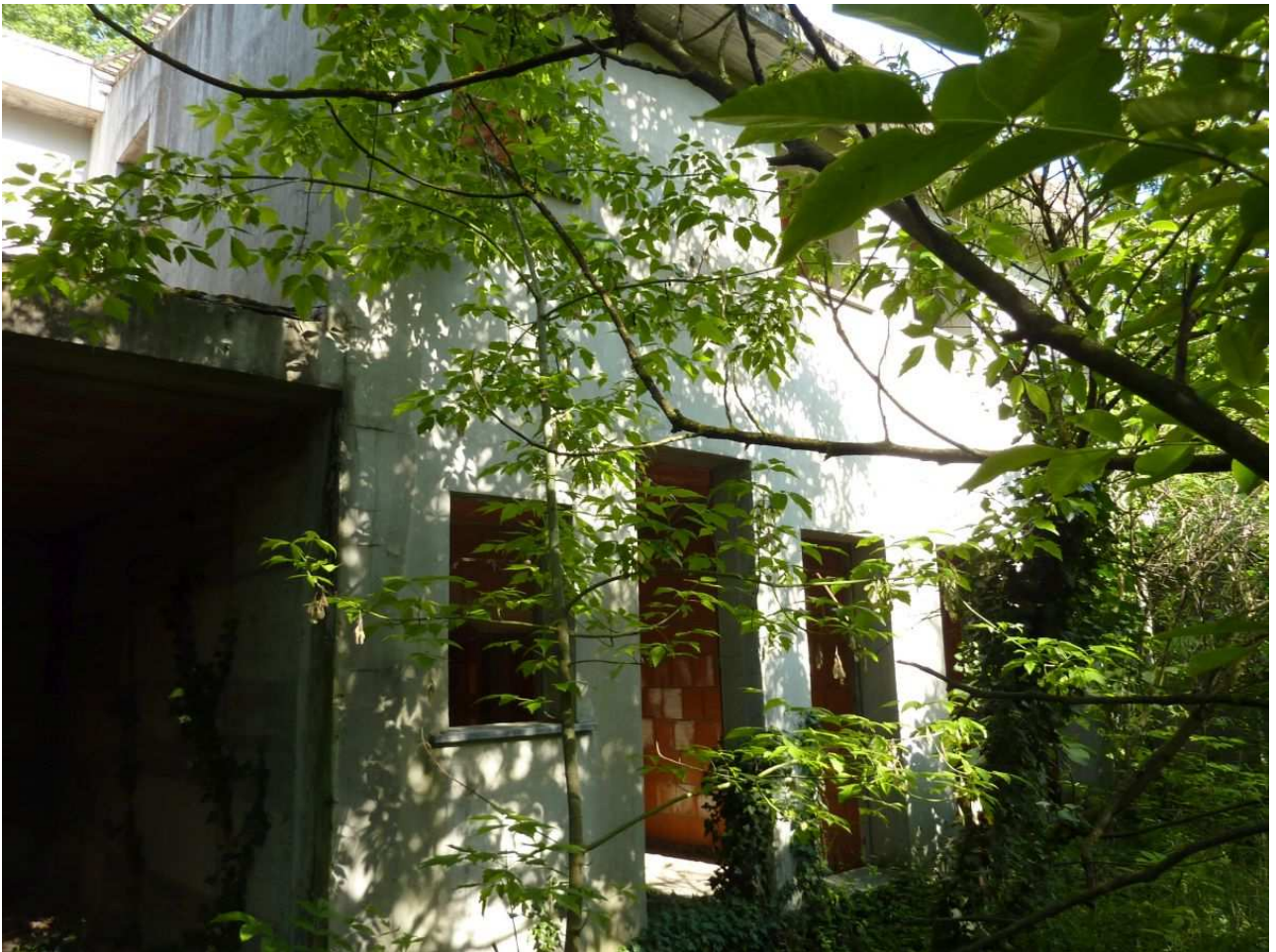
8. Fronte Ovest di un'altra villetta a schiera con relativa autorimessa
