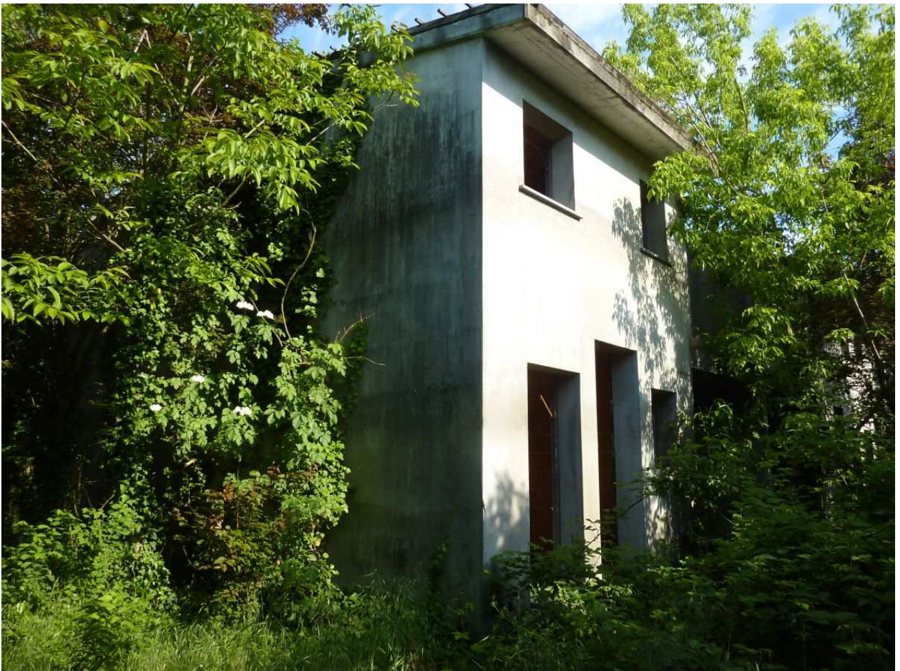
11. Spigolo Nord-Ovest della villetta a schiera di testa lato Nord
