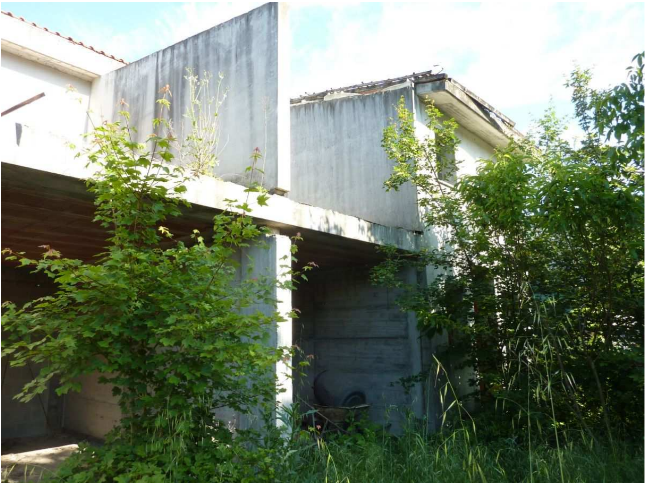
6. Fronte Ovest con gli accessi a due autorimesse
