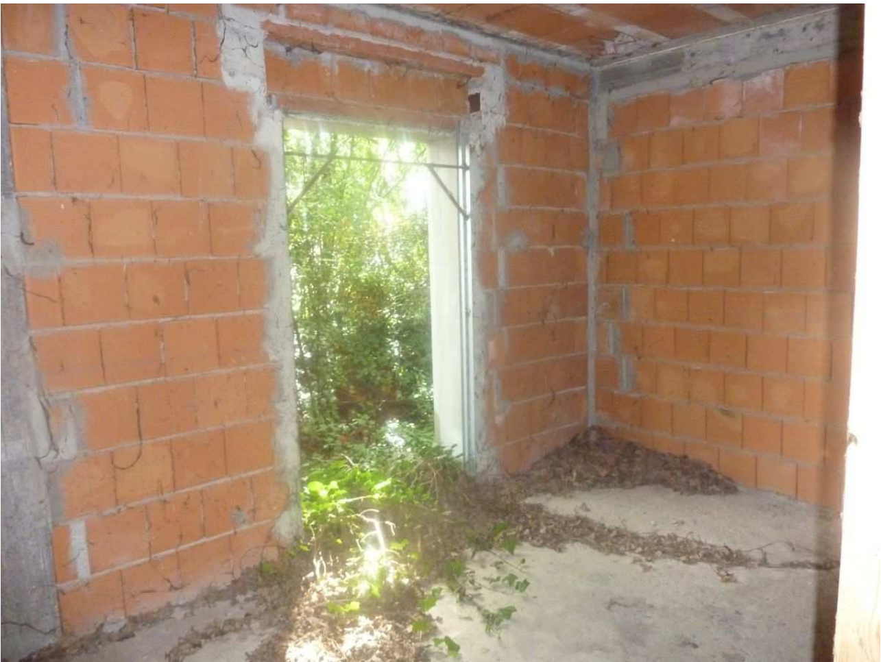
26. Camera p.t. villetta centrale n. 2
