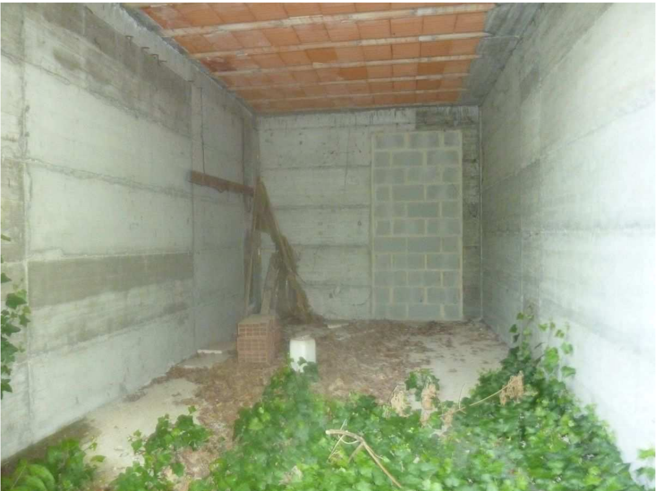
23. Autorimessa villetta di testa n. 1
