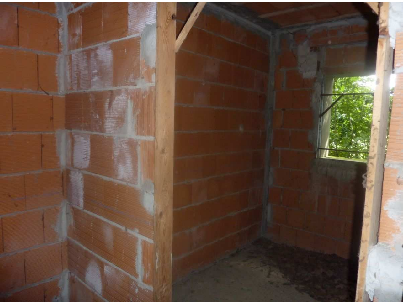
27. Bagno p.t. villetta centrale n. 2
