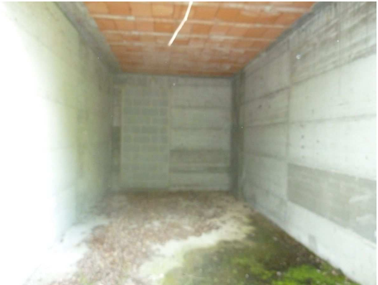
54. Autorimessa villetta centrale n. 4
