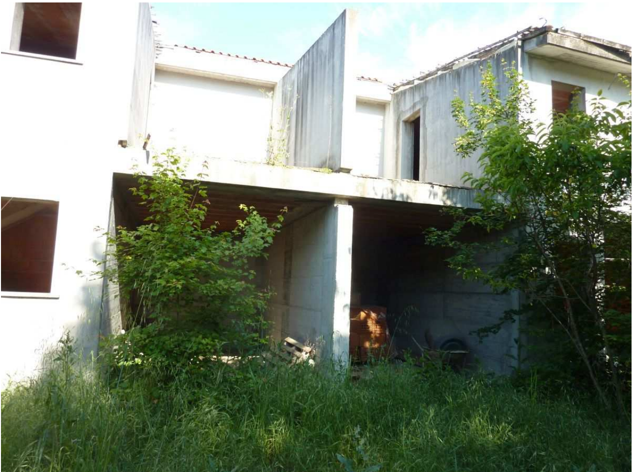
7. Autorimesse delle villette a schiera centrali
