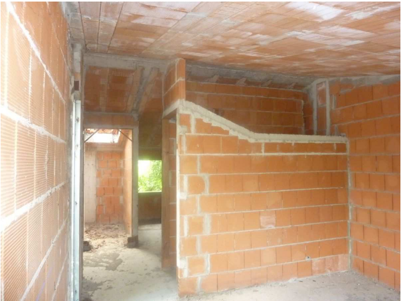
52. Sottotetto villetta centrale n. 4
