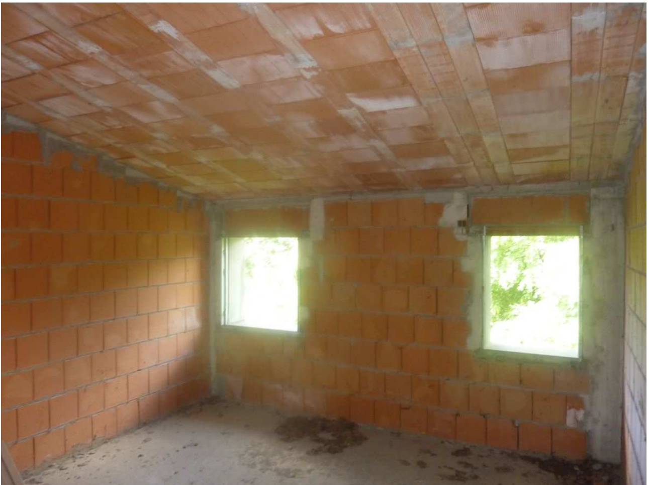
51. Sottotetto villetta centrale n. 4
