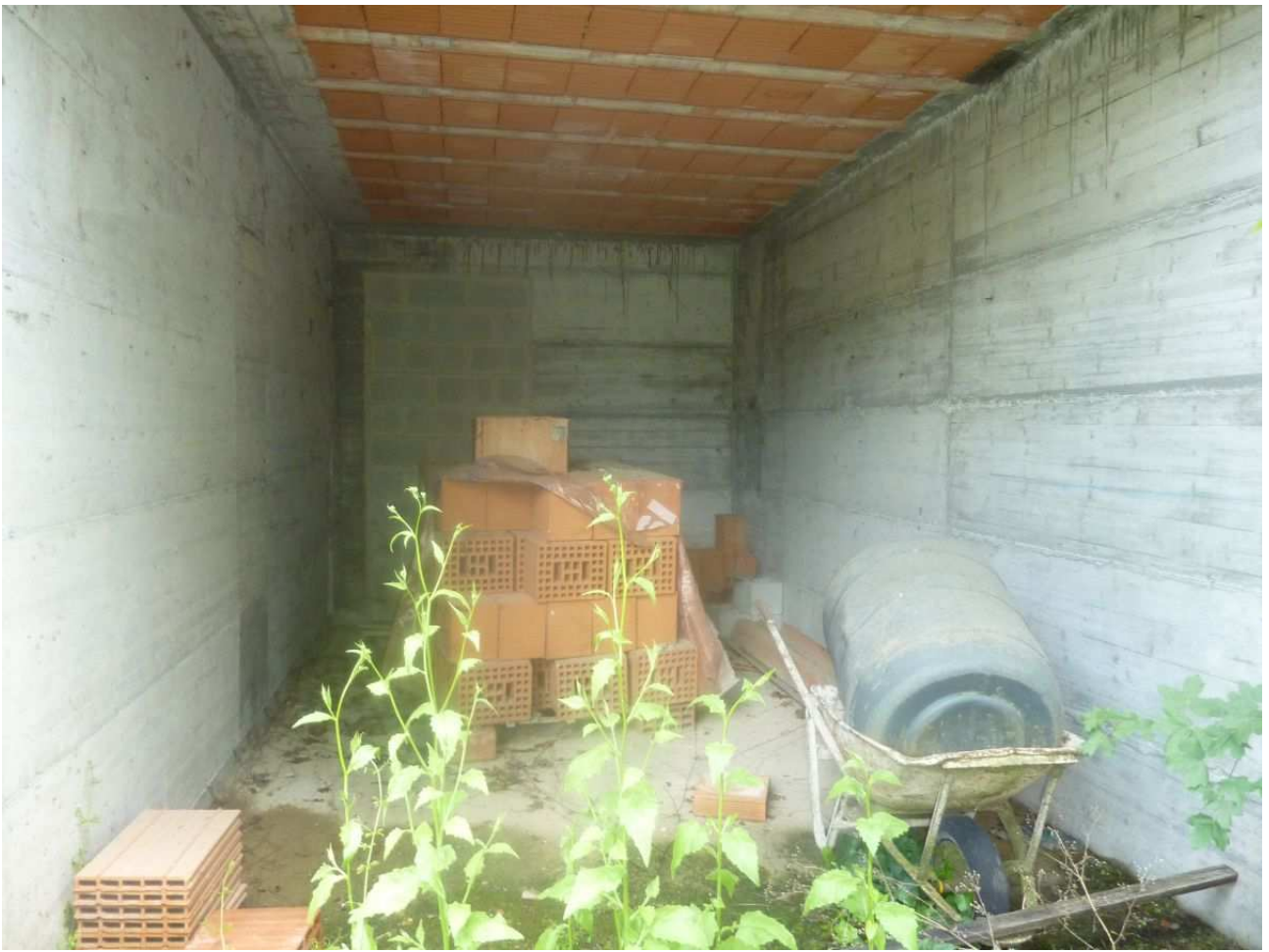
76. Autorimessa villetta di testa n. 6
