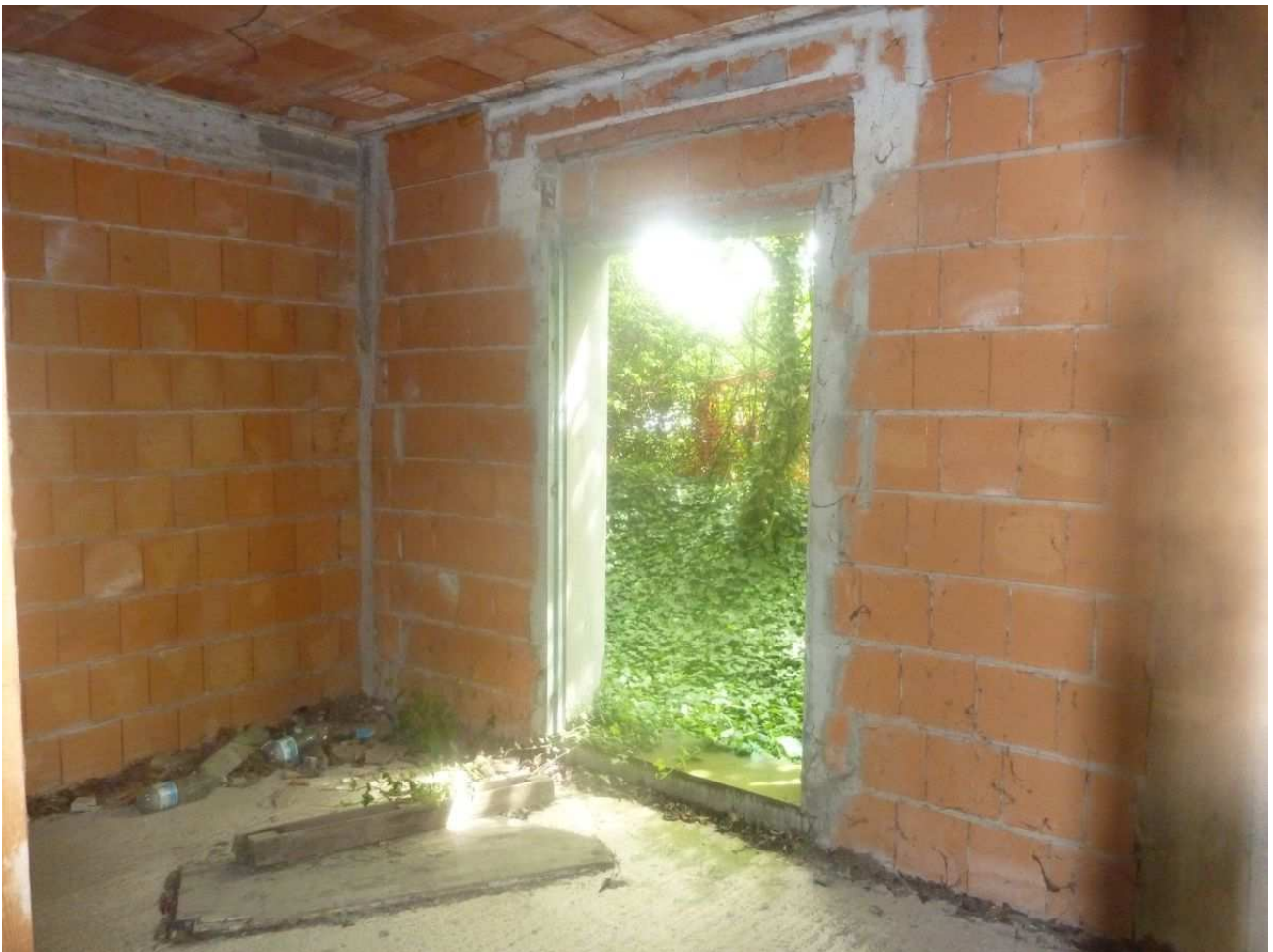
57. Camera p.t. villetta centrale n. 5
