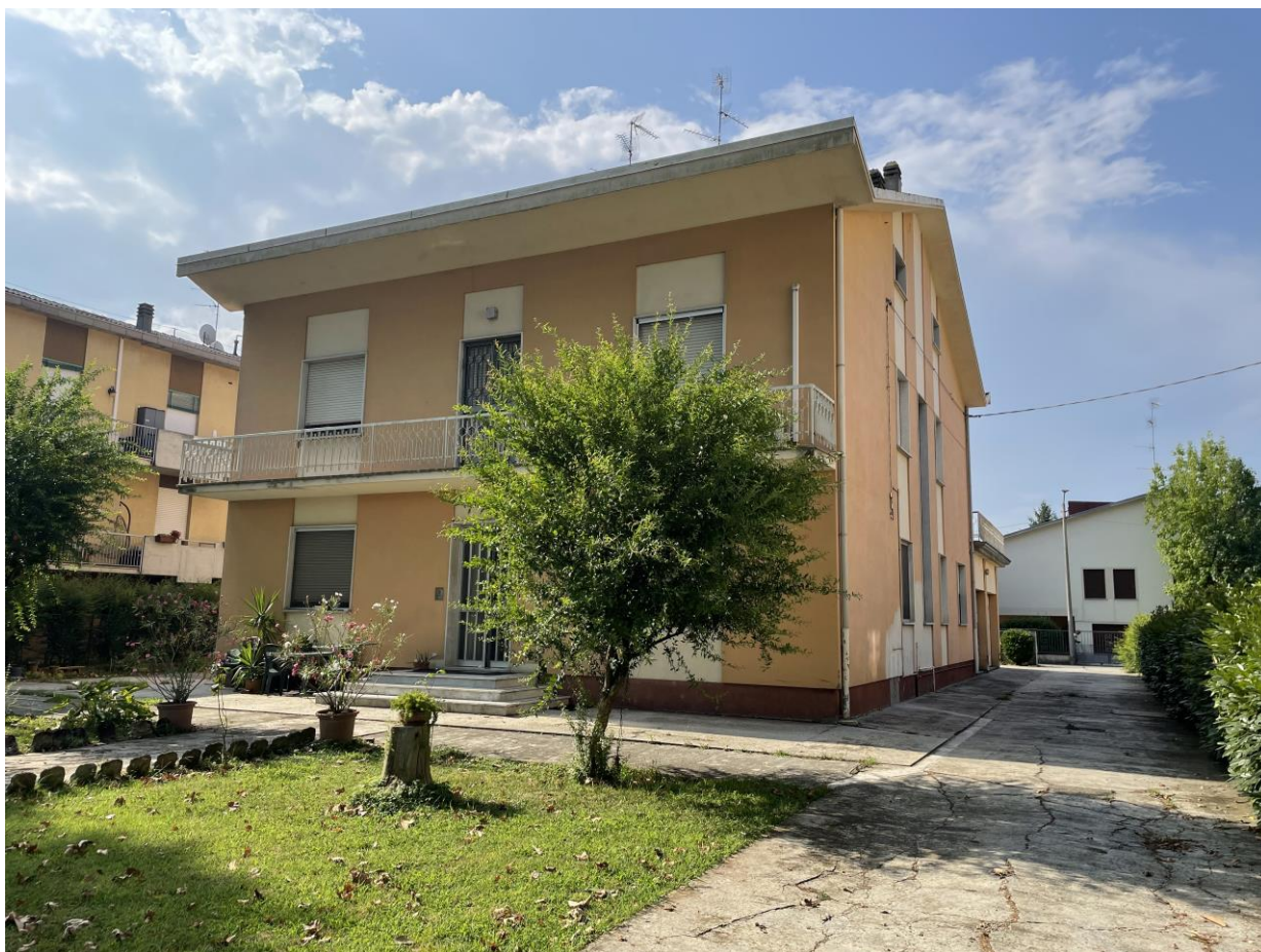
Foto 1 – Vista esterna del fabbricato – Fronte su viale Gramsci
