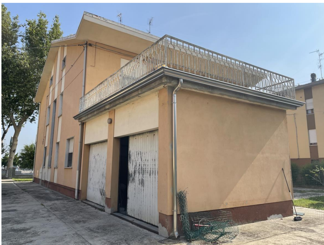
Foto 3 – Vista esterna del fabbricato – Autorimessa
