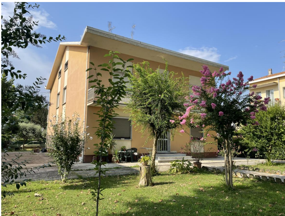
Foto 2 – Vista esterna del fabbricato – Fronte su viale Gramsci
