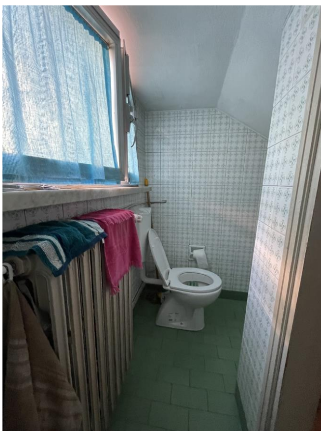
Foto 11 – PT – Bagno sottoscala
