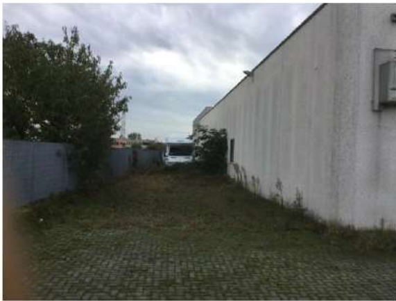
Foto 3 – Capannone artigianale – Lato nord-est
