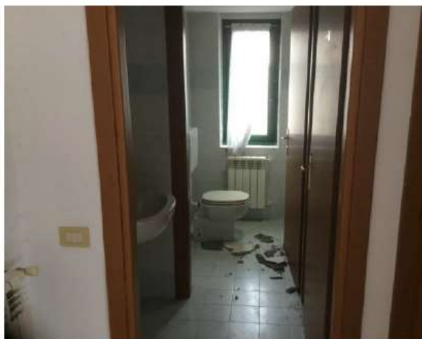
Foto 13 – Interno capannone – Bagno al P1
