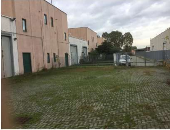
Foto 1 – Cortile con cancello d'ingresso
