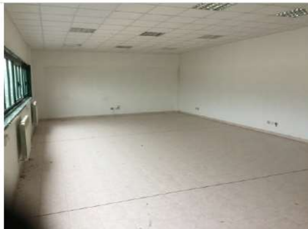
Foto 12 – Interno capannone – Ufficio al P1
