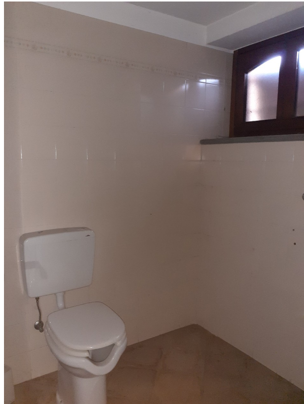
FOTO 11: INTERNO LOCALE COMMERCIALE
