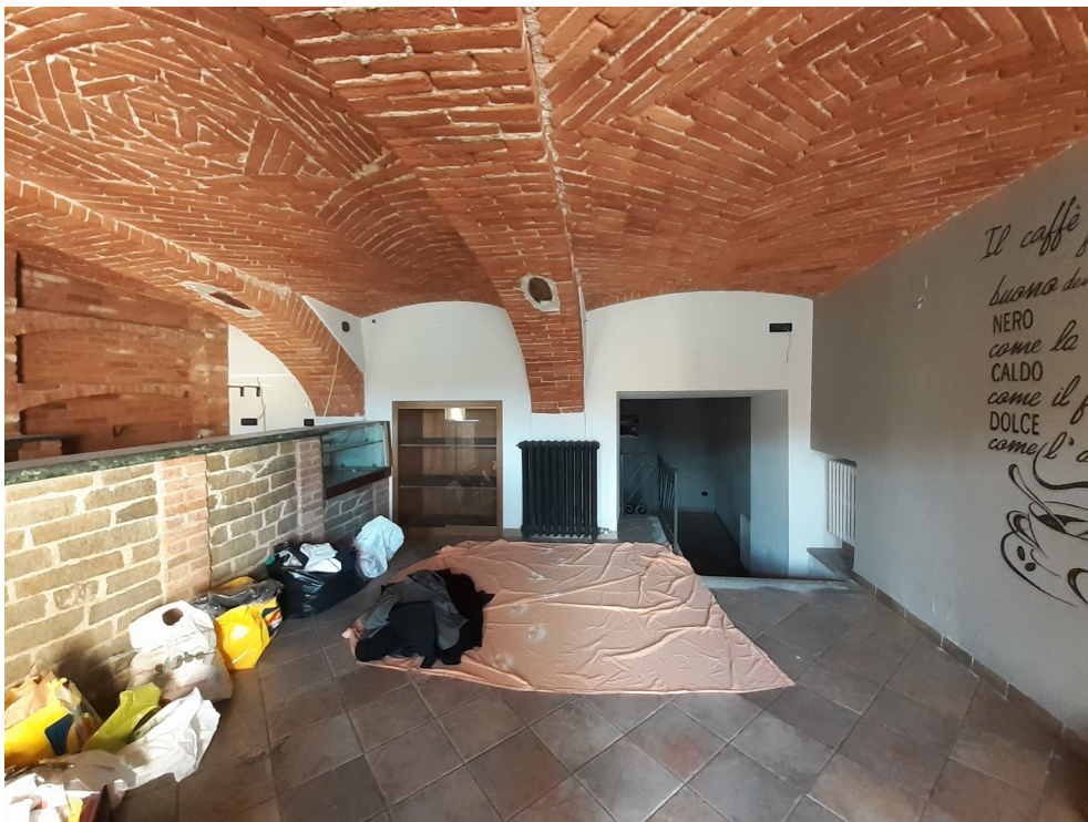
FOTO 6: INTERNO LOCALE COMMERCIALE
