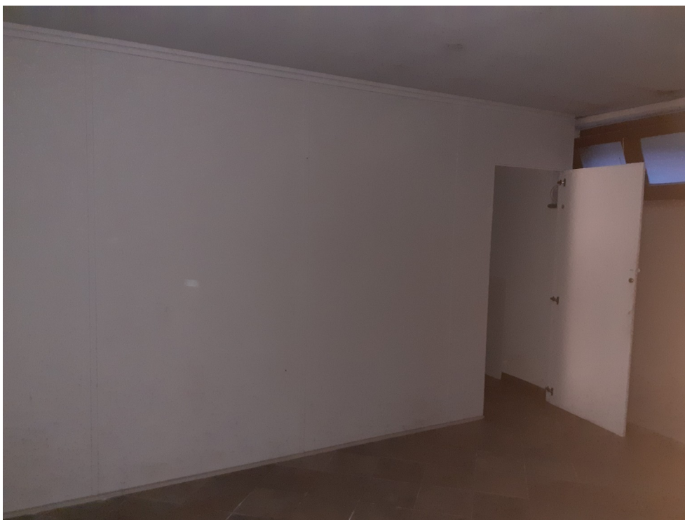
FOTO 10: INTERNO LOCALE COMMERCIALE
