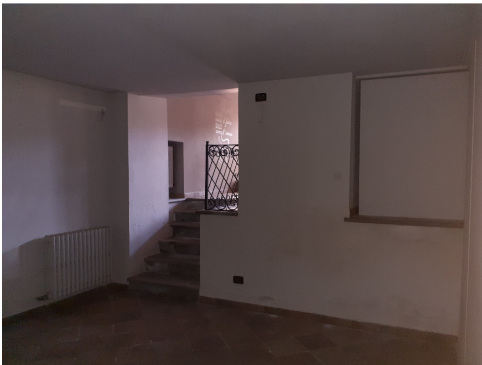
FOTO 9: INTERNO LOCALE COMMERCIALE
