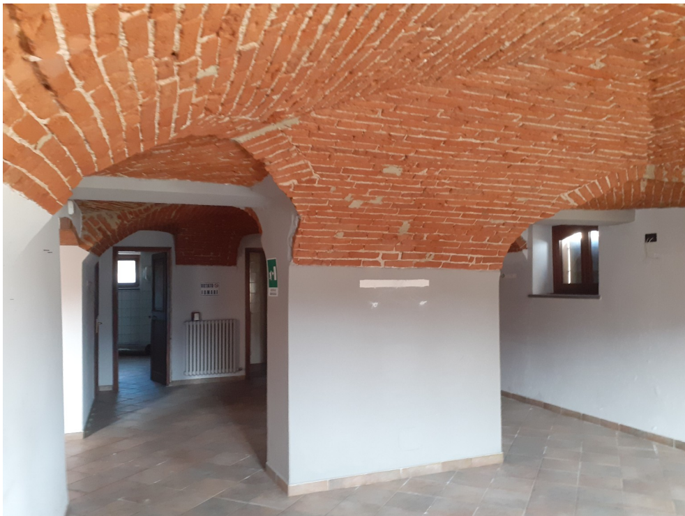
FOTO 12: INTERNO LOCALE COMMERCIALE
