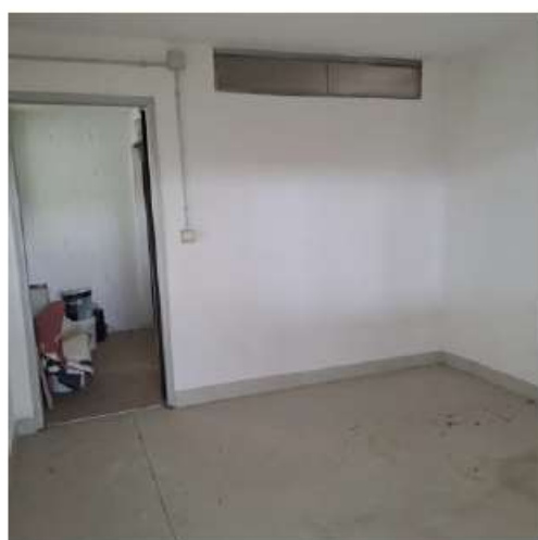
Foto 11 – Interno capannone – Ufficio
