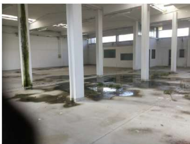
Foto 9 – Interno capannone – Parete sud - ovest
