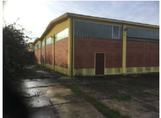
Foto 2 – Capannone artigianale – Lato nord-est
