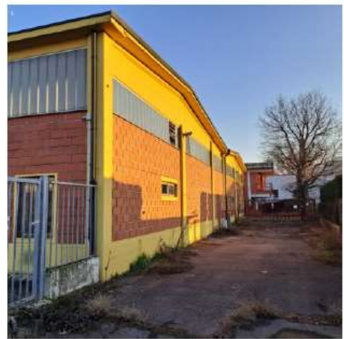
Foto 4 - Capannone artigianale – Lato ovest
