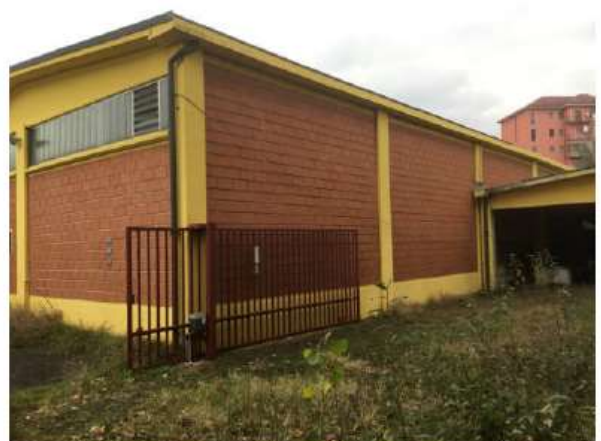
Foto 5 – Capannone artigianale – Lato sud
