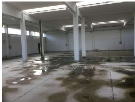
Foto 8 – Interno capannone – Parete est e sud
