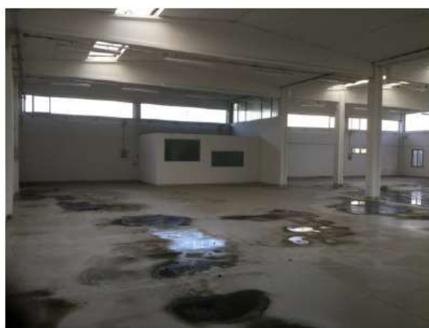
Foto 10 – Interno capannone – Parete ovest con uffici
