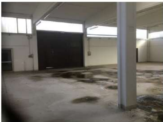
Foto 7 – Interno capannone – Porta carrabile
