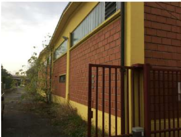
Foto 5 – Capannone artigianale – Lato ovest
