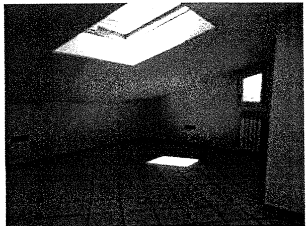
30- la zona soffitte
