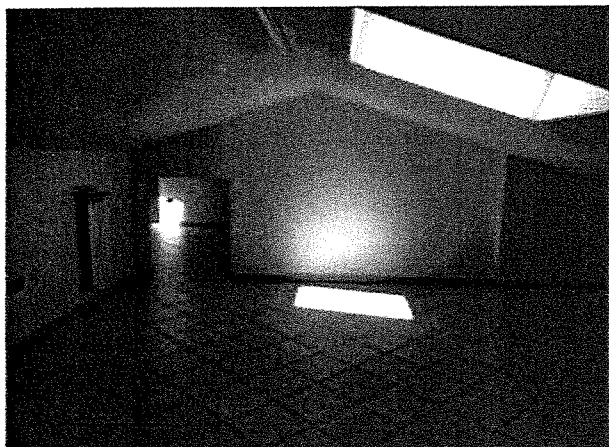
31- la zona soffitte
