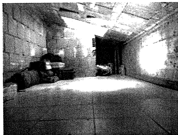
43- il deposito sottotetto
