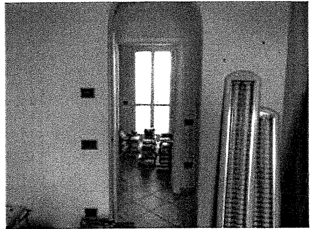
10- il disbrigo alla sinistra dell'ingresso
