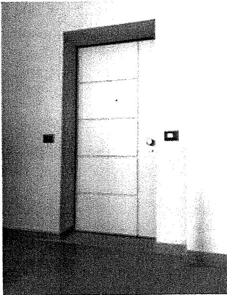
5- il portone d'ingresso al fabbricato
