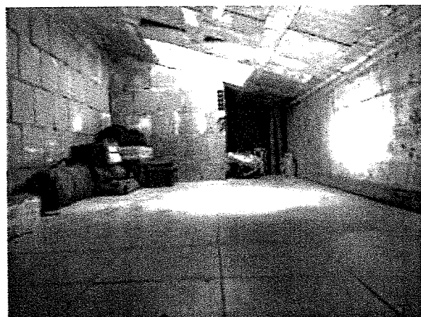
43- il deposito sottotetto
