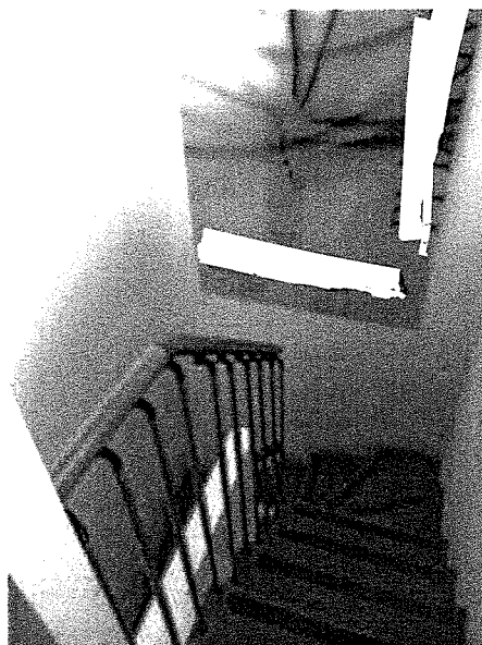
28- le scale di collegamento con il piano terreno
