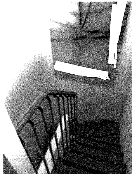
28- le scale di collegamento con il piano terreno
