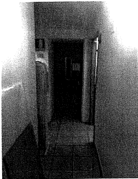
17- il disbrigo centrale al piano primo
