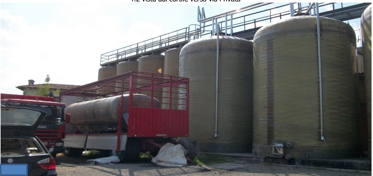
f.3 vista dal cortile silos di stoccaggio antistanti ai locali accessori
