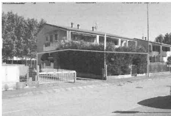
foto 2 - scorcio del fianco est e del prospetto nord della palazzina ovest del complesso in via M. Bonino visto da nord est con l'ingresso esclusivo del m.n. 614 sub 19 a piano terra al civ. n. 7 al centro della siepe fronte strada: al centro della foto si vede la rampa per l'accesso alle autorimesse con la sbarra sempre alzata
