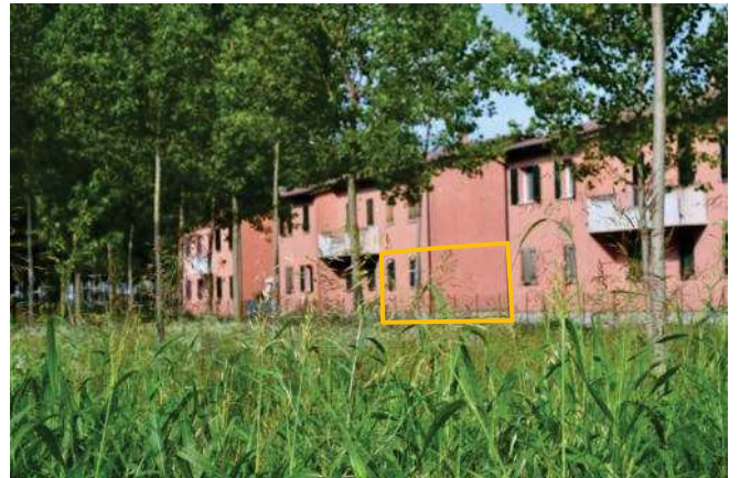
foto 6 - Prospetti sud degli edifici di via Bonino
