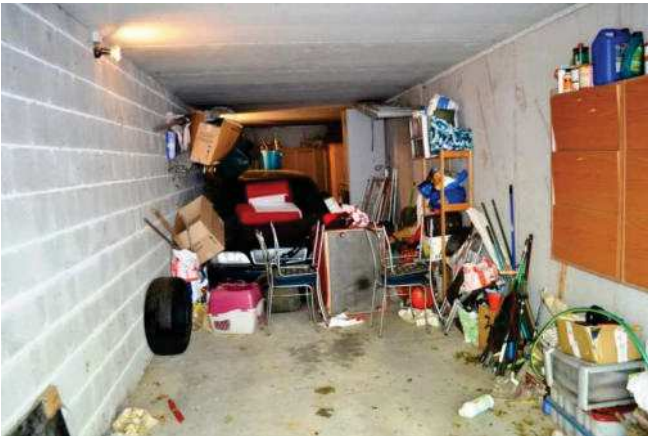
foto 18 - Vista interna dell'autorimessa e cantina
