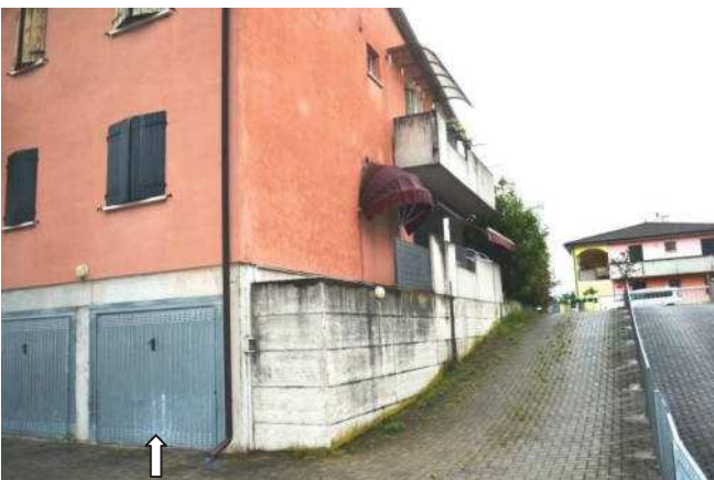
foto 19 - Scorcio dell'autorimessa con rampa esterna
