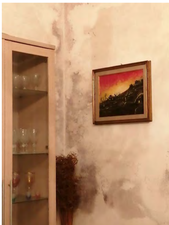
Foto 15-16 particolari della condensa in due punti angolari del salotto
