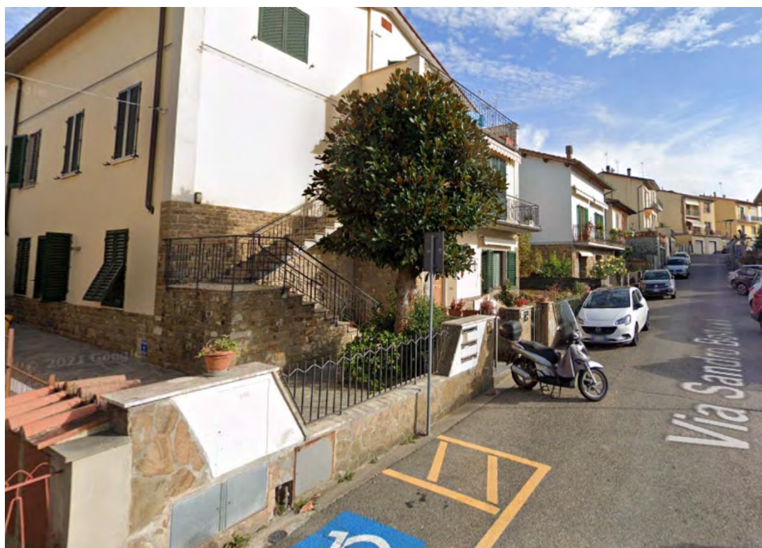
Foto 4 – Altra vista del fabbricato
