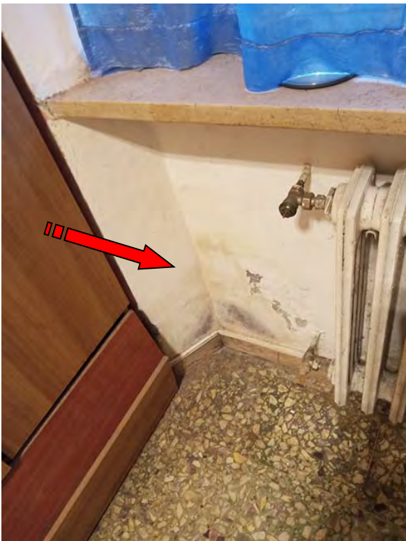
Foto 12 – Ancora muffe dovute a fenomeno di condensazione sotto la finestra. Foto 13 – il sottoscala
