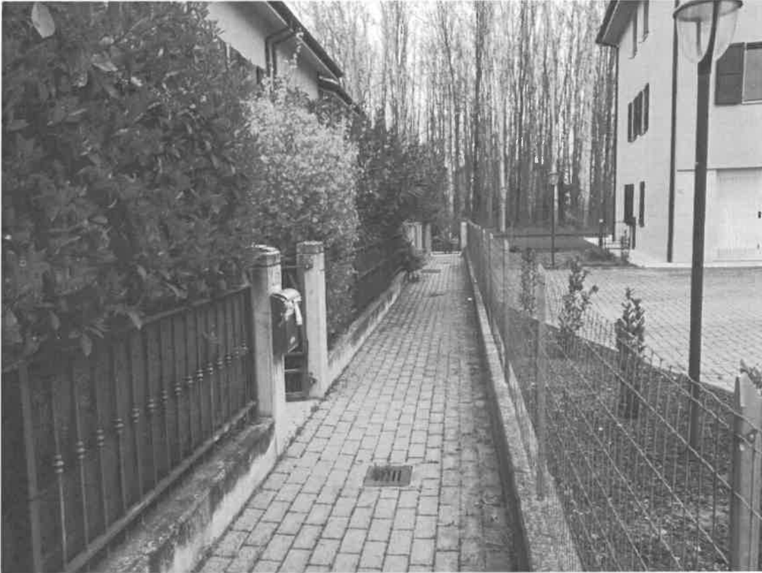
Lotto "2" / F2 - Stradello pedonale comune (Sub. 2) sul fronte Est delle villette
