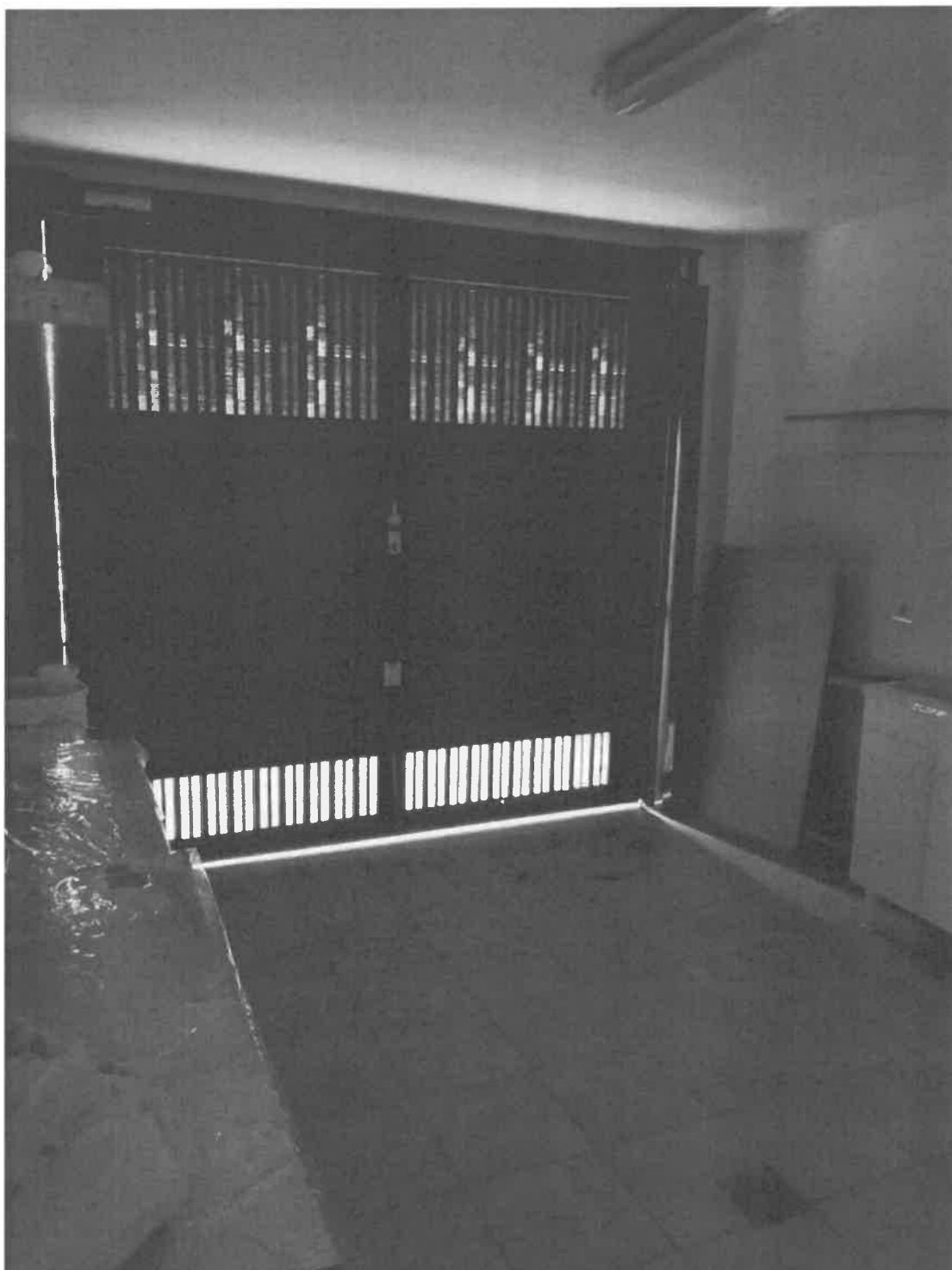
Lotto "1" / F6 - Interno dell'autorimessa pertinenziale
