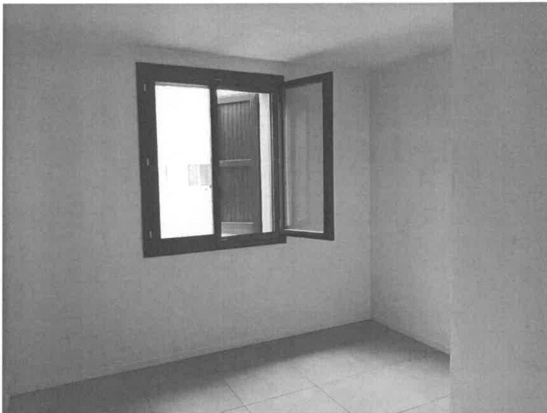
Lotto "2" / F9 - Camera da letto di fianco al vano scala
