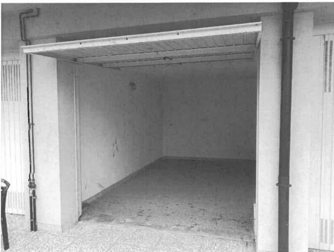
Lotto "3" / F3 - Particolare dell'autorimessa
