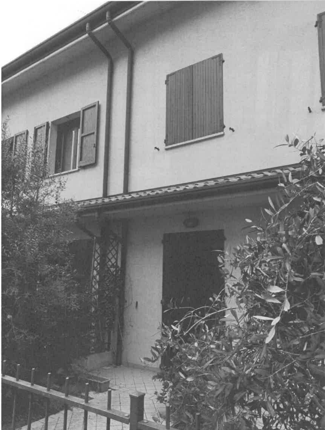
Lotto "2" / F4 - Fronte Est della villetta Sub. 8 dallo stradello pedonale comune
