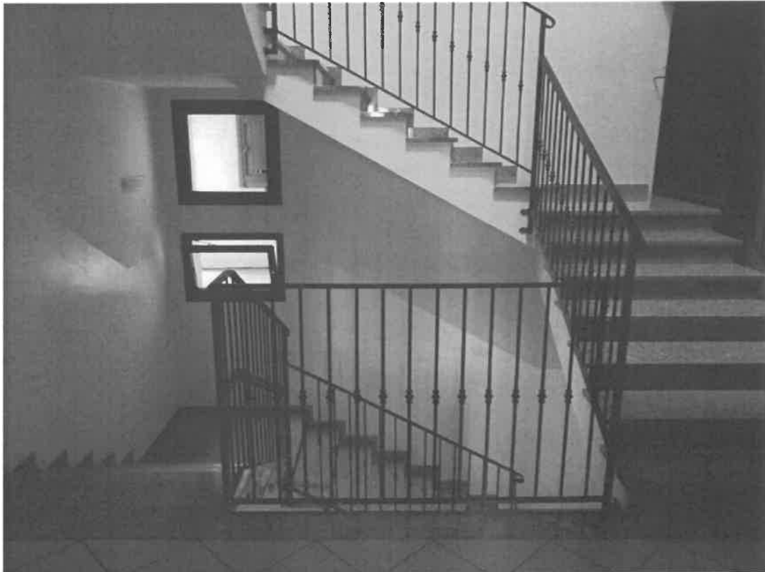
Lotto "3" / F4 - Vano scala condominiale
