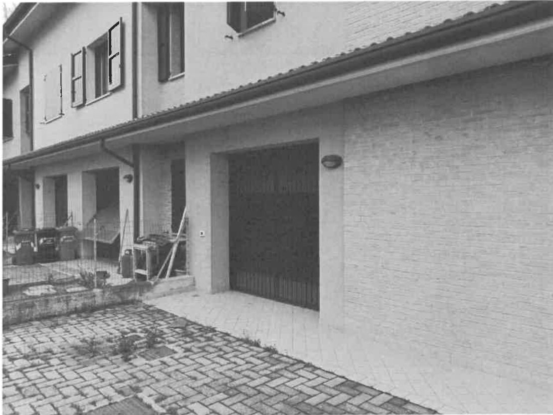
Lotto "1" / F2 - Portone di accesso all'autorimessa Sub. 3
