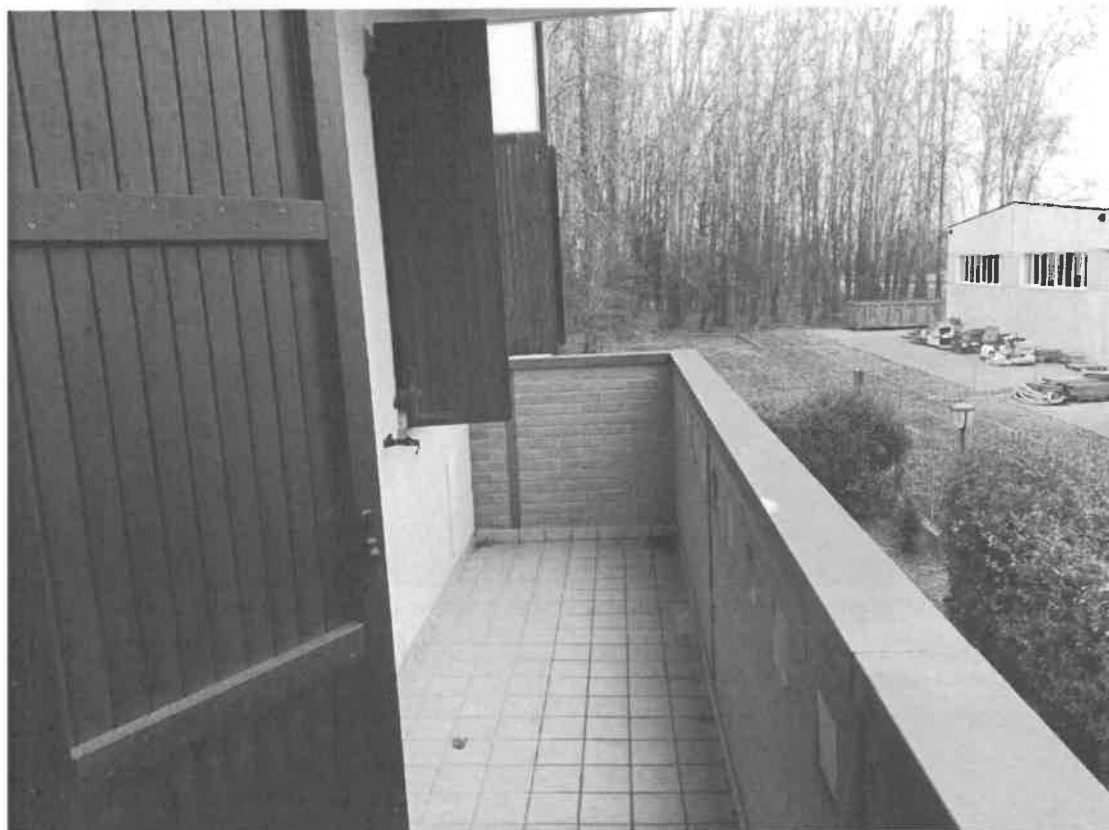
Lotto "3" / F9 - Balcone sul fronte Sud dell'appartamento
