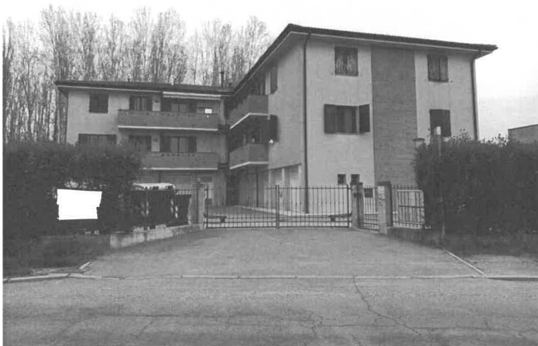
Lotto "4" / F1 - Vista di insieme del fabbricato al civico 389 di Via Furlana, nella cui area cortiliva sono localizzati i cinque posti auto scoperti in oggetto
