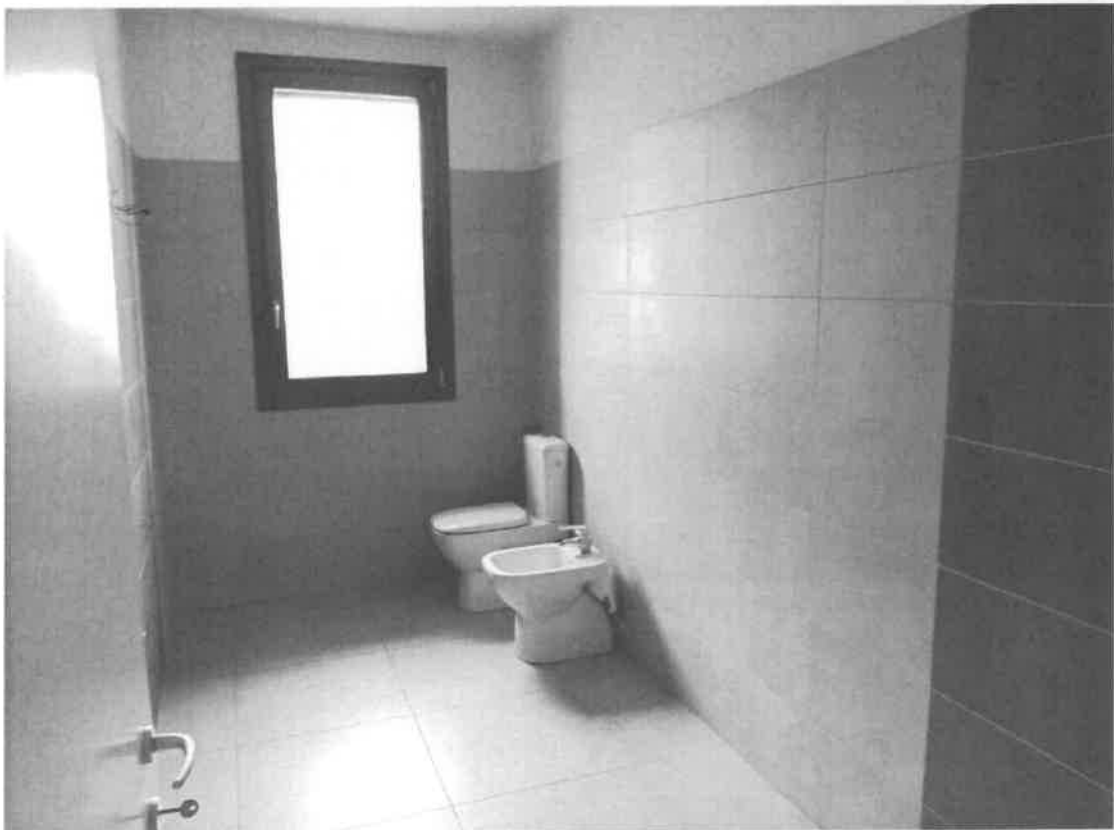
Lotto "2" / F12 - Bagno della zona notte al piano primo
