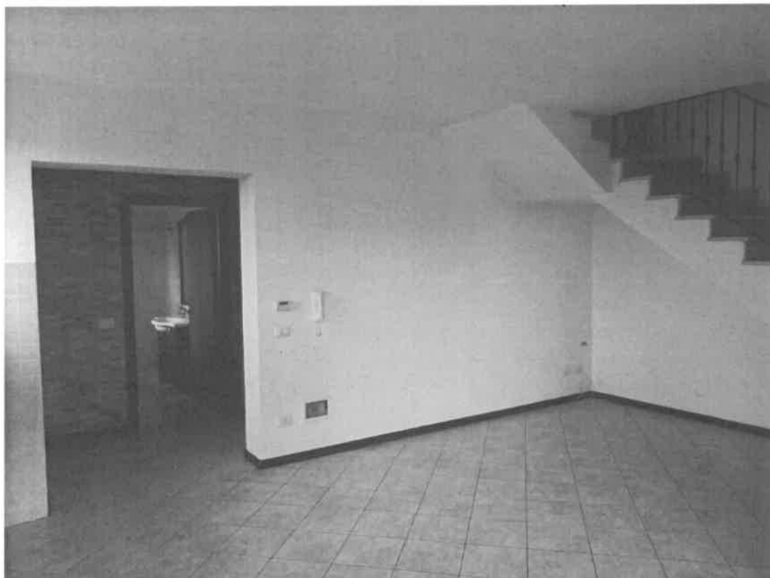
Lotto "1" / F9 - Vista di insieme della zona giorno verso l'ingresso e il bagno al P.T.
