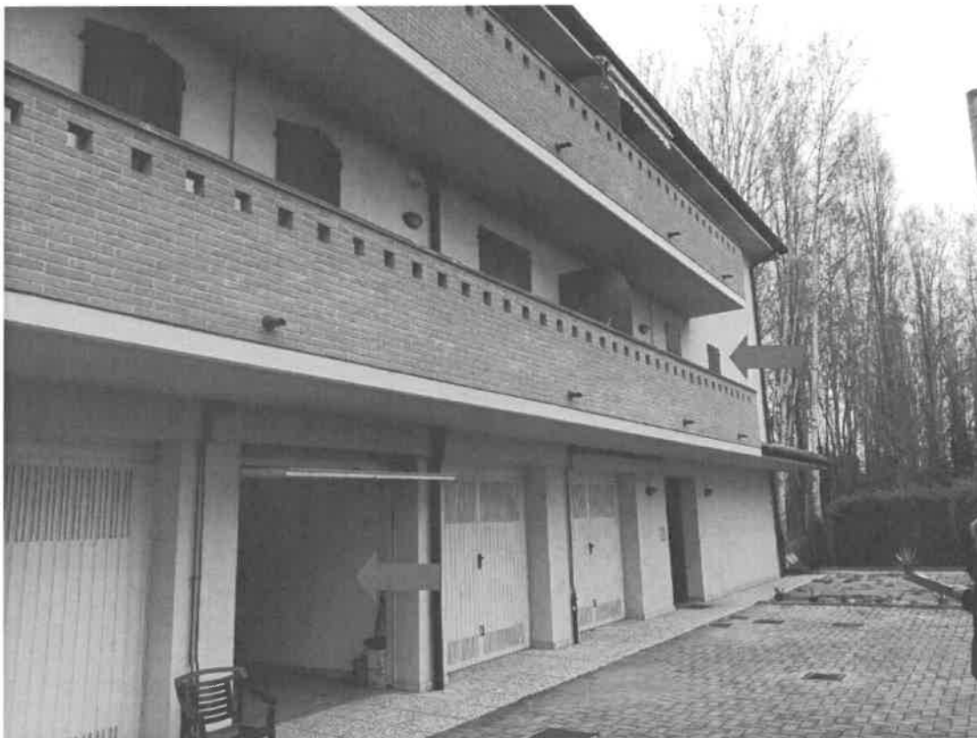
Lotto "3" / F2 - Fronte Sud del fabbricato con individuazione dell'autorimessa Sub. 28 al P.T. e dell'appartamento Sub. 35 al P.1
