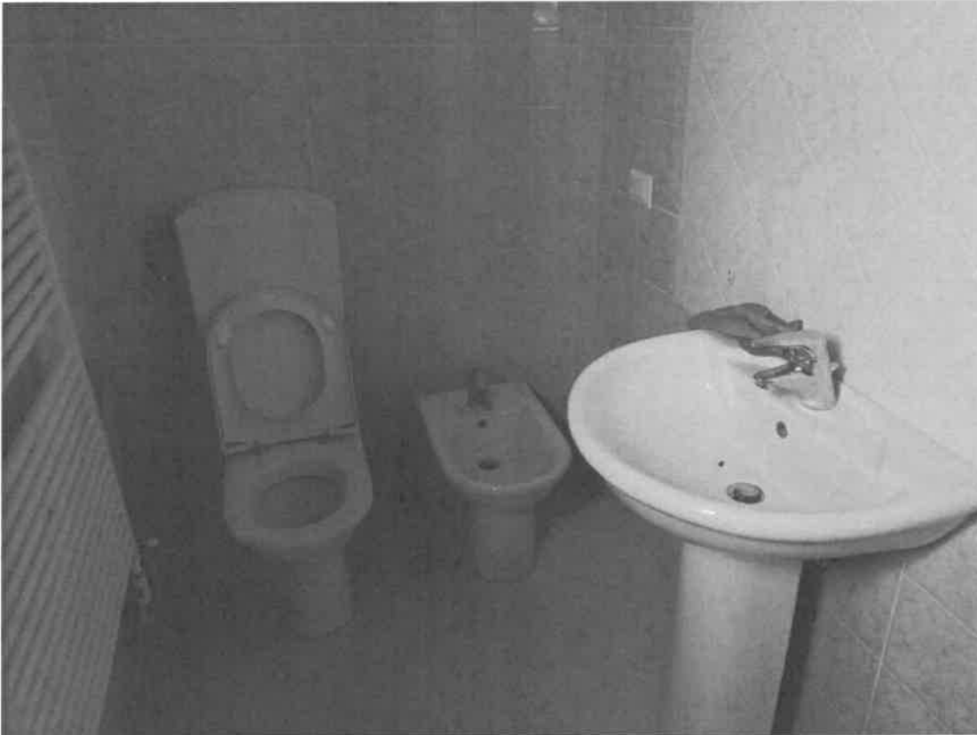
Lotto "1" / F15 - Bagno della zona notte al P.1
