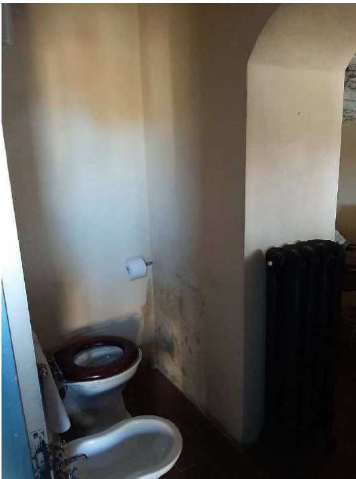
Foto 11 - Servizio igienico in sottoscala
