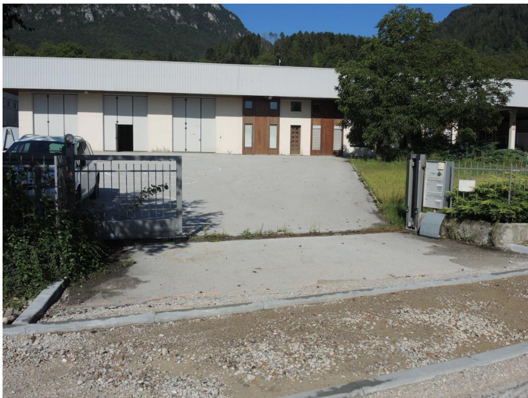
Vista del compendio dal cancello d'ingresso
