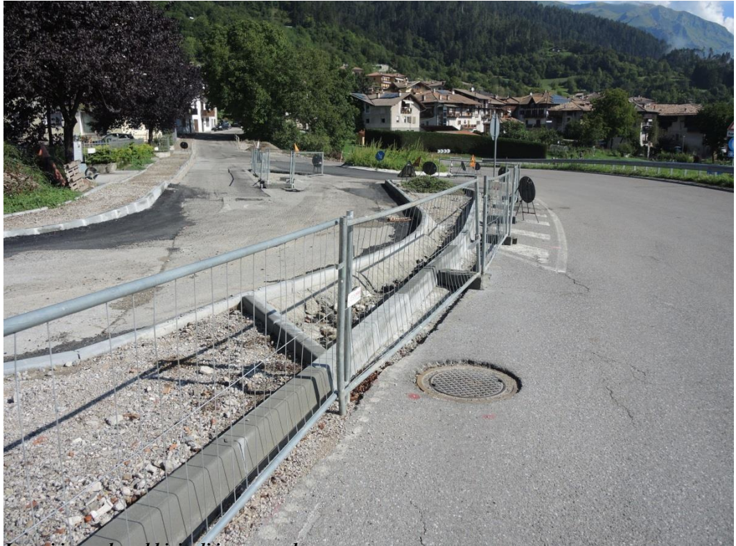
Lavori in cordo sul bivio di ingresso al capannone
