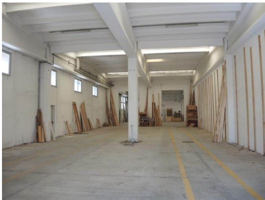
Deposito a piano terra
