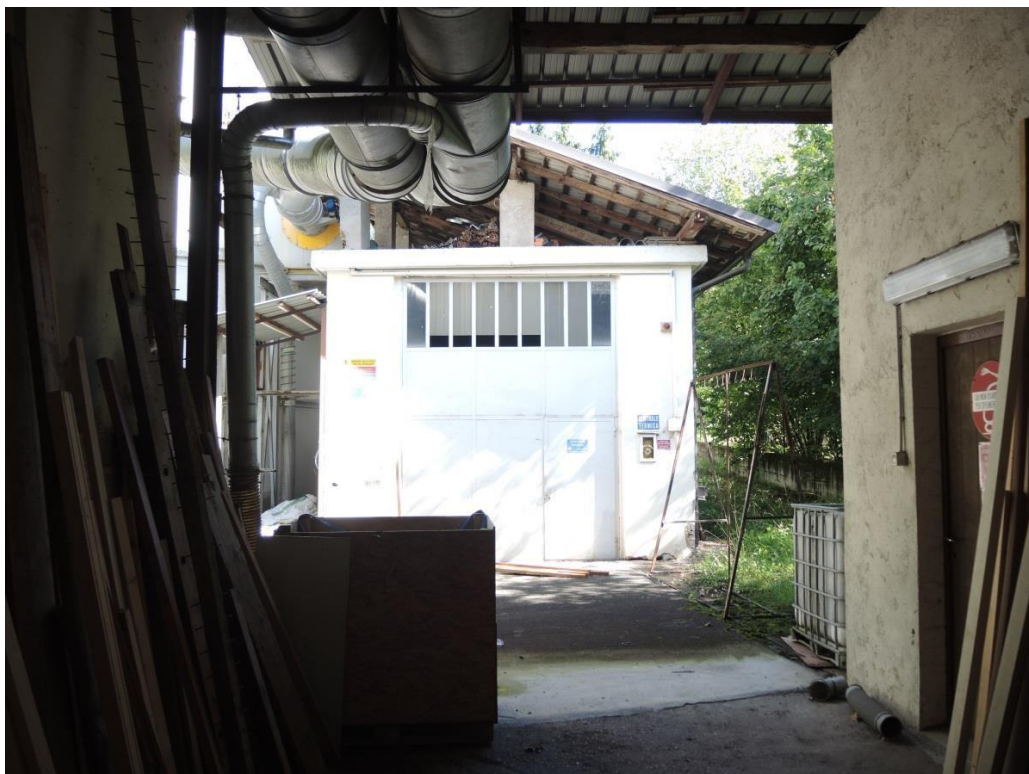
Cortile nord, vista sul locale centrale termica
