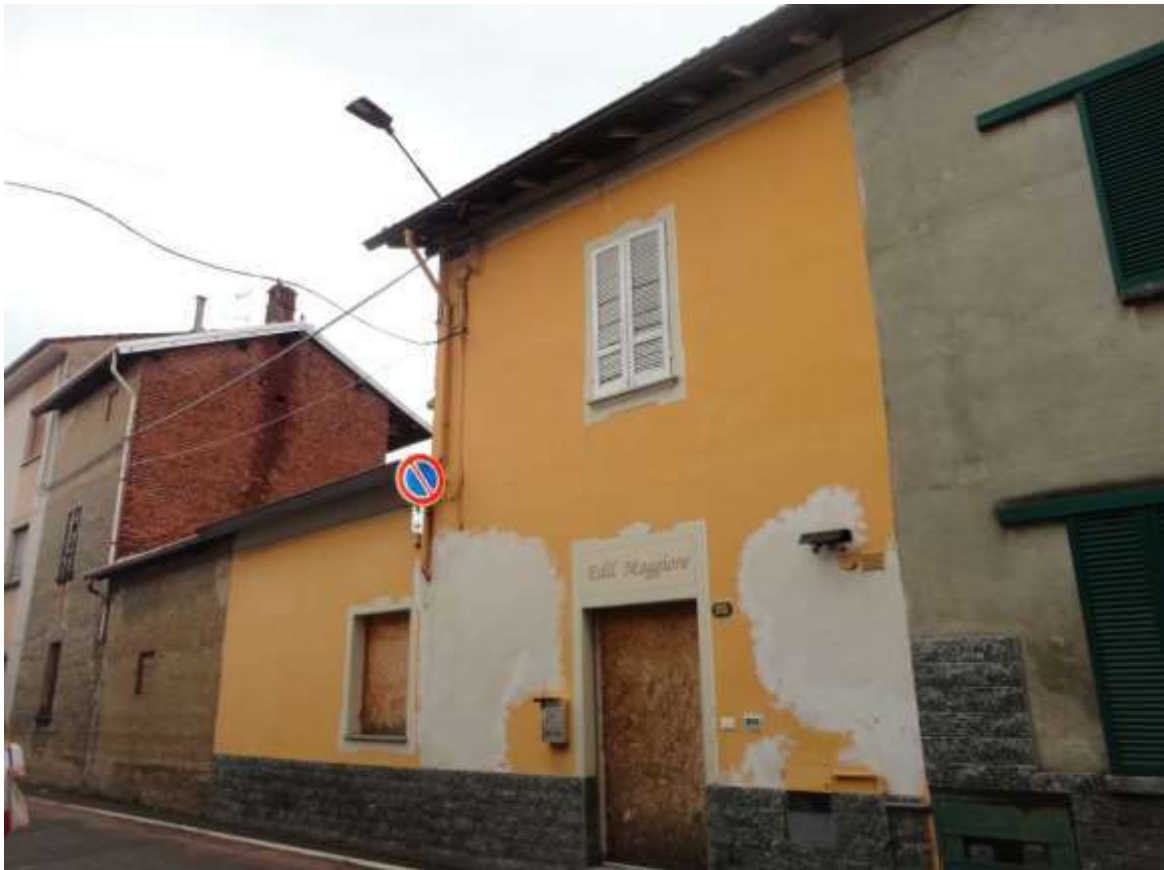
Foto 1: Vista esterna ingresso pedonale da via Ticino, 2D Foglio 16 mappale 1502 sub 4, sub 5 e sub 8
