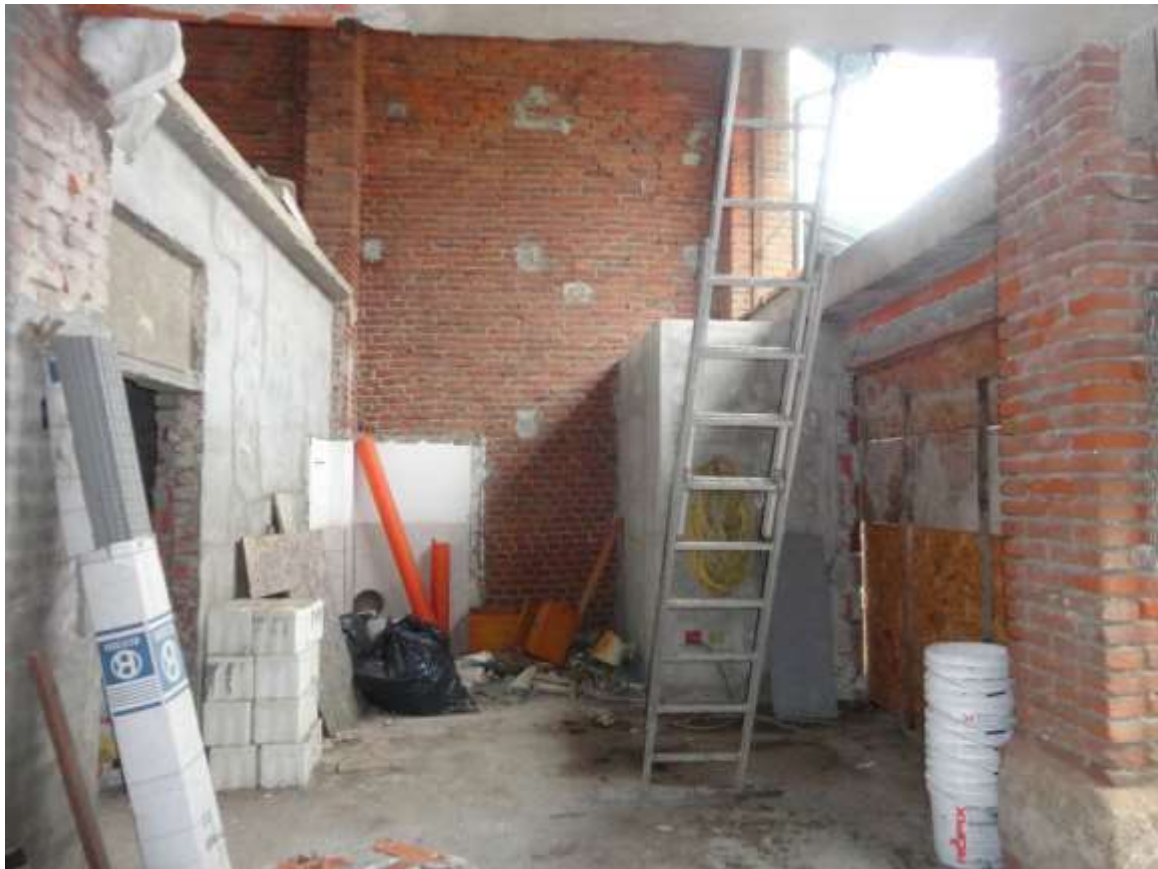
Foto 16: Vista interna autorimessa – Piano Terra Foglio 16 mappale 1502 sub 6
