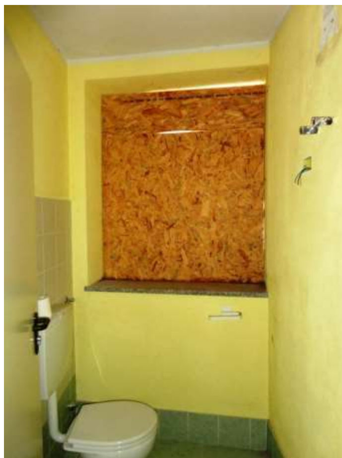
Foto 8: Vista interna bagno – Piano Terra Foglio 16 mappale 1502, sub 4
