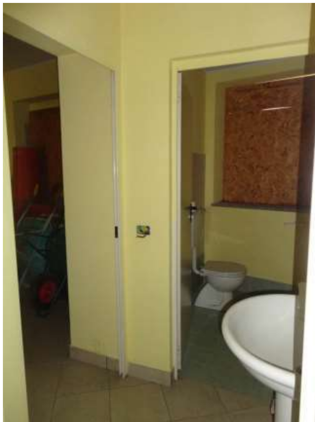
Foto 7: Vista interna antibagno e bagno – Piano Terra Foglio 16 mappale 1502, sub 4
