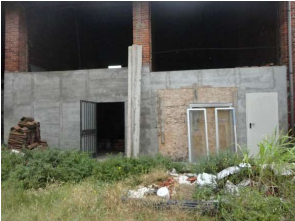
Foto 14: Vista esterna autorimessa – Piano Terra Foglio 16 mappale 1502 sub 6
