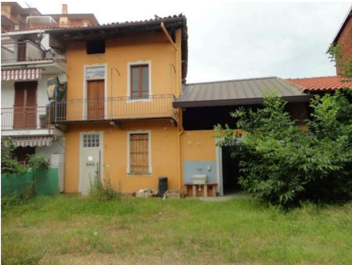
Foto 2: Vista interna dal cortile – Via Cameri, 3 Foglio 16 mappale 1502 sub 4, sub 5 e sub 8
