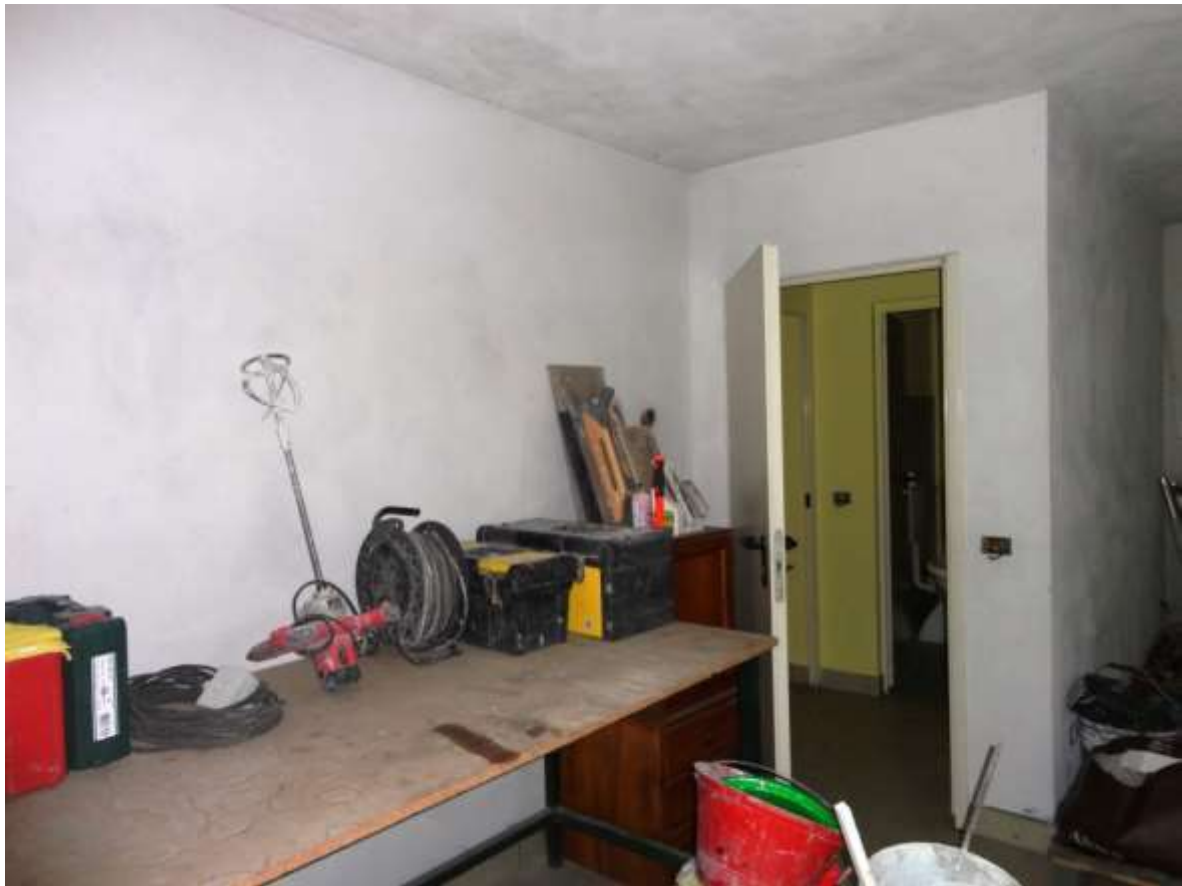
Foto 13: Vista interna autorimessa Foglio 16 mappale 1502, sub 5
