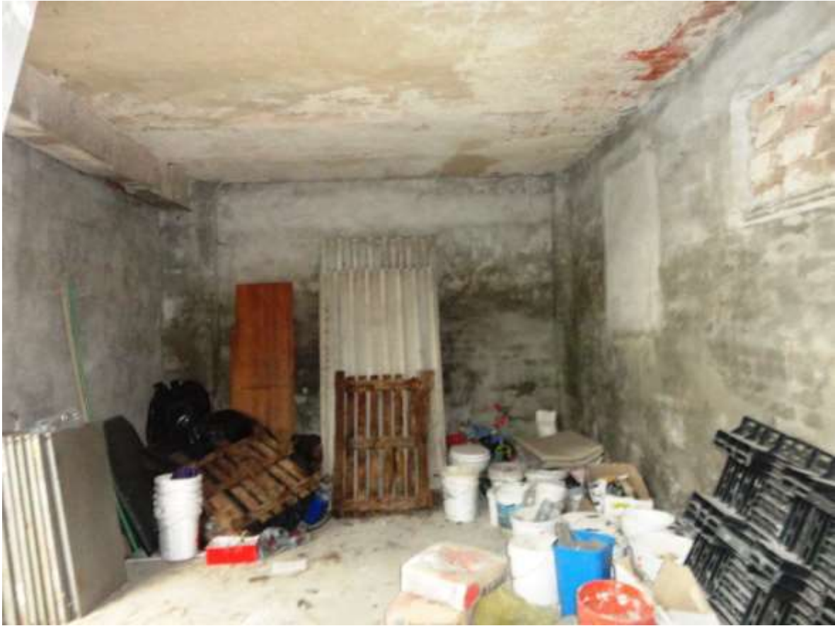
Foto 15: Vista interna autorimessa – Piano Terra Foglio 16 mappale 1502 sub 6
