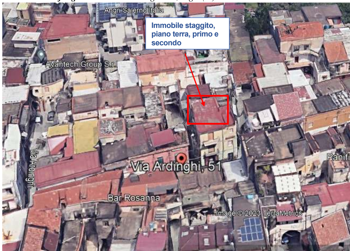
FOTO 2 aerofotogrammetria Via Ardinghi n.51, Angri (Sa)
