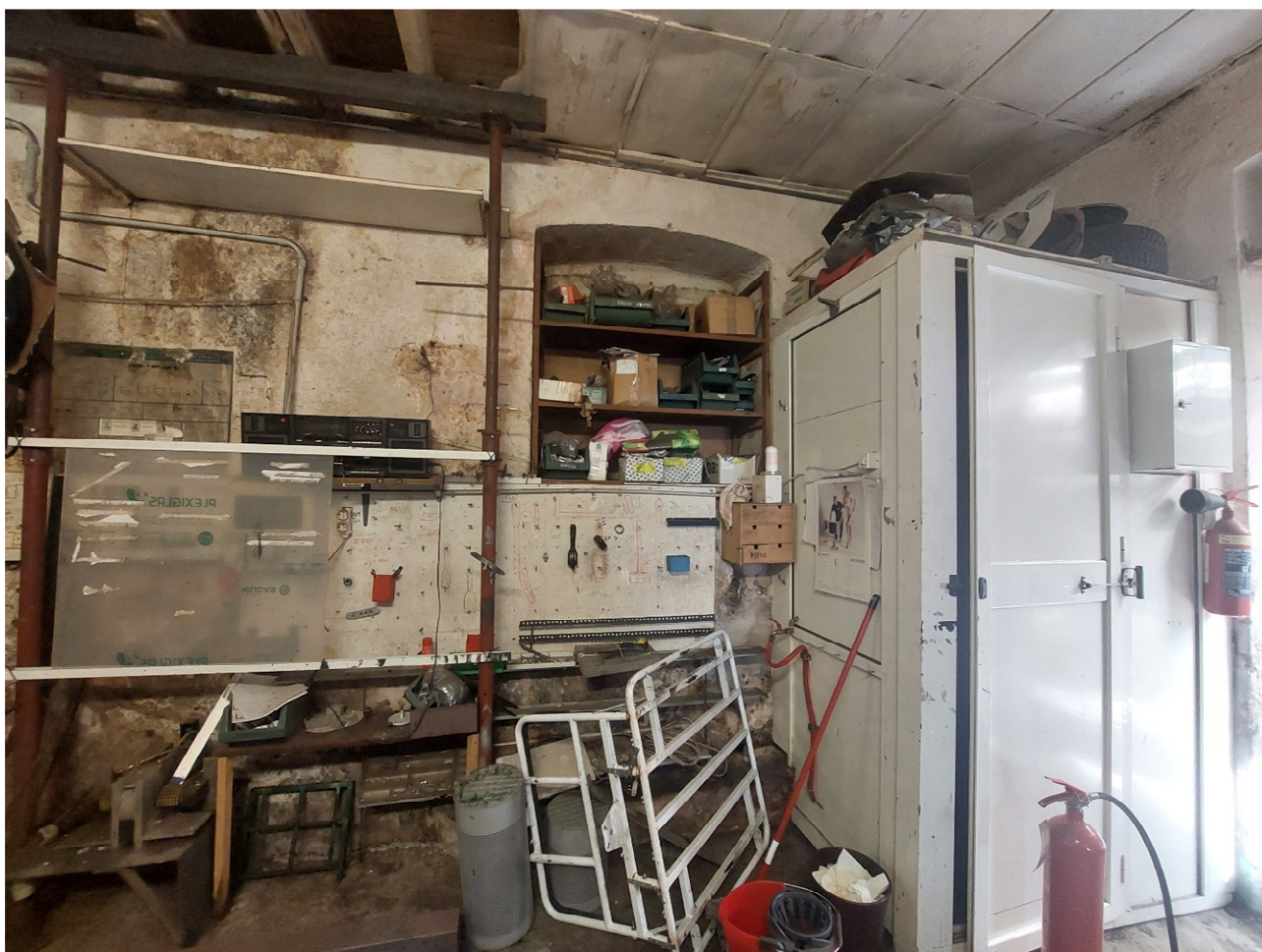
FOTO 6: vano retrobottega - vista verso il servizio igienico
