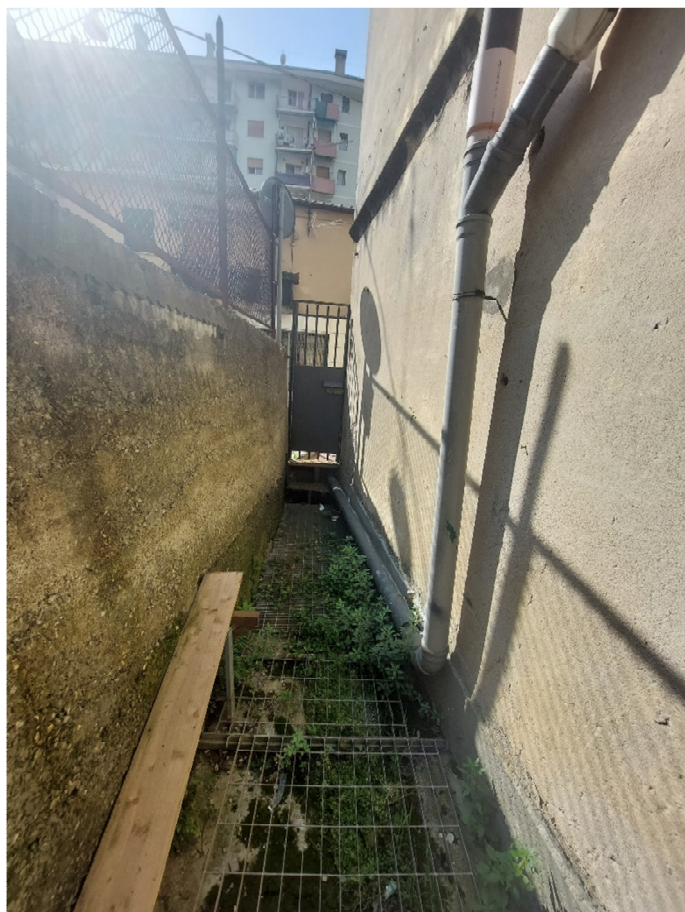
FOTO 12: cortile esterno: vista verso la via Pinetti
