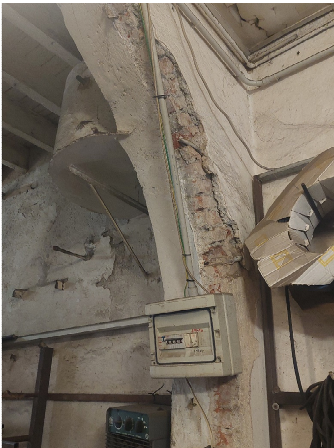
FOTO 8: particolare del varco
