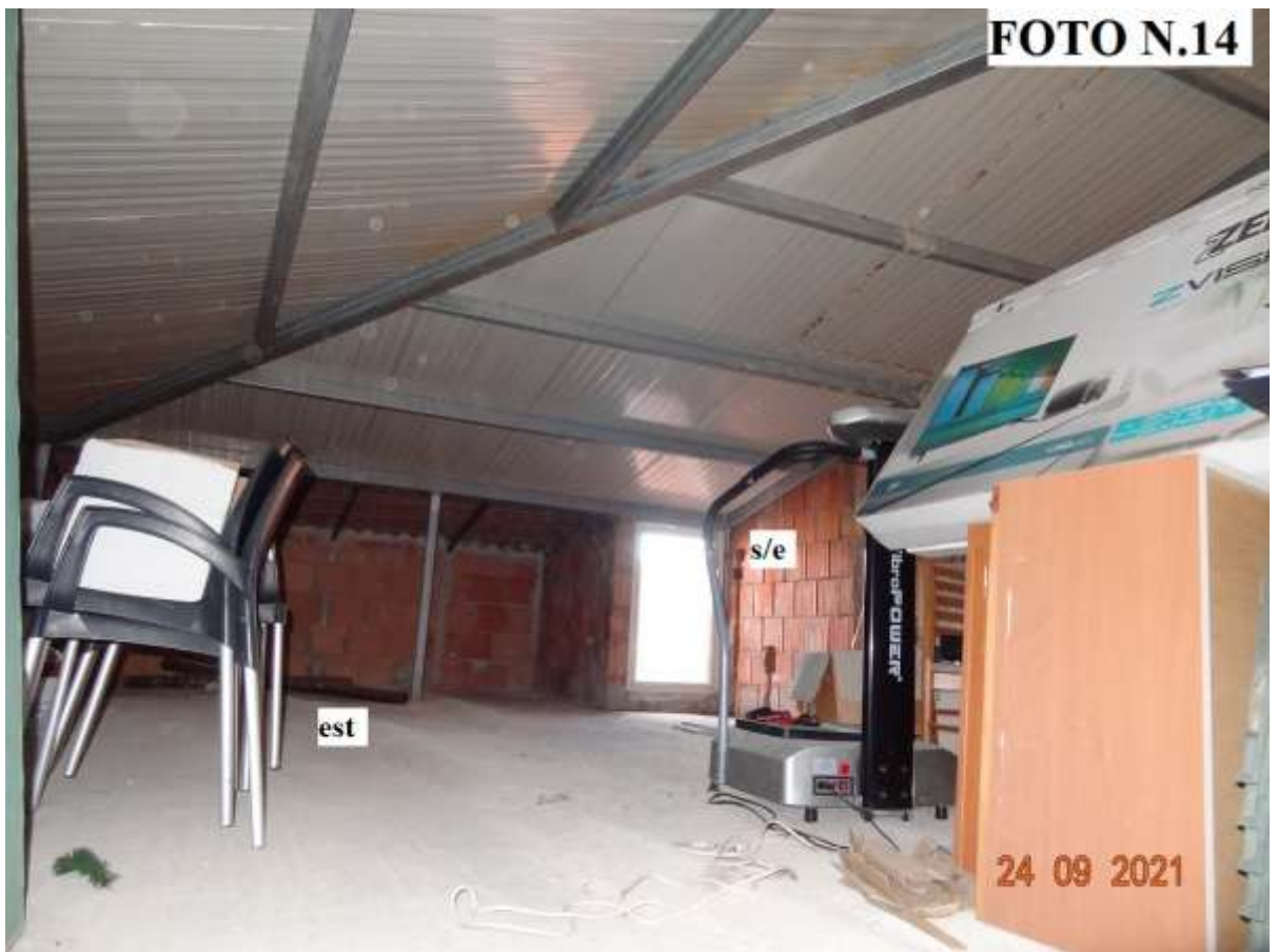
accesso al locale di sgombero sub.7
