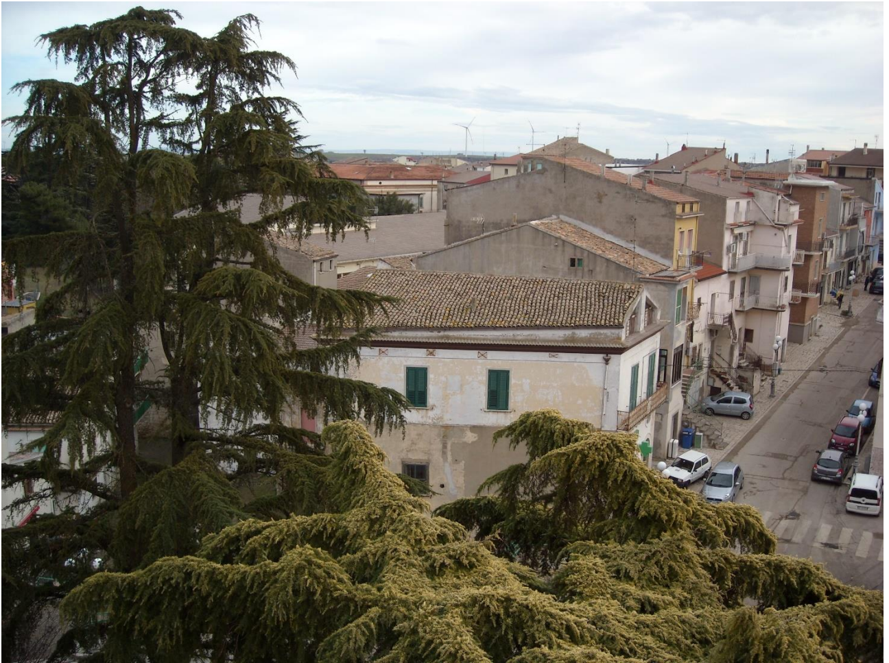
Vista dall'alto dell'immobile
