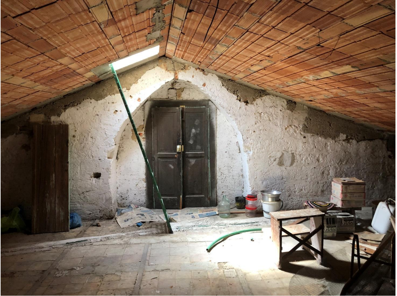
Soffitta lato Est
