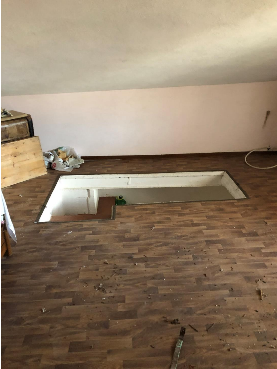
Accesso al sottotetto
