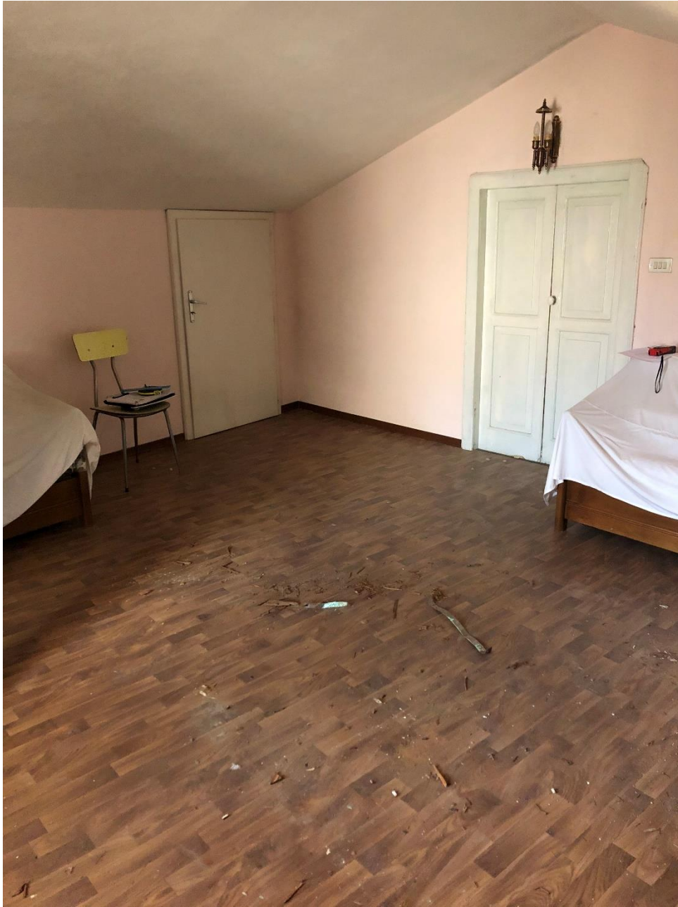
Vista lato deposito e soffitta
