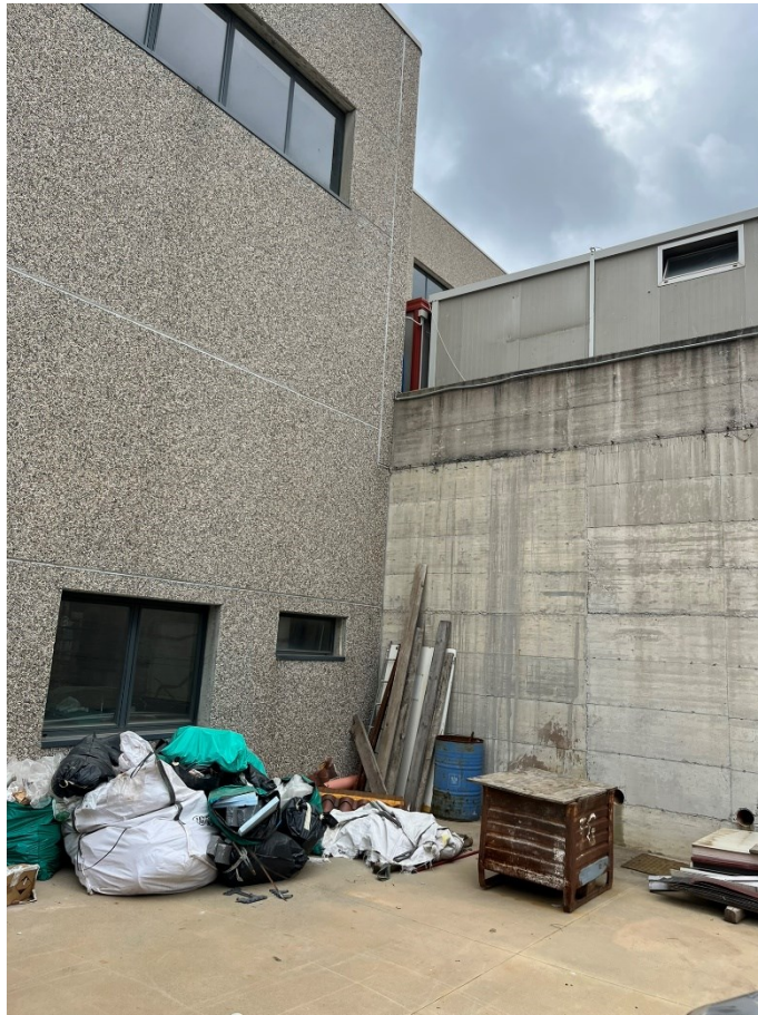
Foto n.3 – Panoramica area esterna deposito commerciale
