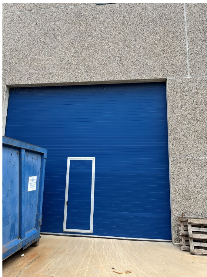
Foto n.2 – Particolare accesso deposito commerciale
