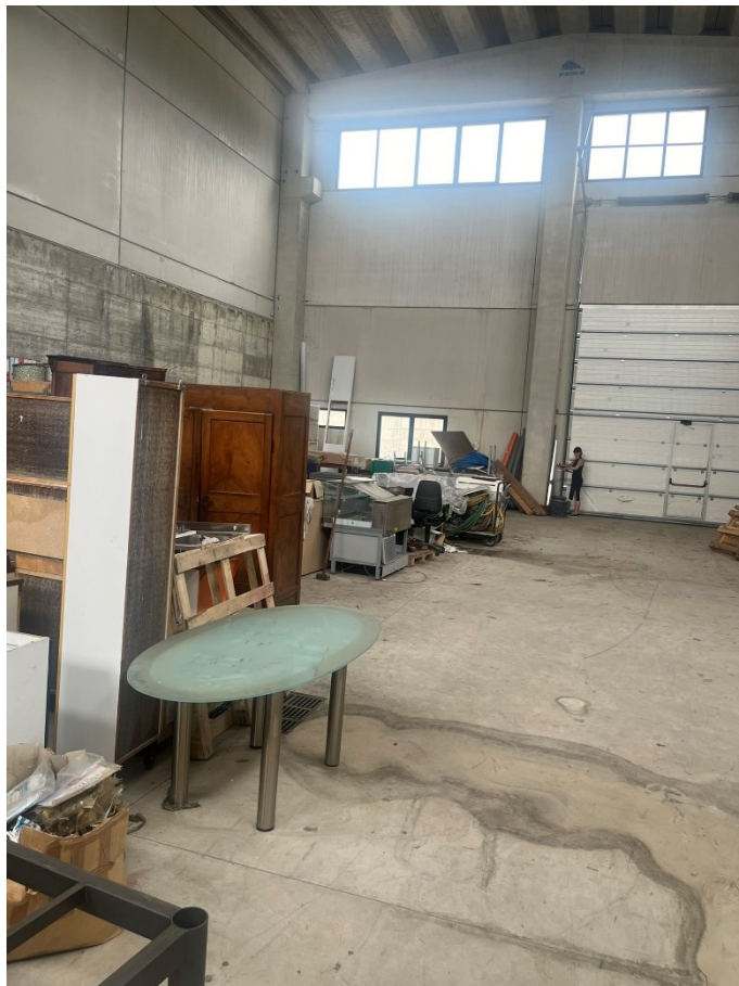
Foto n.4 – Particolare deposito commerciale
