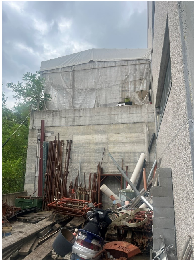
Foto n.7 – Panoramica 2° area esterna deposito commerciale
