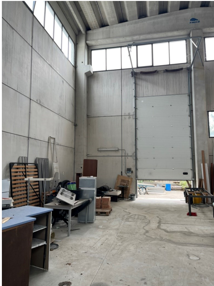
Foto n.5 – Particolare deposito commerciale
