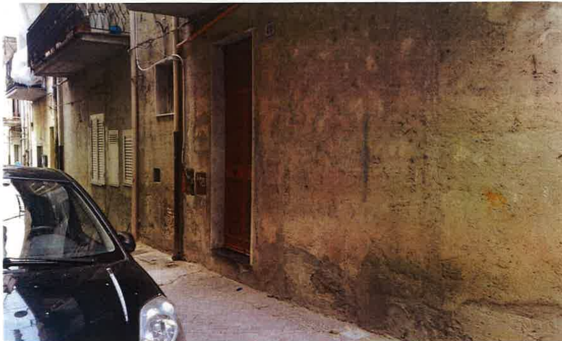
Foto n.1: Prospetto su Via Penaro
