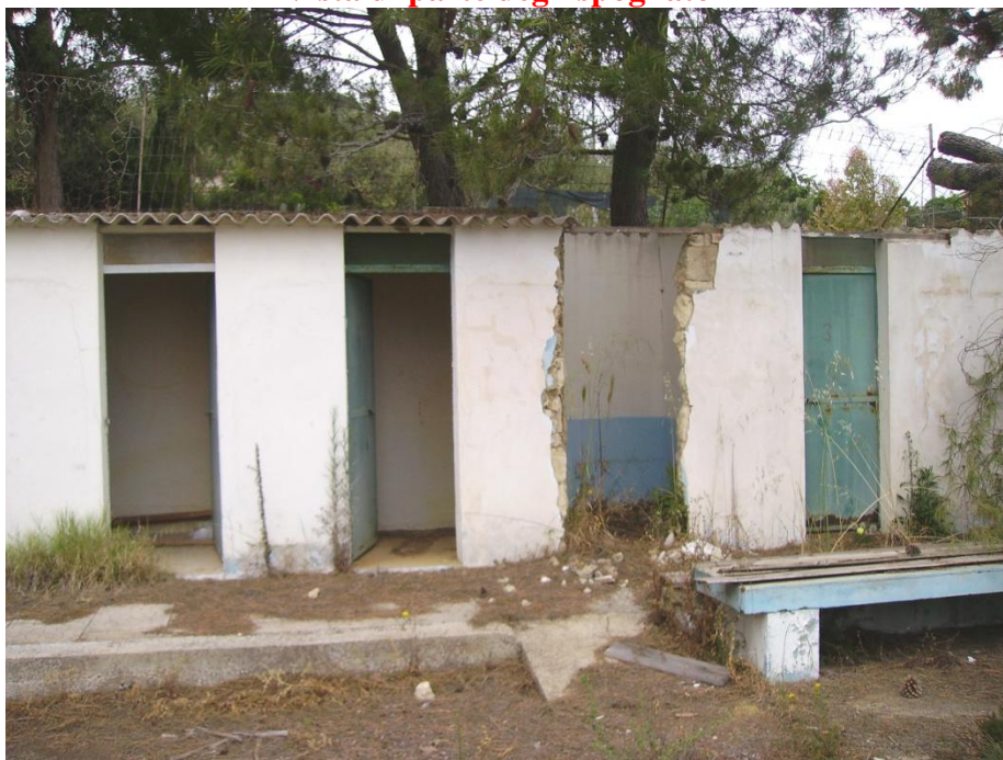
Vista di parte degli spogliatoi
