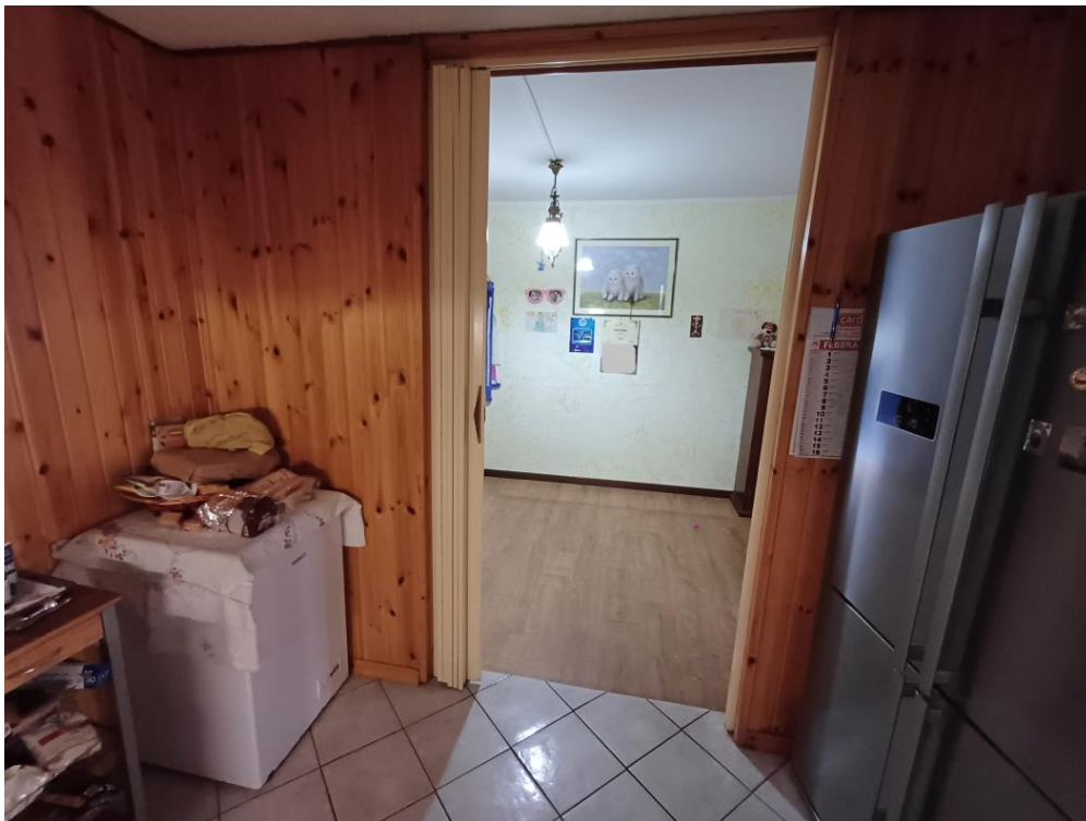
Foto 11 – Vista verso locale non licenziato come abitabile al piano terra
